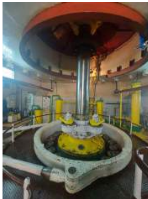
Slika 3.10 –HE „Vrla 4“ predturbinski zatvarač i turbina
