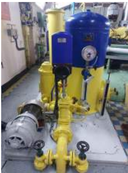
Slika 3.11 –Sistem turbinske regulacije na HE „Vrla 2“
