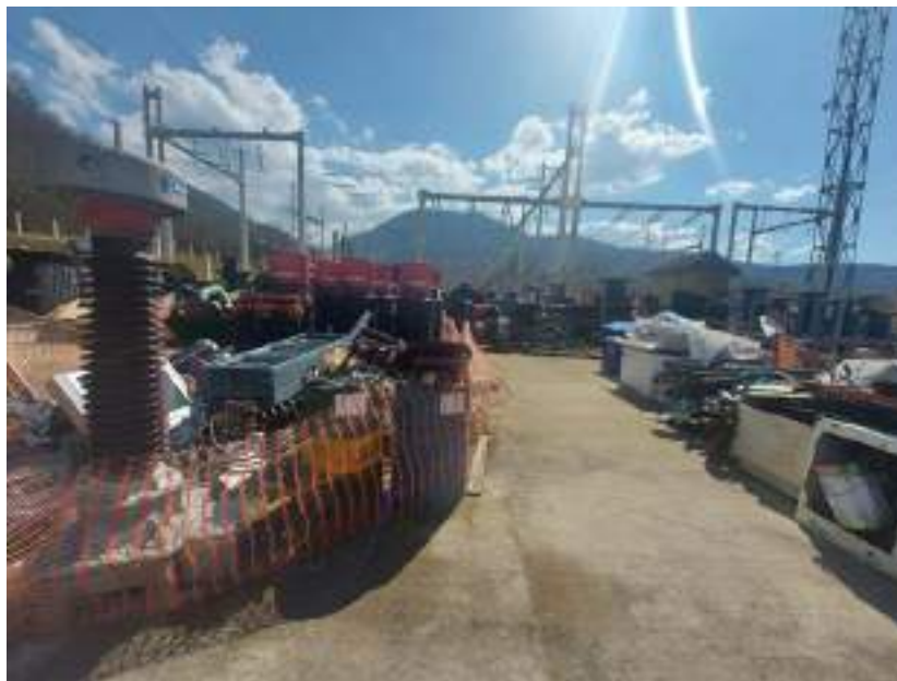
Slika 3.13 –Centralno skladište za odlaganje neopasnog otpada na HE "Vrla 3"
