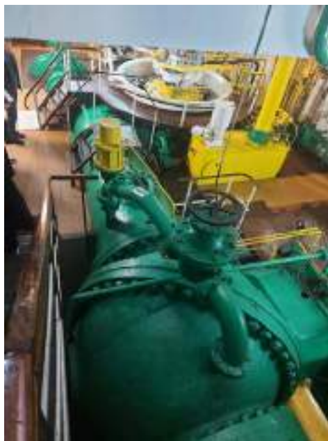
Slika 3.10 –HE „Vrla 4“ predturbinski zatvarač i turbina
