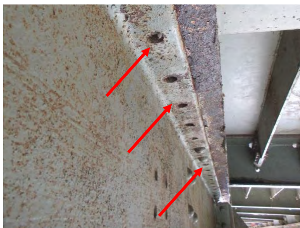
Недостају завртњеви на вези горње фланше носача 5 и орто-плоче у пољу 5-4'
