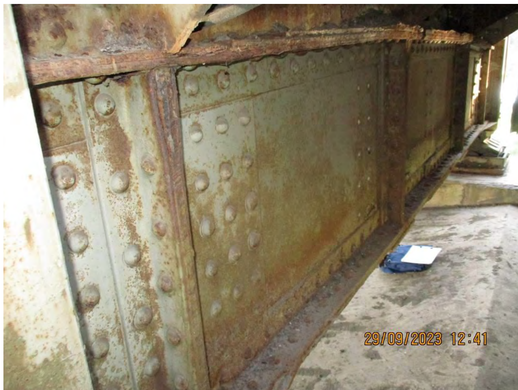
Попречни носач ПНО - страна ка конструкцији К2
