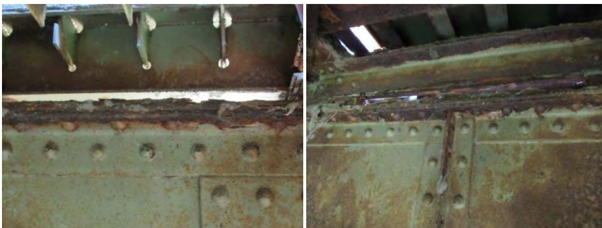
Попречни носач ПН0' ка ПН1' - дубинска корозија горњих појасних угаоника, за сада без већих деградација
