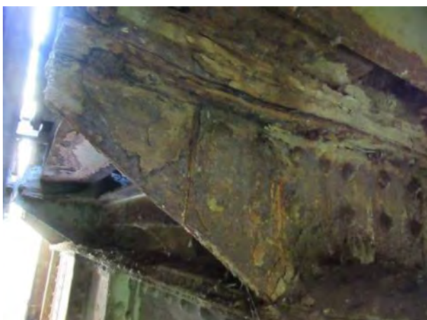
Конзоле подужних носача код попречног носача ПНО'
