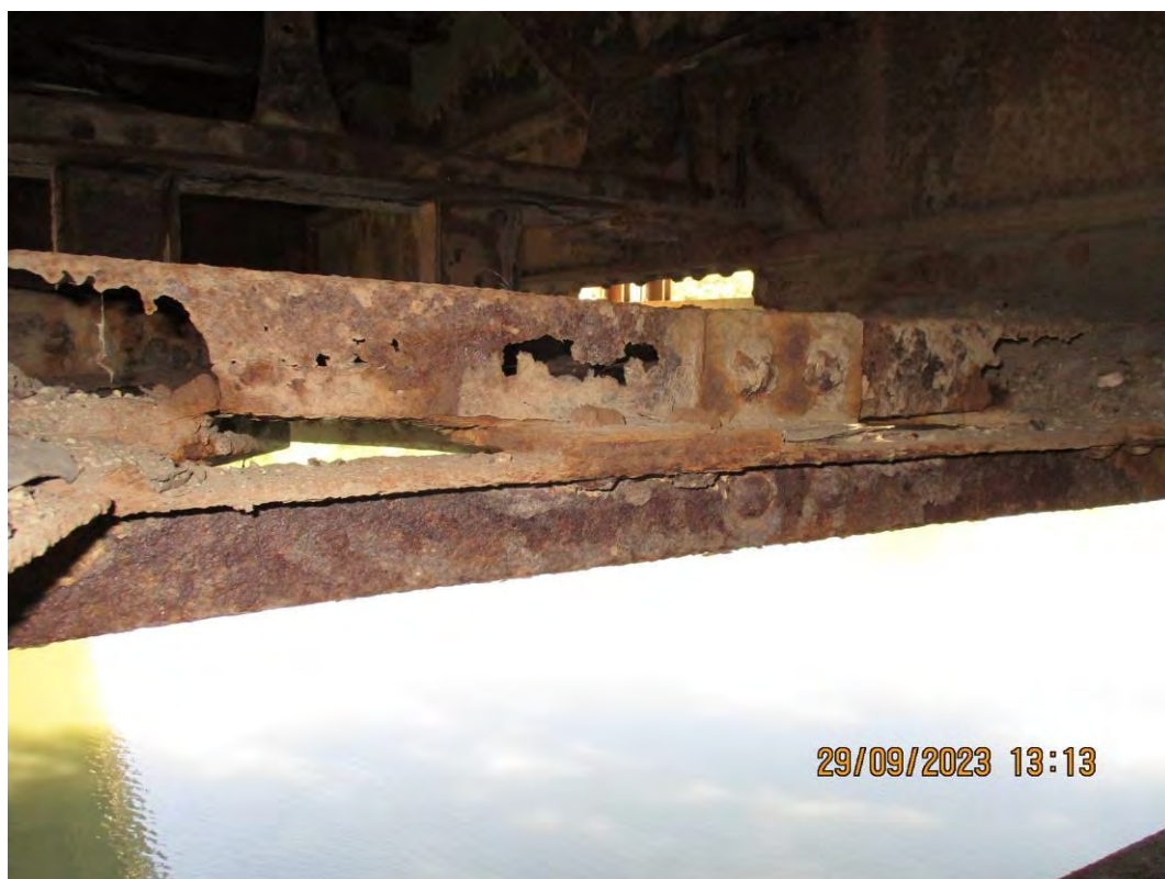
Вертикала спрега за кочење у првом пољу конструкције К3
