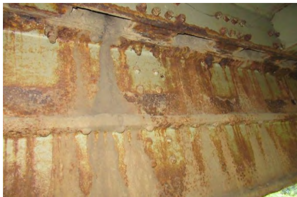
Лоше стање горње ножице и закивака на споју два носача
