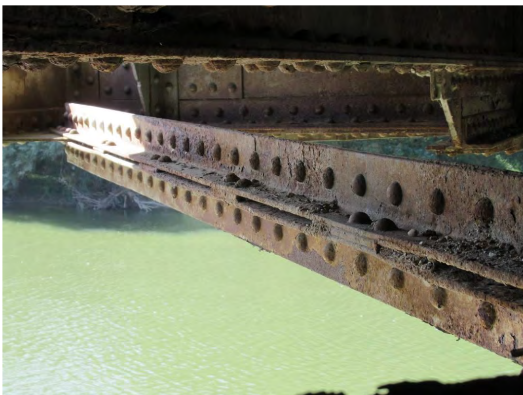
Дубинска корозија елемената и спојних средстава доњег спрега за ветар у крајњем пољу
