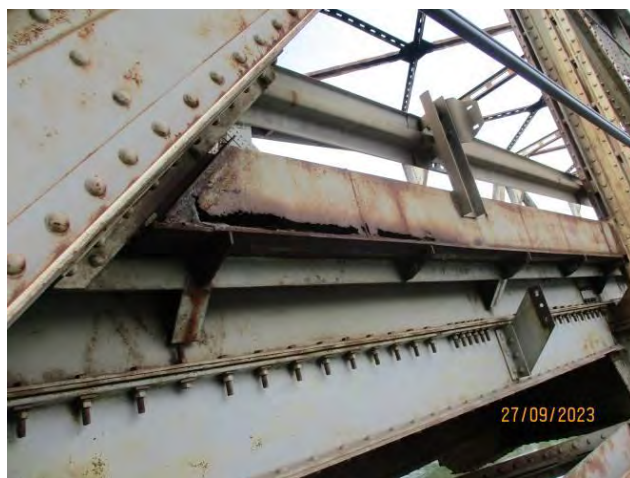
Велика оштећења челика десног ивичњака у зонама усецања ивичњака код ојачаних дијагонала
