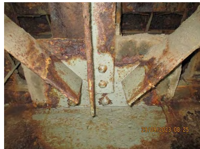
Дубинска корозија са умањењем основног пресека површине чворних лимова спрега за бочне ударе
