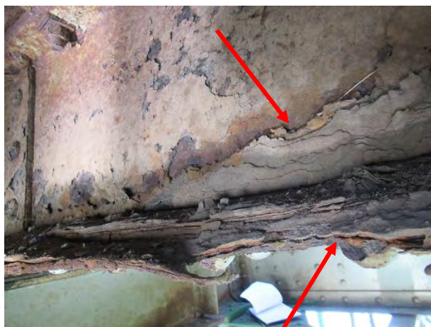
Дубинска корозија доње фланше и губитак попречног пресека носача 3 у пољу 0-1
