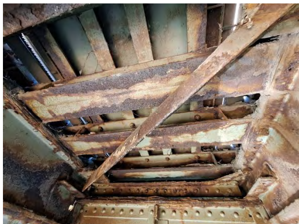
Површинска корозија - средњи монтажни комад орто-плоче
