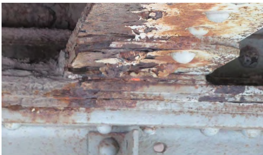
Локална дубинска корозија ламела горње ножице попречних носача у зонама ослањања подужних носача
