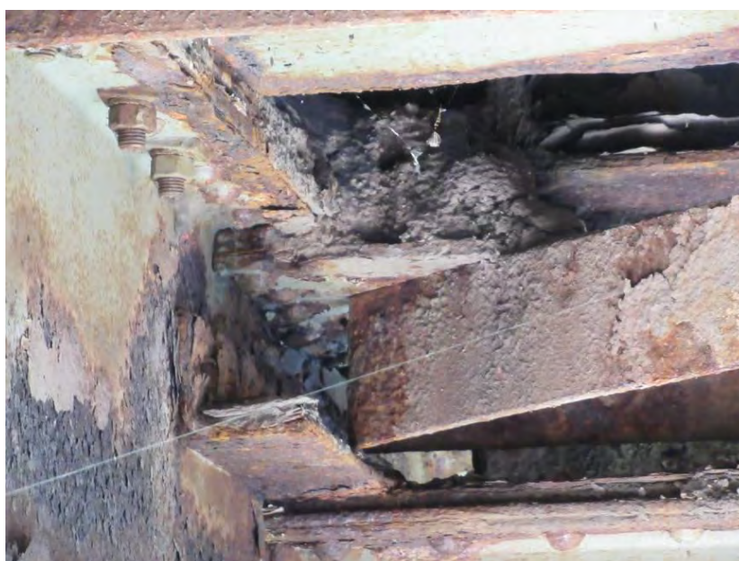
Депонованье земљаног материјала на чворним лимовима спрега за бочне ударе
