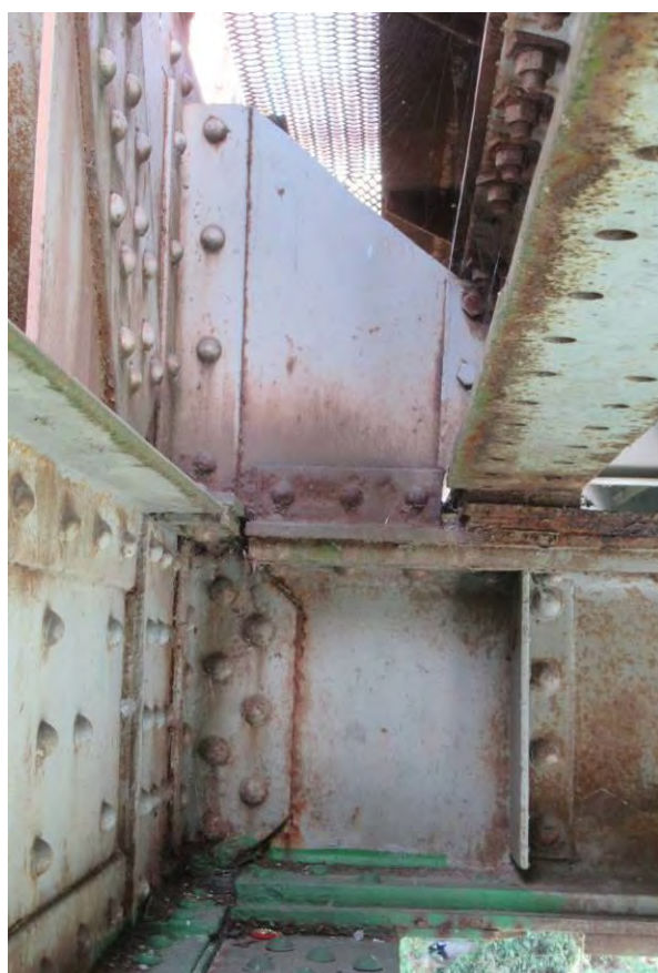
Површинска корозија попречних носача у зонама везе са главним носачима
