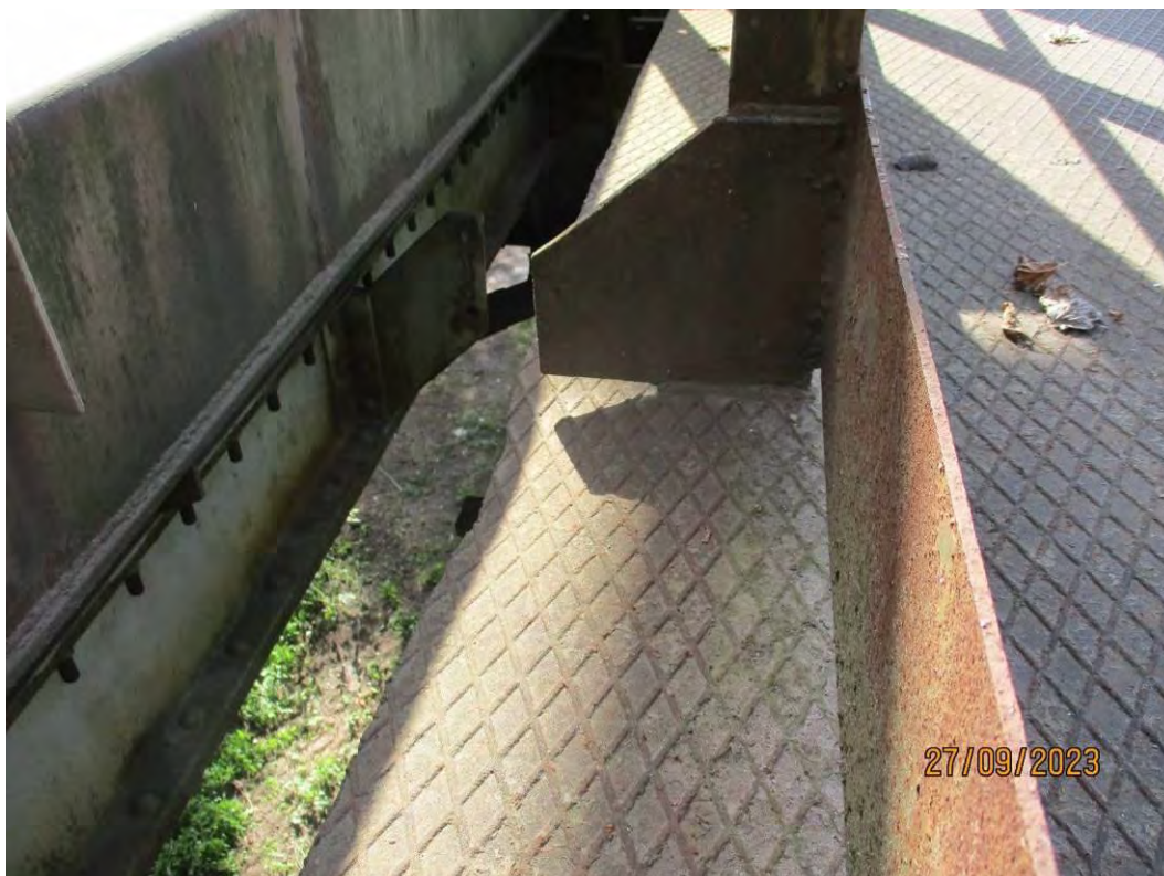
Некомплетан вар на вези стуба ограде игазишта у средини распона конструкције К1
