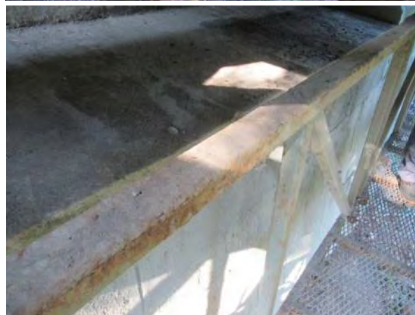
Изражена корозија средњег дела ревизионих колица, АКЗ тотално ван функције
