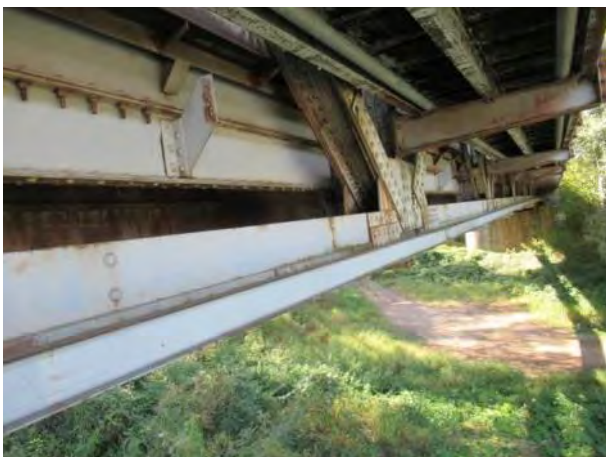
Шине и кратке конзоле генерално у добром стању
