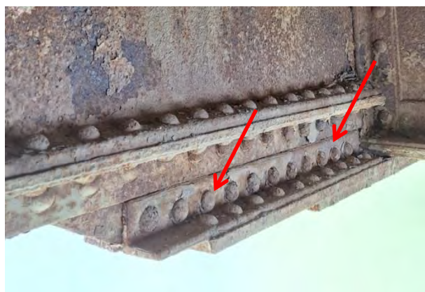
Зона континуитета десног (узводног) подужног носача код попречног носача ПН3' - дубинска корозија доњег угаоника, вертикалног лима и угаоника
