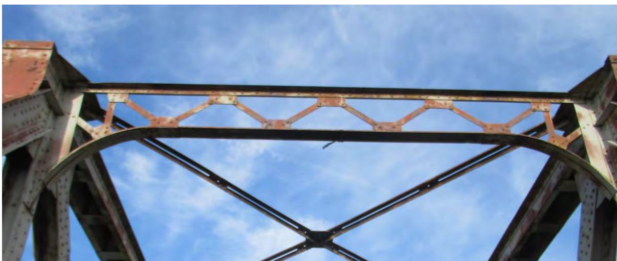
Улазни портални рам конструкције K4
