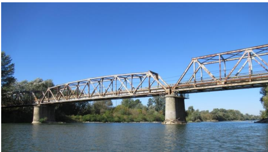
Слика 7 - Изглед конструкција са узводне стране
