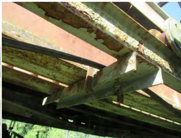
Шине и кратке конзоле генерално у добром стању, површинска корозија
