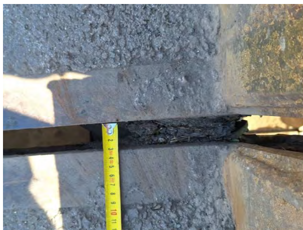
Зазор дилатације
