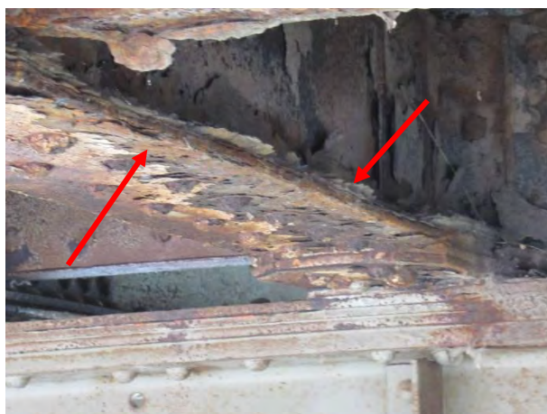
Дубинска корозија доње фланше и губитак попречног пресека носача 4 у пољу 5-4'
