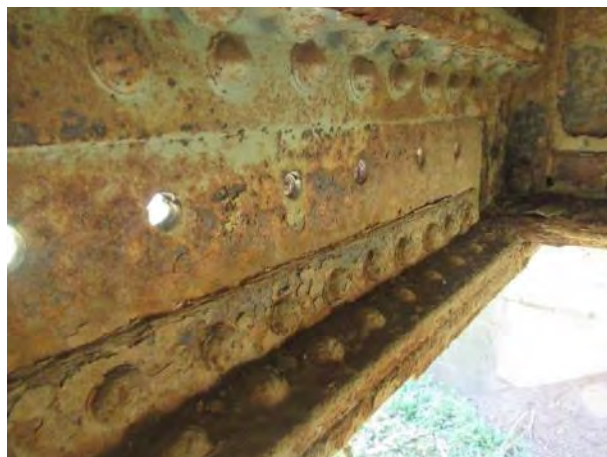
Зона континуитета десног (узводног) подужног носача код попречног носача ПН1 - дубинска корозија доњег угаоника, вертикалног лима и заковица на споју угаоника
