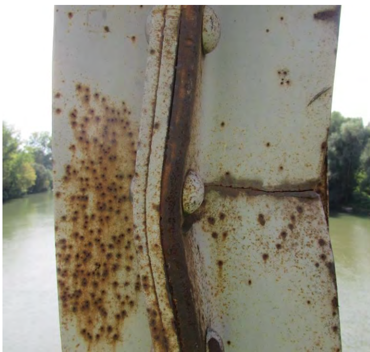
Механичко оштећење вертикале I' десног решеткастог носача конструкције КЗ
