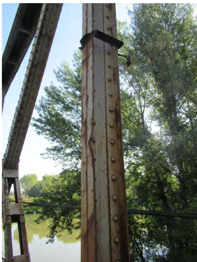
Механичко оштећење вертикале V десног решеткастог носача конструкције K2
