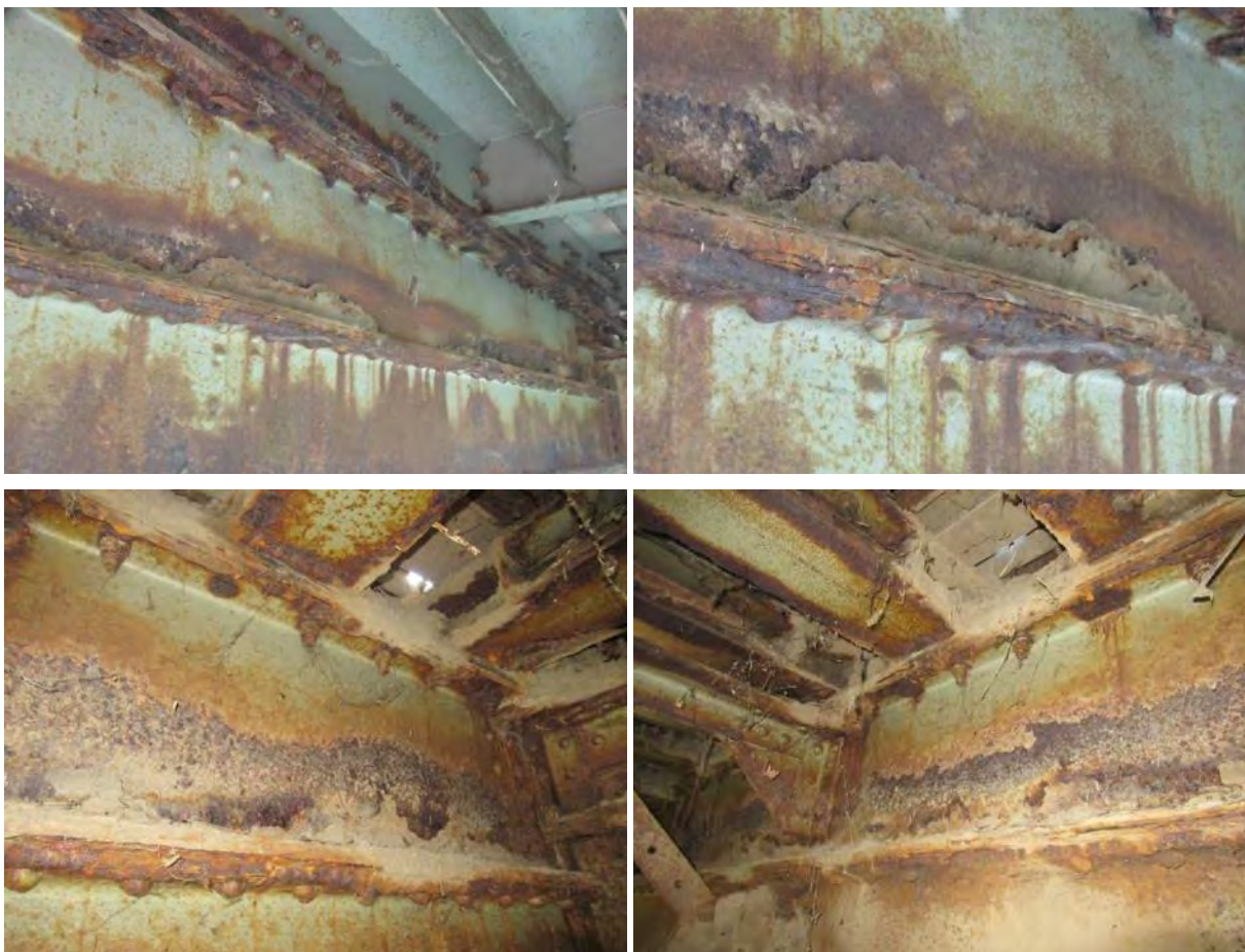
Дубинска корозија са листањем челика на десном (низводном) носачу у зони споја ребра и доње фланше - поље 0-1
