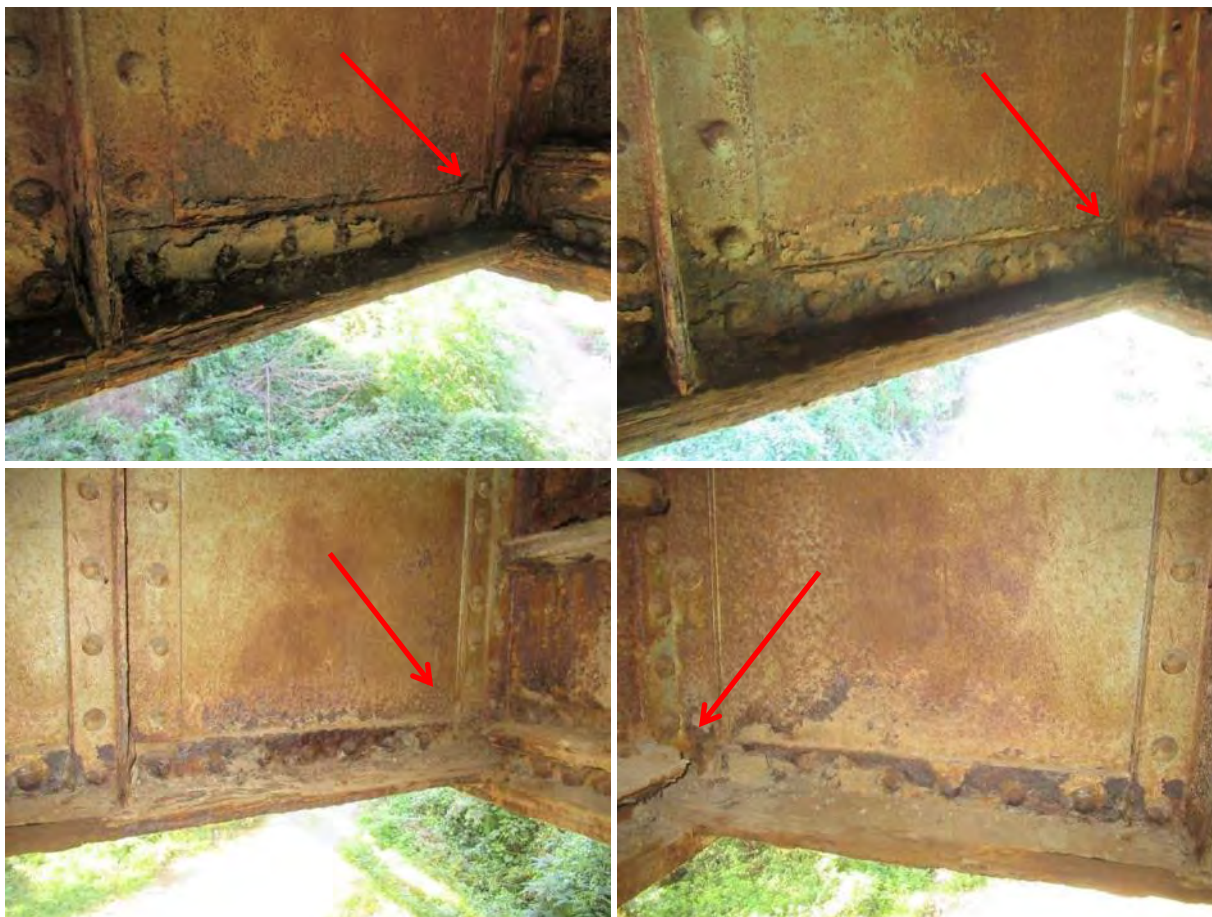
Доње зоне веза доњих подужних носача, унутрашња страна - појачана дубинска корозија са деградацијом материјала
