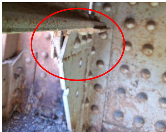
Деформисан угаоник ослонца подужног носача
