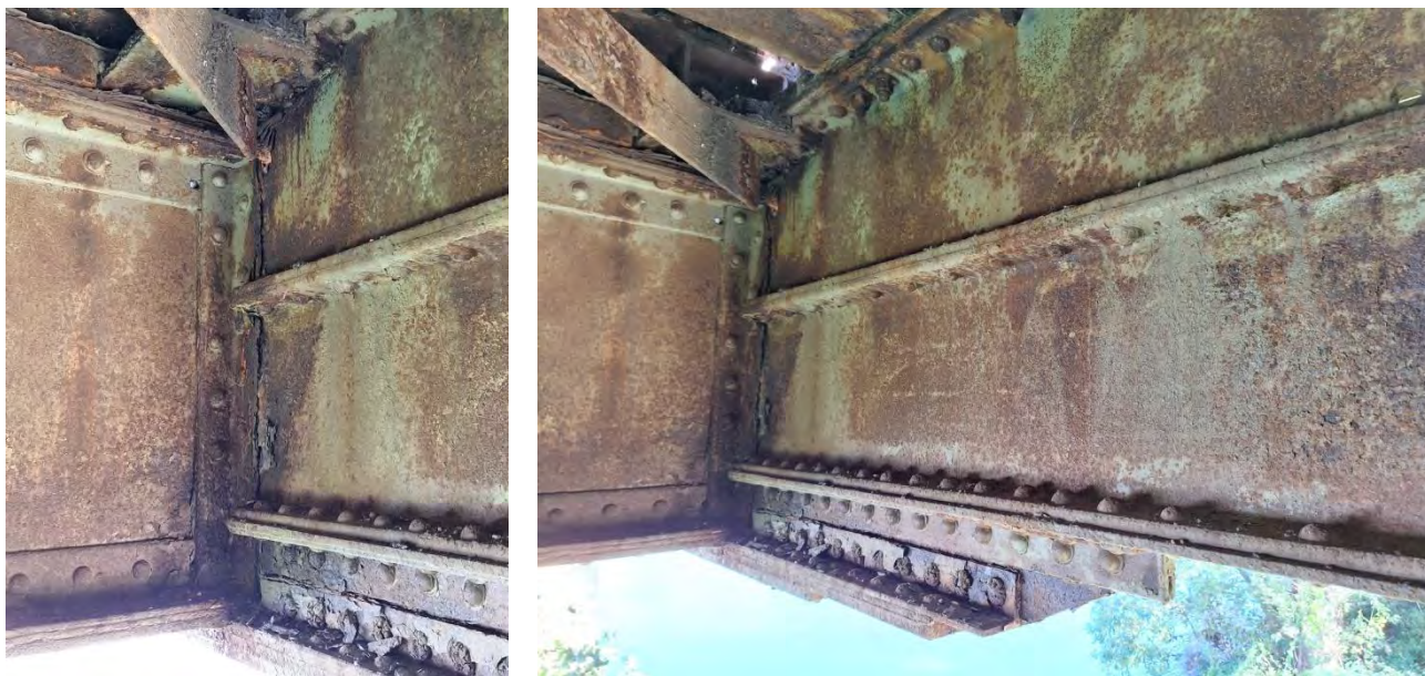
Доње зоне веза доњих подужних носача, унутрашња страна - чвор З'
