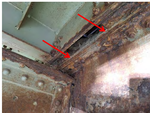
Дубинска корозија горње фланше и спојних средстава код оба горња носача, посебно у зонама ослањања секундарних попречних носача
