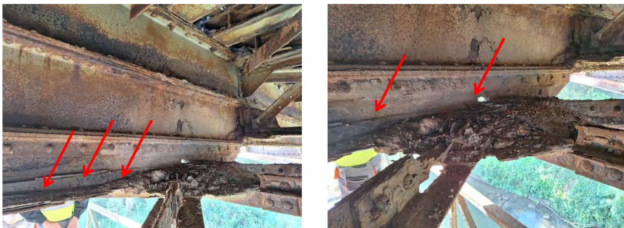
Зона континуитета левог (низводног) подужног носача код попречног носача ПНО' - дубинска корозија доњег угаоника, вертикалног лима и заковица на споју угаоника
