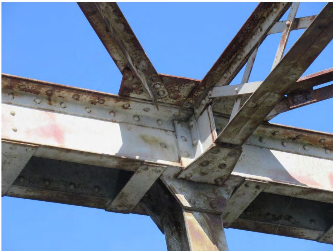
Веза решеткастог носача и горњег спрега за ветар конструкције K4
