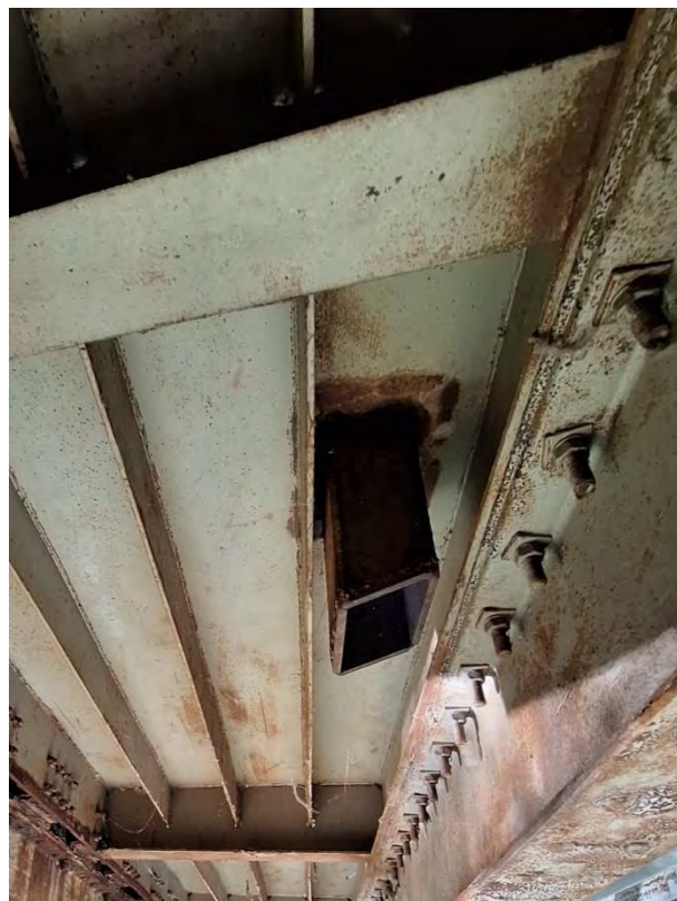
Сливничке вертикале захваћене површинском корозијом, недовољне дужине постављене на погрешан начин (краћа страна ближе ивичном носачу) - Конструкција К2
