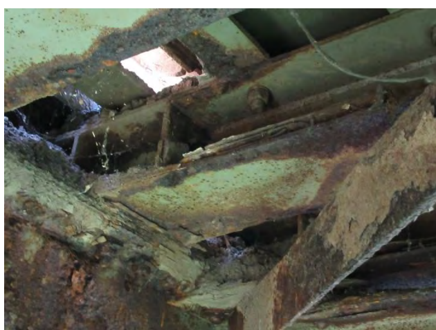
Лисната корозија доњег лима код већине секундарних попречних носача коловоза
