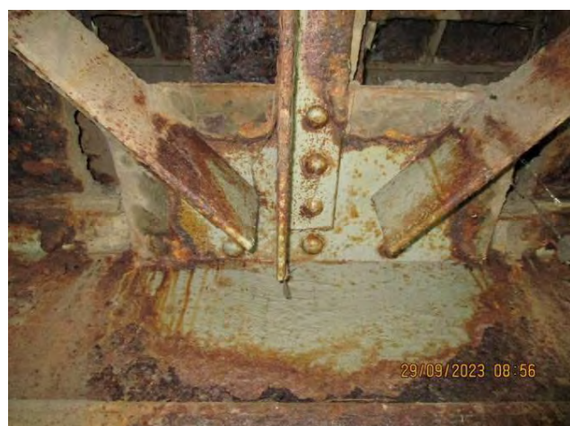
Дубинска корозија са умањењем основног пресека површине чворних лимова спрега за бочне ударе
