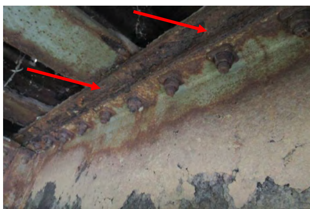
Дубинска корозија, листање и бубрење ламеле на горњој ножици носача
