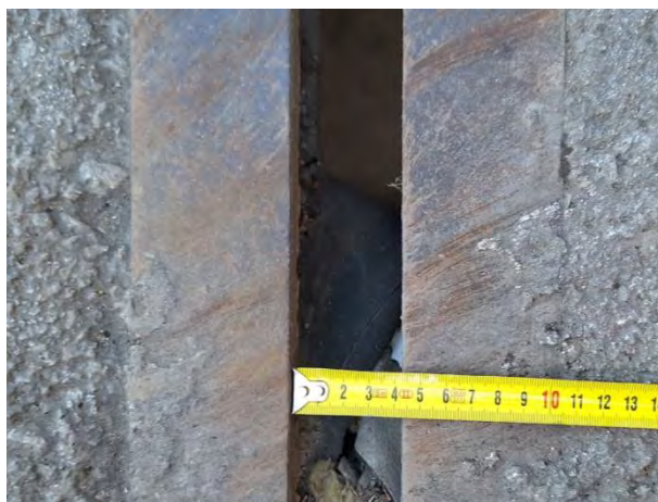
Зазор дилатације
