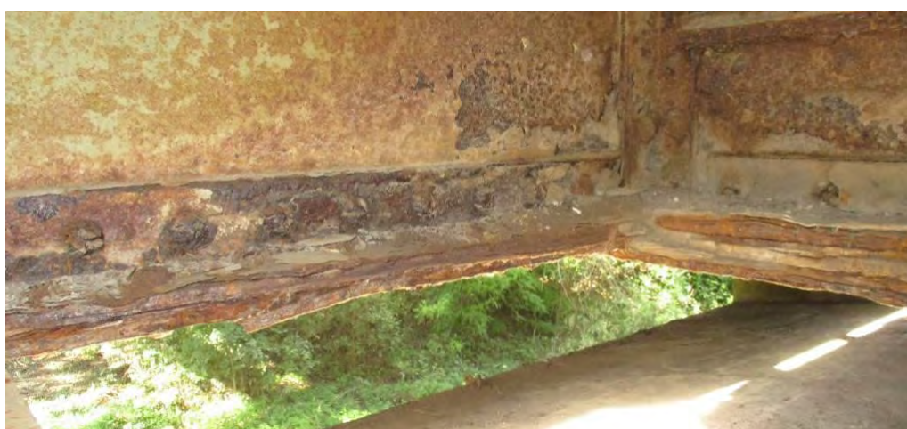
Попречни носач ПНО - местимичне појачане дубинске корозије са умањењем пресека угаоника и ламела попречног носача и стање заковица
