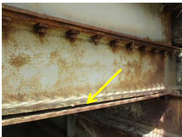
Доња ламела се одвојила од доње ножице десног подужног ивичног носача
