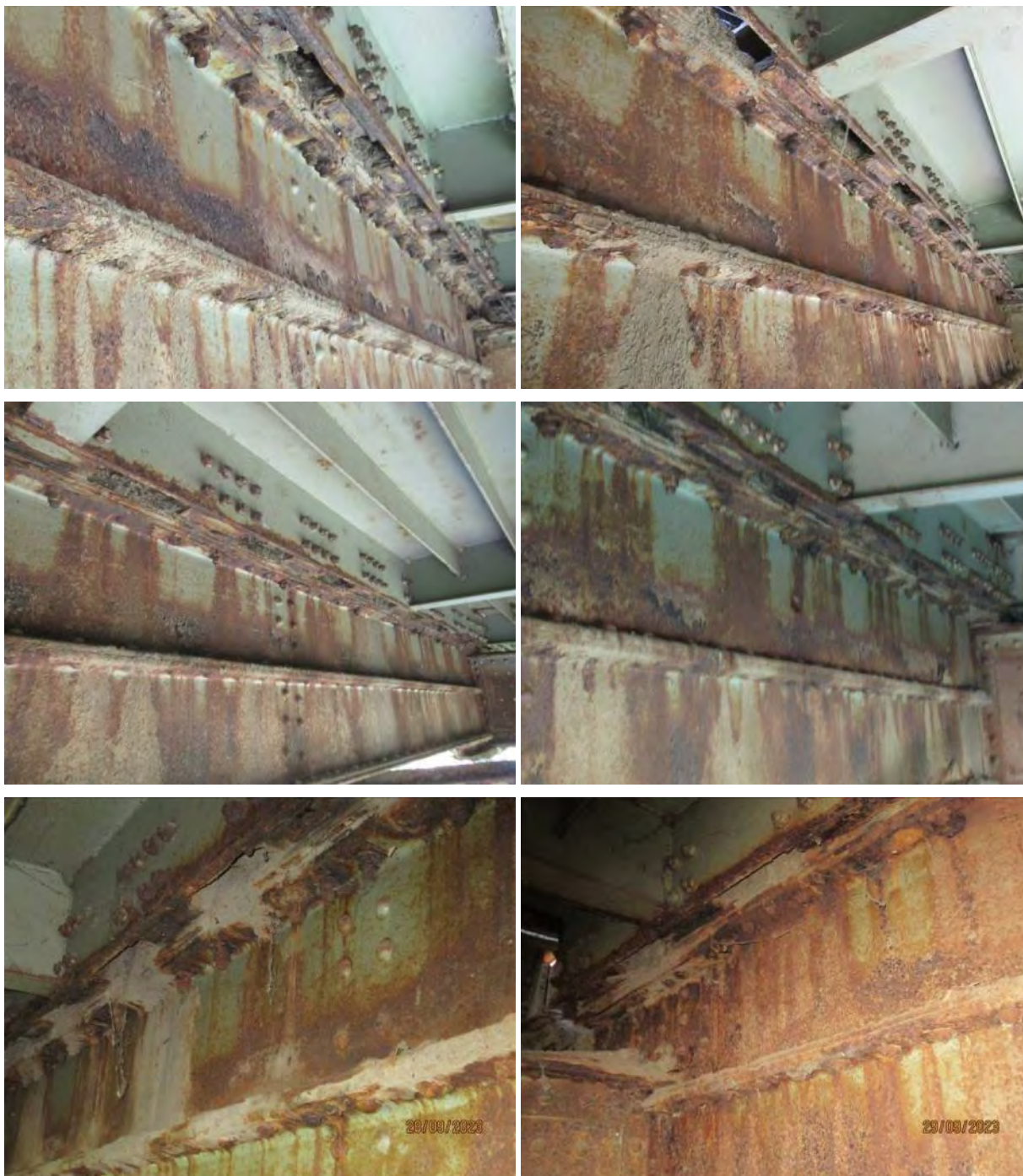
Дубинска корозија са зачецима деградације материјала у зони споја ребра и доње фланше у свим осталим пољима конструкције К1
