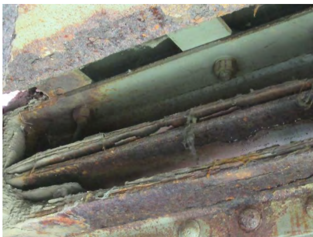
Лисната корозија доњег лима код већине секундарних попречних носача коловоза
