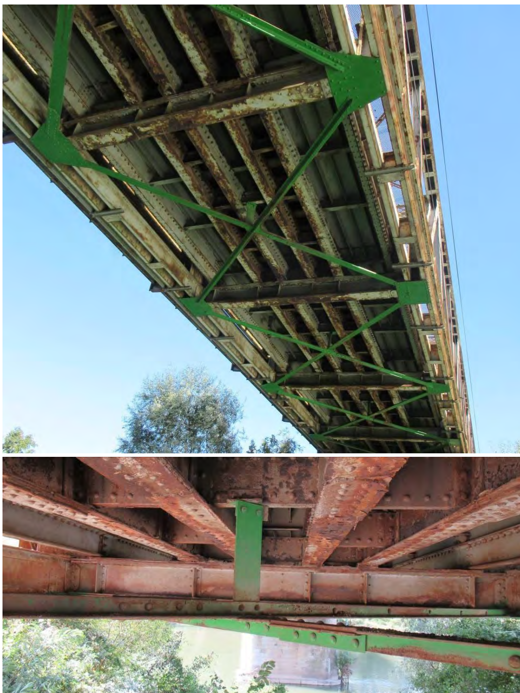
Доњи спрег конструкције K4
