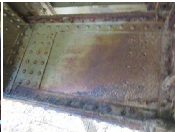
Попречни носач ПН0 ка ПН1, ивични делови - дубинска корозија доњих појасних угаоника и вертикалног лима у доњој зони
