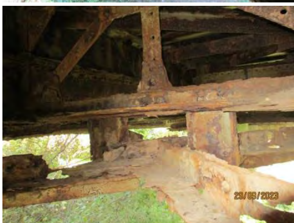
Тотална деградација чворних лимова и профила за везу доњег спрега у свим пољима
