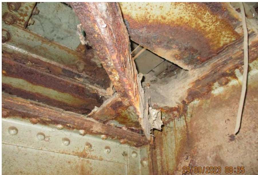
Дубинска корозија са умањењем основног пресека површине дијагонале спрега за бочне ударе у пољу 2-3
