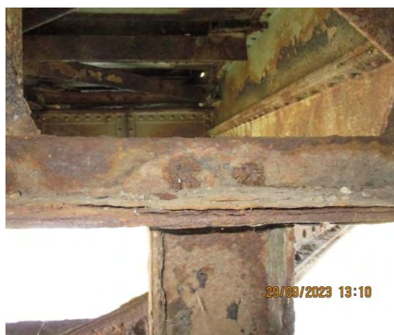
Лоше стање заковица у доњој зони попречних укрућења подужних носача конструкције КЗ
