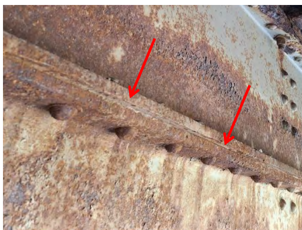
Дубинска корозија у зони споја ребра и доње фланше у свим осталим пољима конструкције К3
