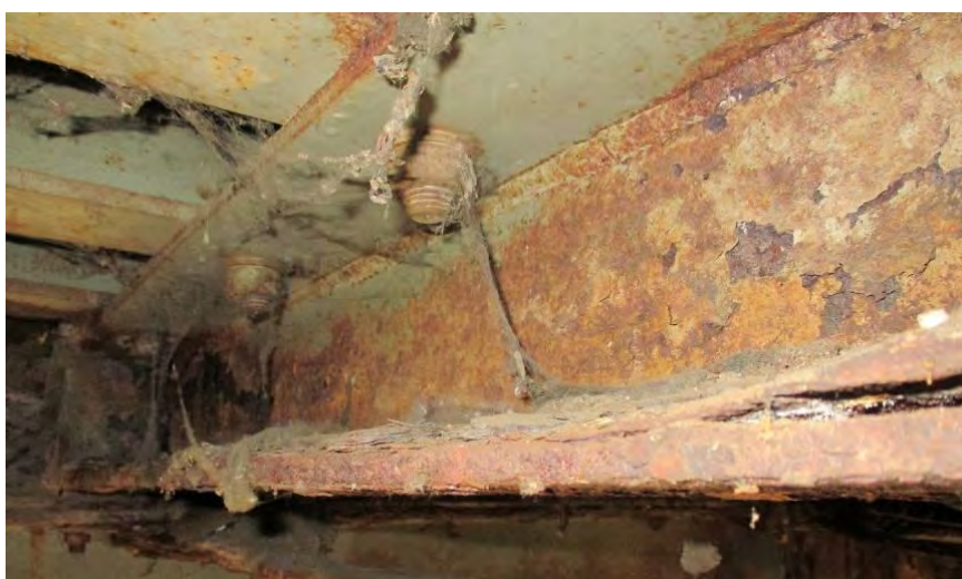
Горња површина доњег лима и вертикални лим секундарних попречних носача коловоза
