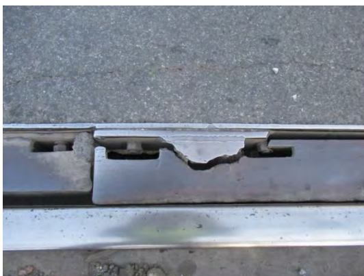
Пукла монтажна трака орто-плоче
