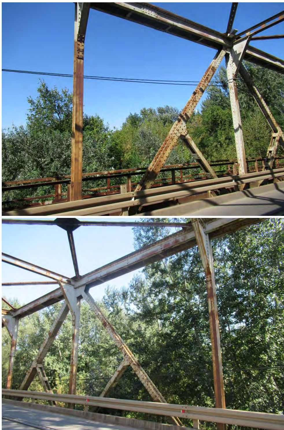
Вертикале главних решеткастих носача конструкције K1
