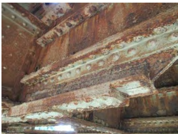
Зона континуитета десног (узводног) подужног носача код попречног носача ПН2 - дубинска корозија доњег угаоника, вертикалног лима и заковица на споју угаоника
