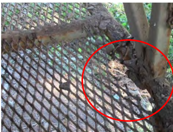
Пуцање развученог лима услед корозије, у средњем делу - небезбедно
