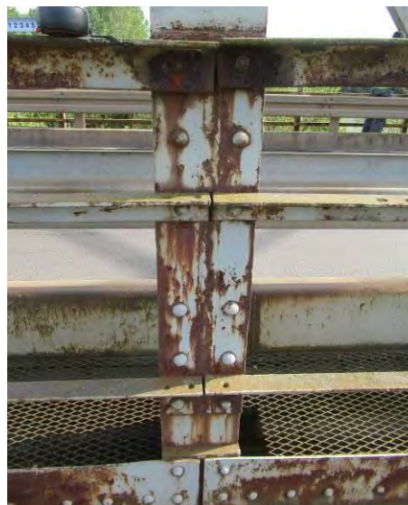
Монтажни наставак вертикале V левог решеткастог носача конструкције K4
