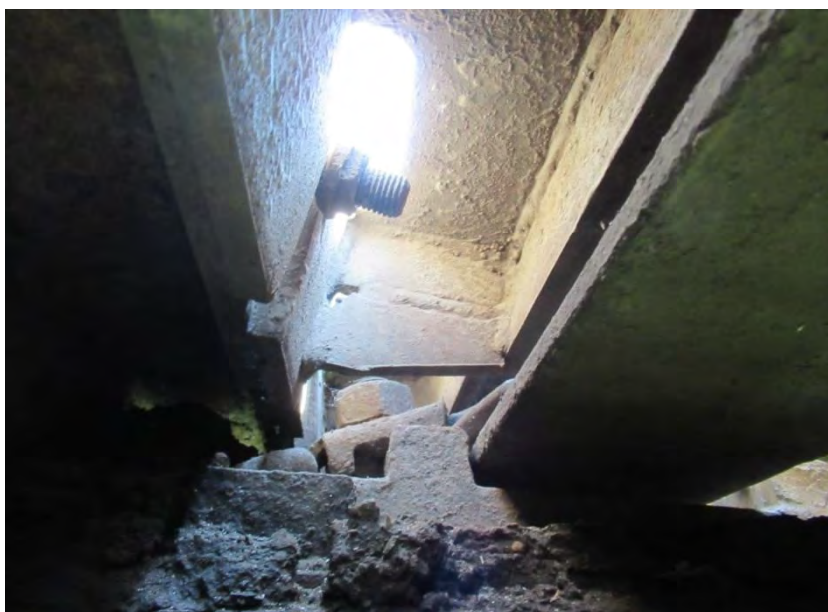
Причврсне плочице шине су ван функције
