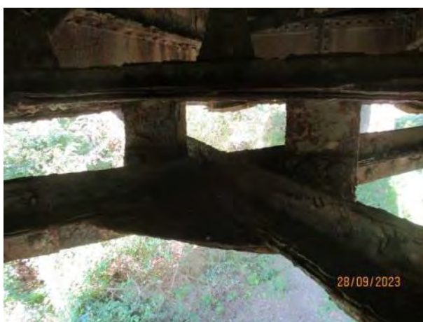
Тотална деградација дијагонала доњег спрега у свим пољима
