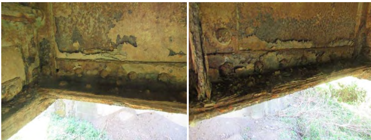
Средњи део, доњи појас осталих попречних носача у пољу - изражена дубинска корозија са деградацијом материјала (угаоника, ребра и заковица) - ТИПСКО СТАЊЕ
