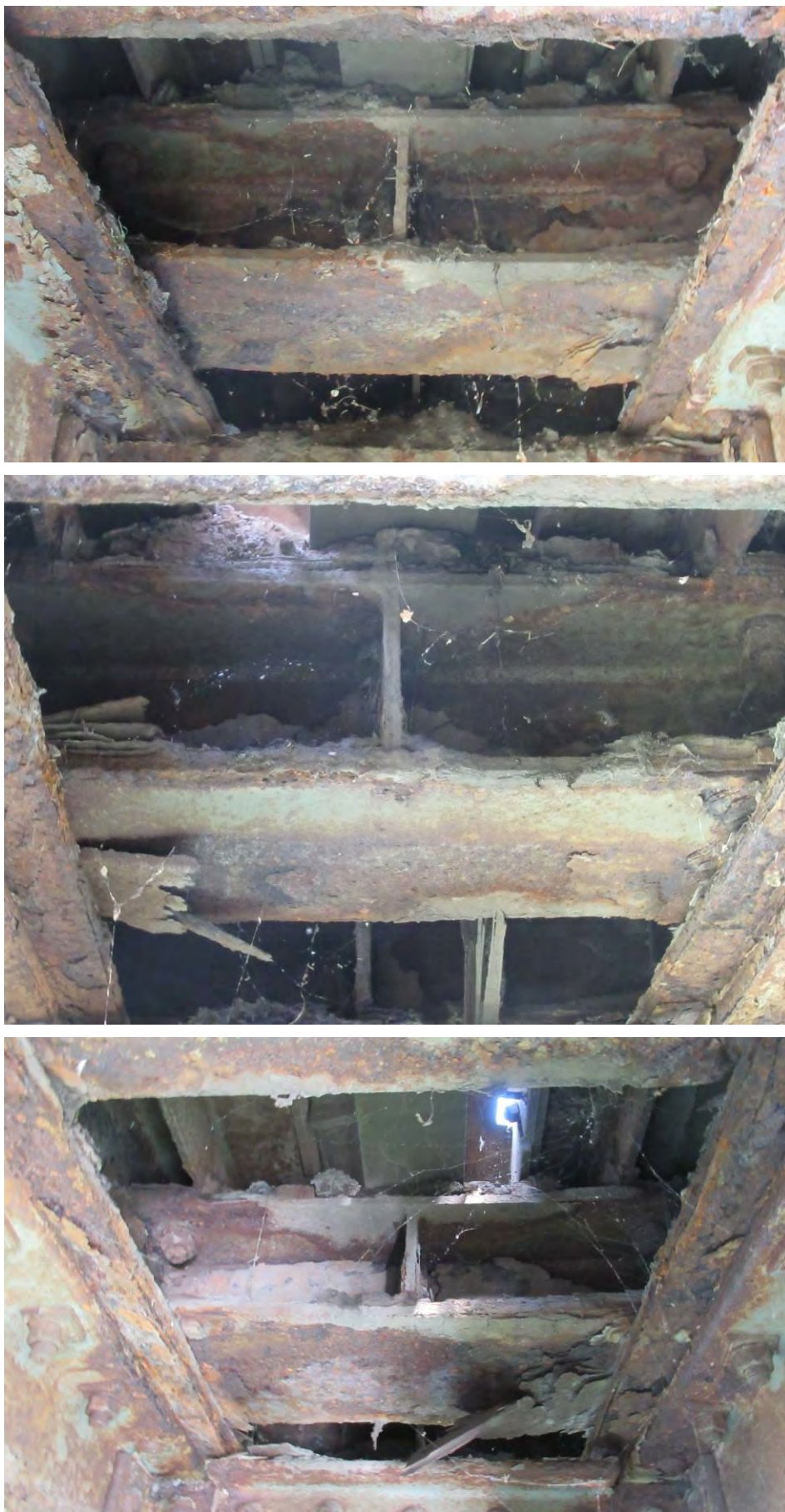
Дубинска и лисната корозија материјала неколико секундарних попречних носача коловоза конструкције К4
