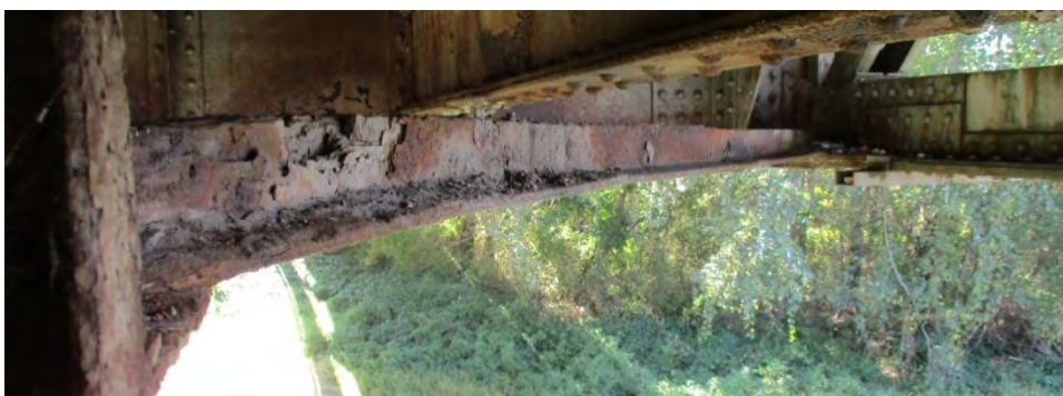
Извијање дијагонала доњег спрега за ветар у пољима 3-4, 4-5, 5-4', 4'-3' и 3'-2'
