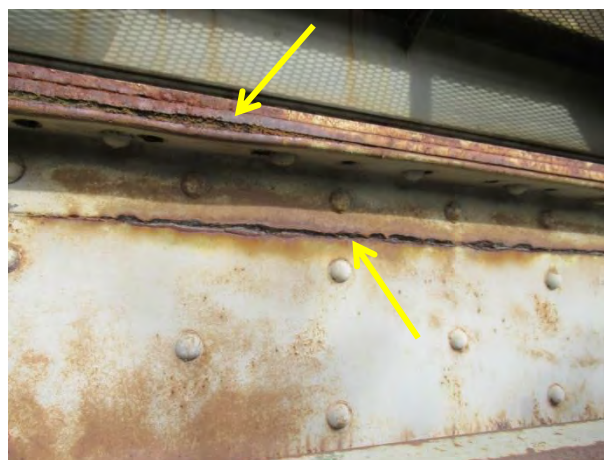
Дубинска корозија на горњој фланши и ребру доњег појаса
