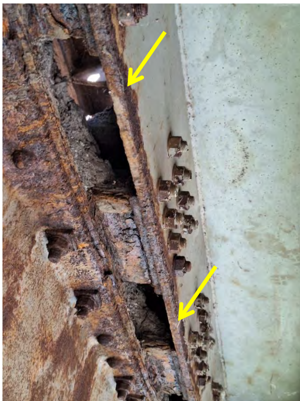
Корозија ивичног ребра орто-плоче уз шину, као и завртњева на вези са секундарним попречним носачима
