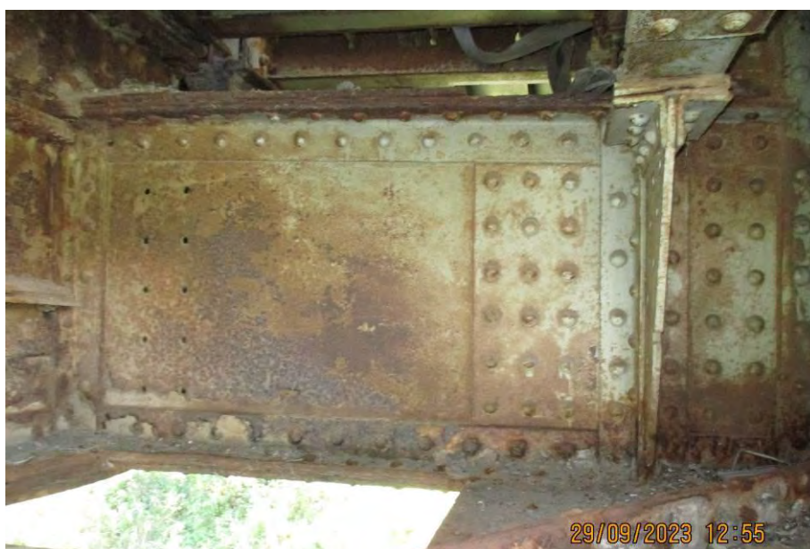
Попречни носач ПНО - унутрашња страна - вертикални лим у зони подужних носача захваћен дубинском корозијом
