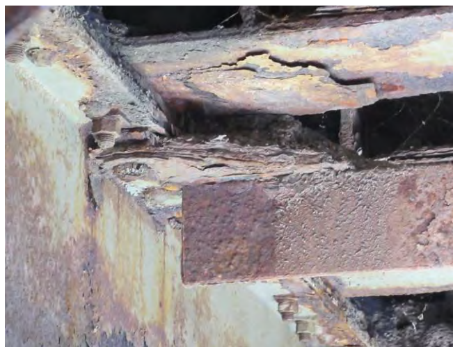
Дубинска корозија са умањењем основног пресека површине чворних лимова спрега за бочне ударе а нарочито у задња два поља где је уочена и лисната корозија
