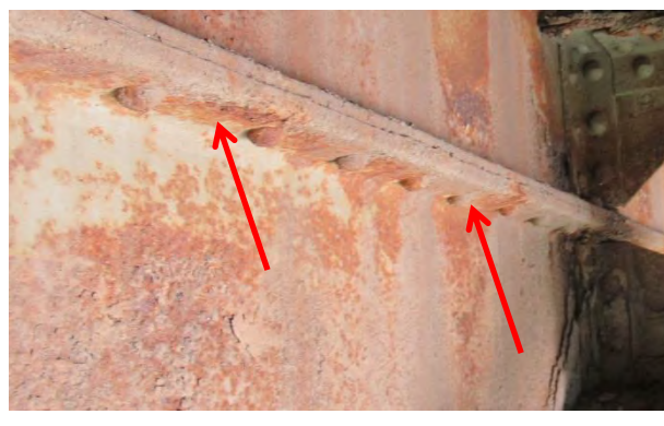
Лоше стање горње ножице и закивака на споју два носача
