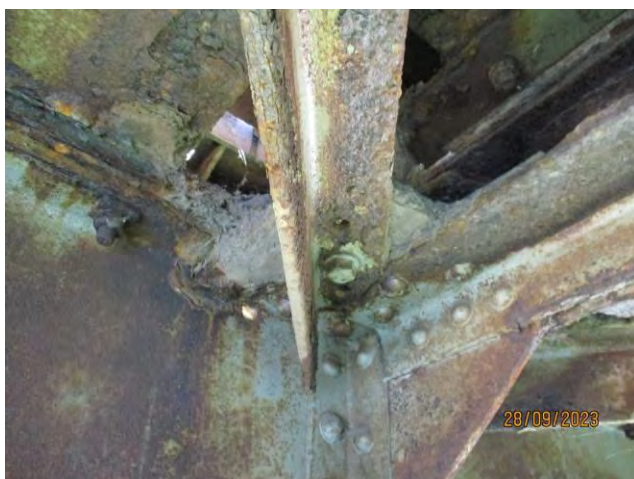
На више места веза штапова спрега и чворних лимова је остварена завртњевима. На неколико места уочен је недостатак завртњева.
