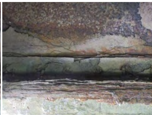
Попречни носач ПН0 ка ПН1, средњи део - тотална деградација доњих појасних угаоника и вертикалног лима у доњој зони
