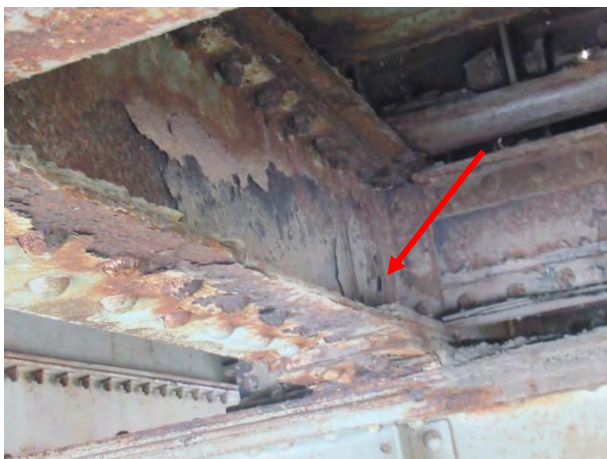
Дубинска корозија и деградација подужног носач- Зона ослањања носача 2 на попречни носач 5
