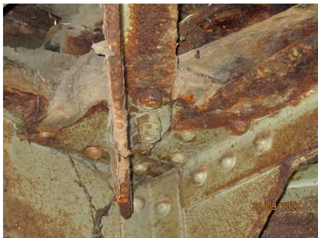
Дубинска корозија са умањењем основног пресека површине дијагонале спрега за бочне ударе у пољу 2-3
