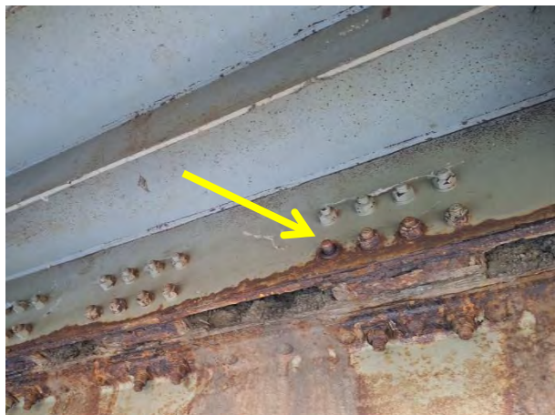
Недостаје матица завртња на вези са секундарним попречним носачем
