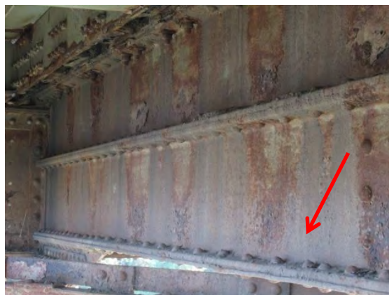
Десни (узводни) доњи подужни носач
