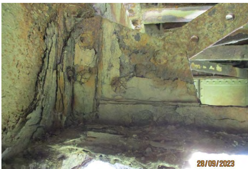
Лоше стање заковица на везама штапова и чворних лимова попречних укрућења и чворних лимова укрућења и подужних носача
