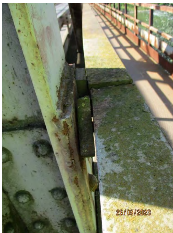
Неутегнуто спојно средство на вези рукохвата унутрашње ограде за вертикалу
