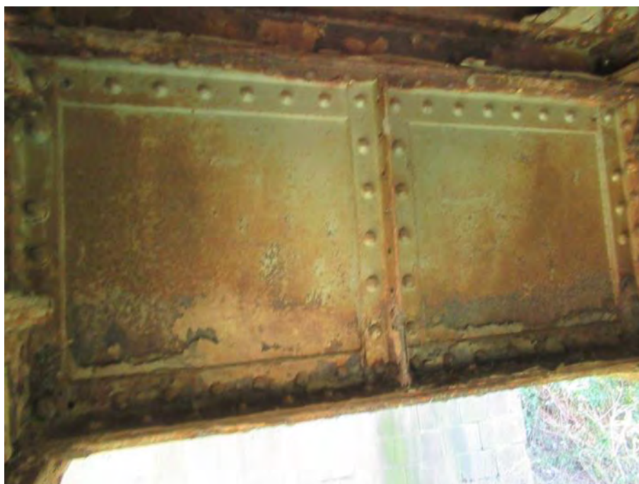
Средњи део осталих попречних носача у пољу - ТИПСКО СТАЊЕ
