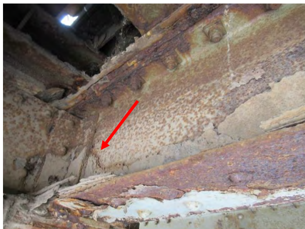
Дубинска корозија и деградација подужног носача- Зона ослањања носача 2 на попречни носач 1'
