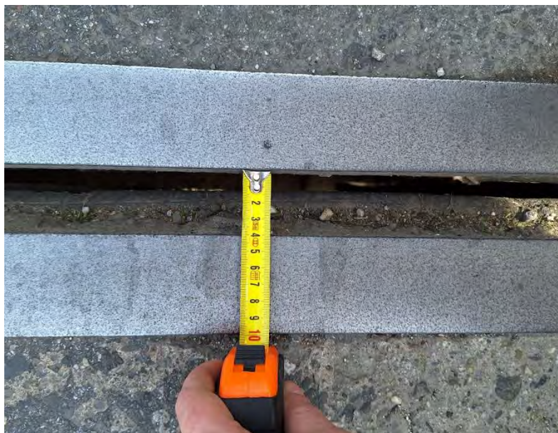
Зазор дилатације
