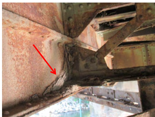
Дубинска корозија ребра са зачецима деградације материјала у зони прикључка попречног укрућења подужних носача
