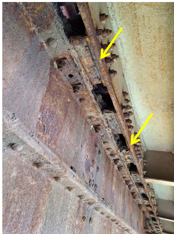
Корозија ивичног ребра орто-плоче уз шину, као и завртњева на вези са секундарним попречним носачима
