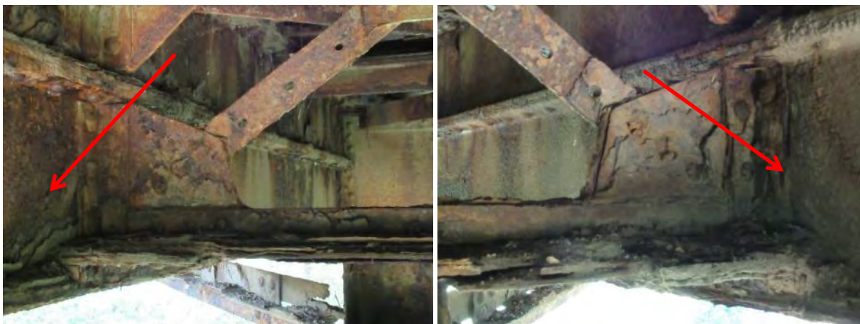
Дубинска корозија ребра са зачецима деградације материјала у зони прикључка попречног укрућења подужних носача
