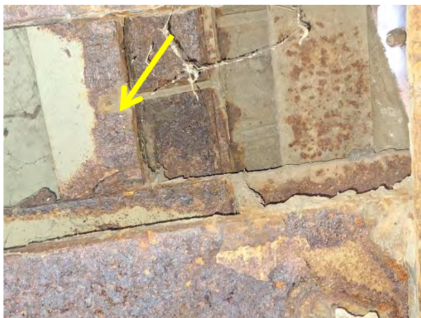
Корозија ивичног ребра средњег монтажног комада орто-плоче уз шину
