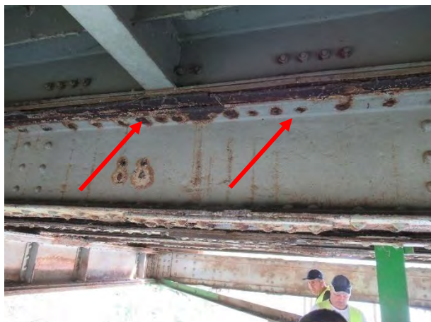
Недостају завртњеви на вези горње фланше носача 2 и орто-плоче у пољу 1-2
