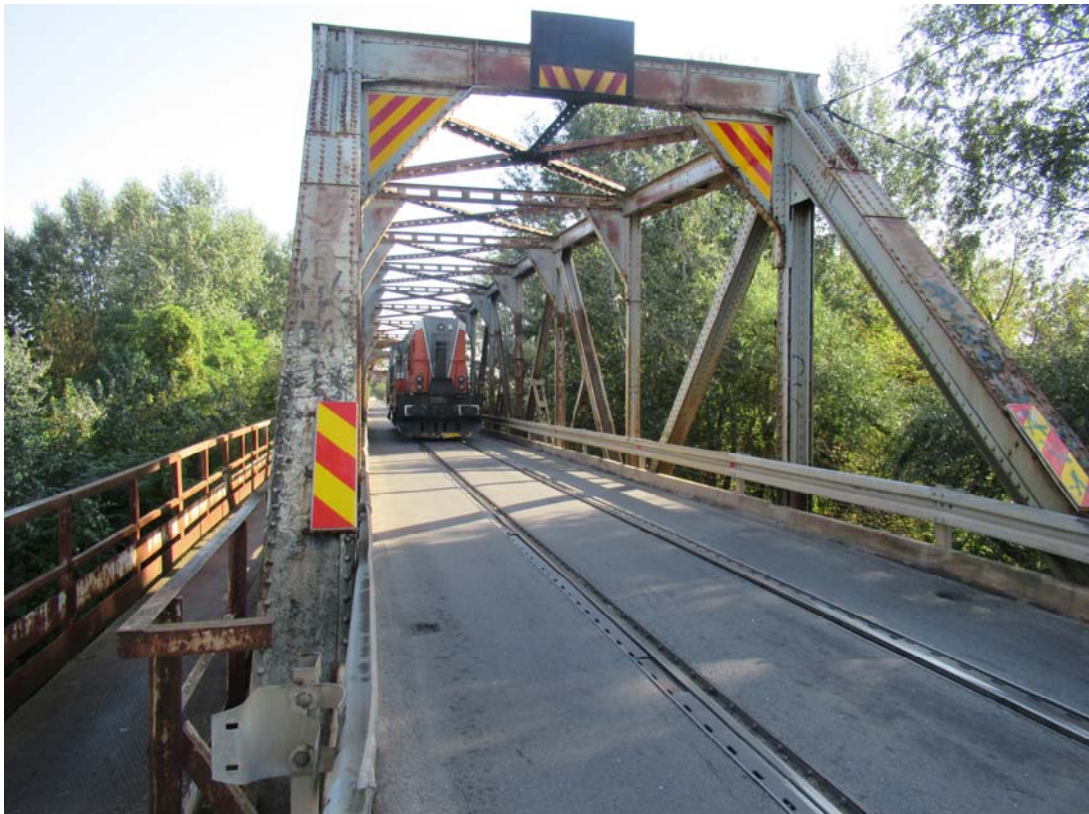
изглед конструкције - поглед на коловоз/колосек
