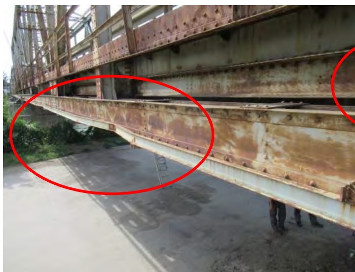
Велика деформација узводне (десне) шине услед ударца возила у пољу 1' - 0'
