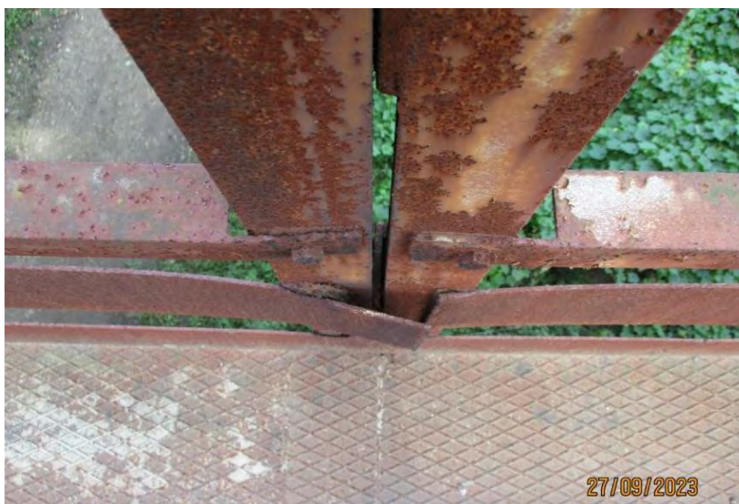
Локално прекинут горњи лим на средини распона C2-C3 (конструкција K2)
