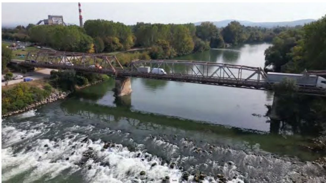
изглед конструкција са низводне стране
