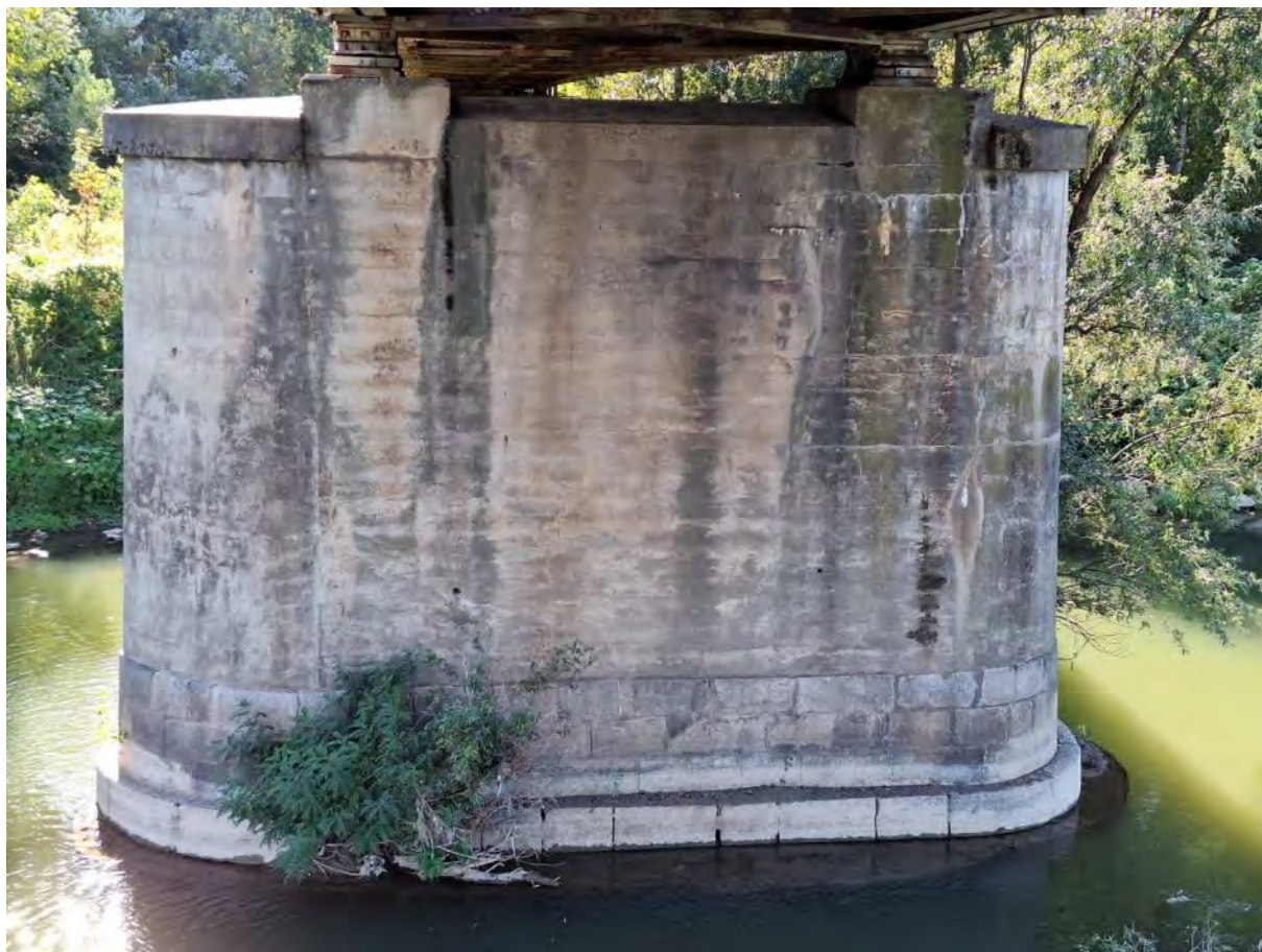
Страна стуба ка стубу С4. Трагови сливања воде и калцификација на површини стуба
