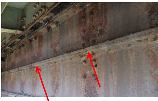
Лоше стање горње ножице и закивака на споју два носача
