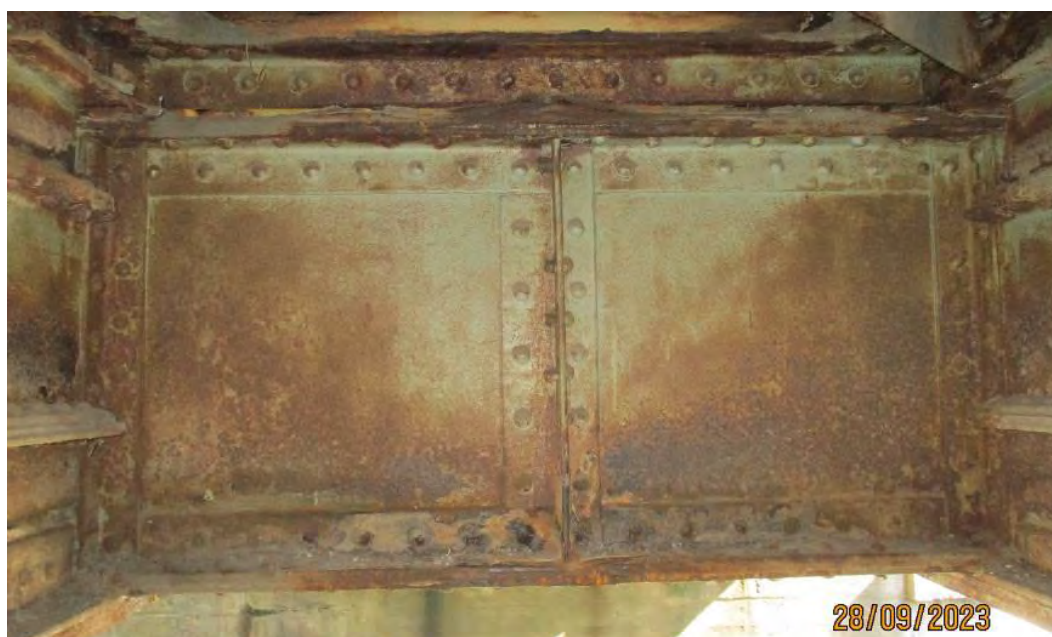
Средњи део попречних носача захваћен дубинском корозијом местимично са умањењем пресека
