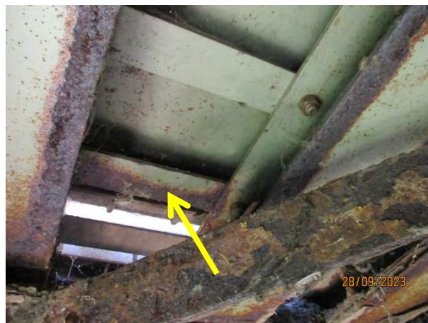
Корозија ивичног ребра орто-плоче уз шину - средњи монтажни комад орто-плоче
