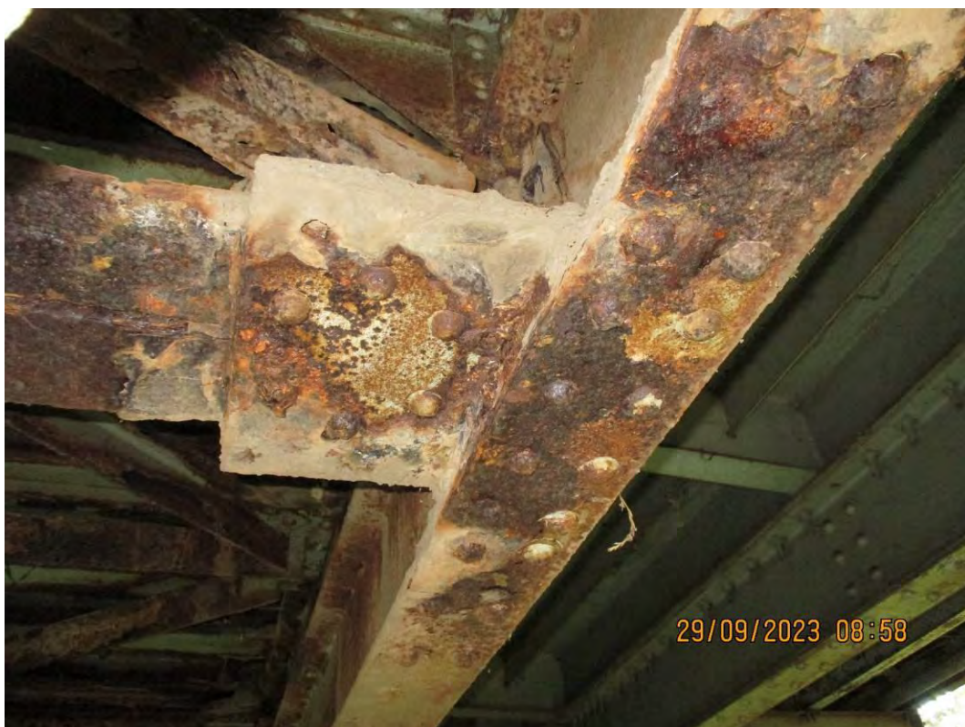
Чворни лимови на вези попречних укрућења подужних носача и доње ножице подужних носача
