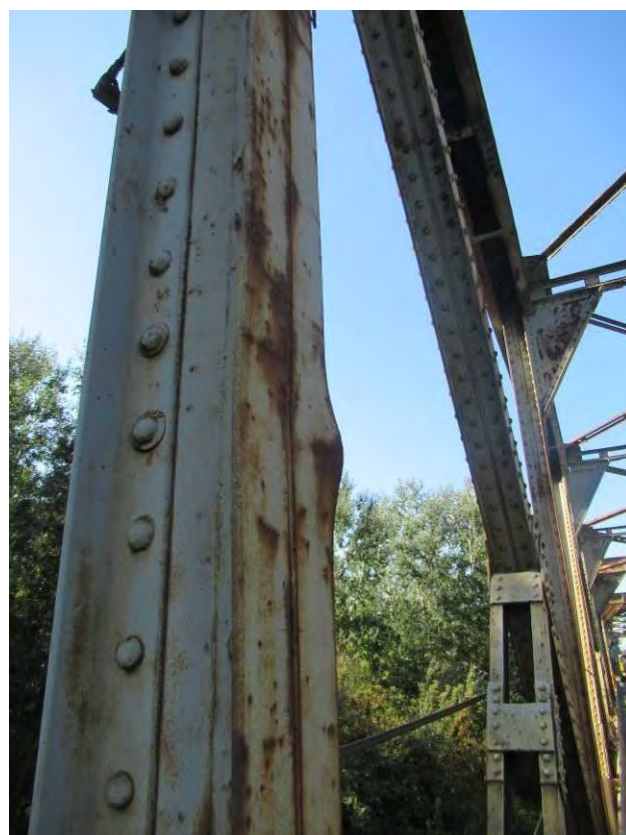
Механичко оштећење вертикале V десног решеткастог носача конструкције K2
