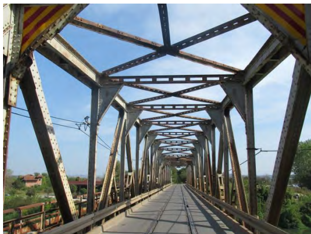
Површинска корозија - главнирешеткасти носач конструкције K3
