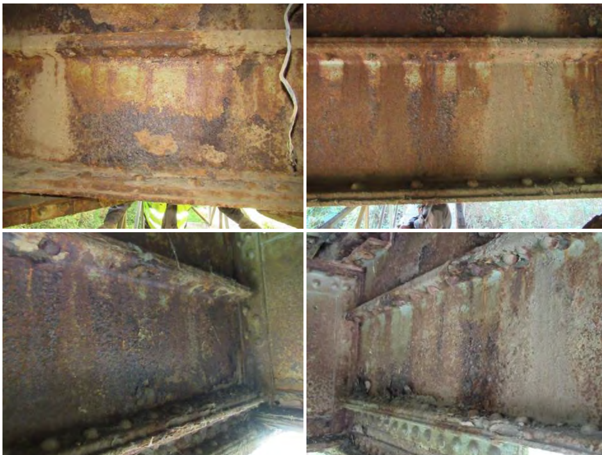
Лоше стање горње ножице и закивака на споју два носача - у свим пољима конструкције K1
