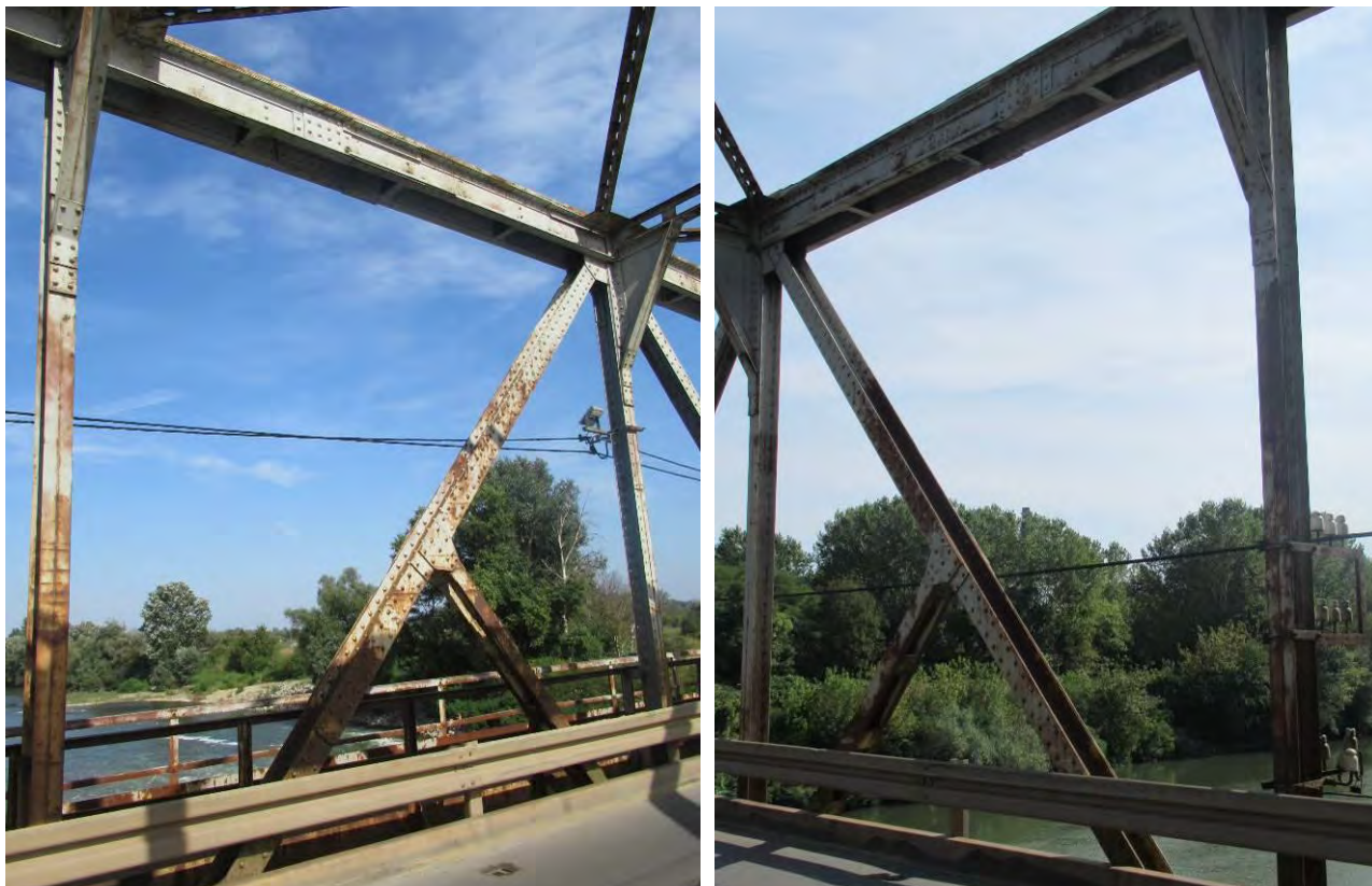
Вертикале левог и десног решеткастог носача конструкције КЗ
