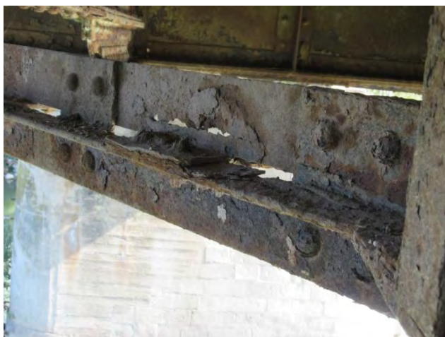
Дубинска корозија са умањењем основног пресека дијагонала доњег спрега за ветар конструкције КЗ
