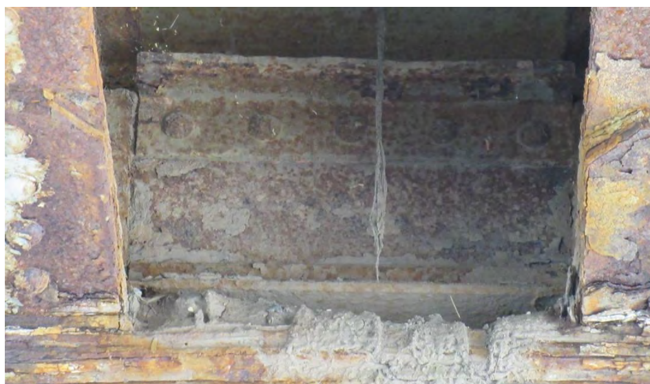
Попречна укрућења подужних носача 2 и 3 и 3 и 4 конструкције К4
