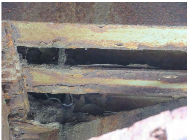
Дубинска корозија са умањењем основног пресека површине и лисната корозија доњег лима секундарних попречних носача коловоза конструкције КЗ
