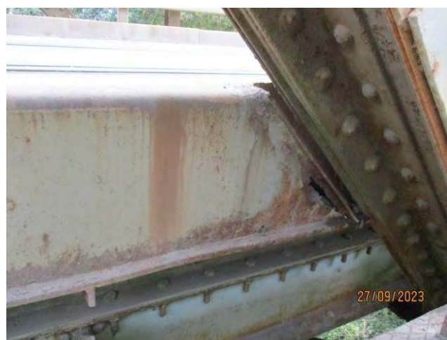
Оштећења челика левог ивичњака у зонама усецања ивичњака код ојачаних дијагонала
