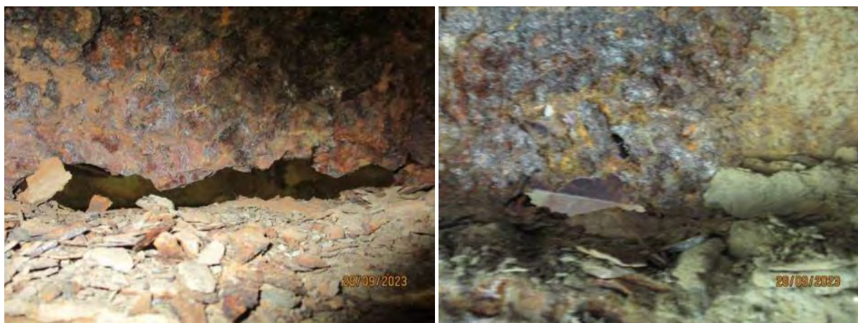
Деградација ребра левог подужног носача у пољу 2-3 - прекид везе за доњом фланшом
