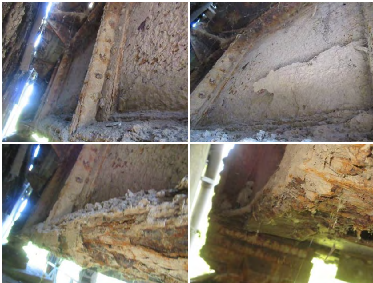
Попречни носач ПН0, ка парапету стуба С1 - изражена дубинска корозија са листањем материјала и умањењем пресека лимова и угаоника и горњег и доњег појаса
