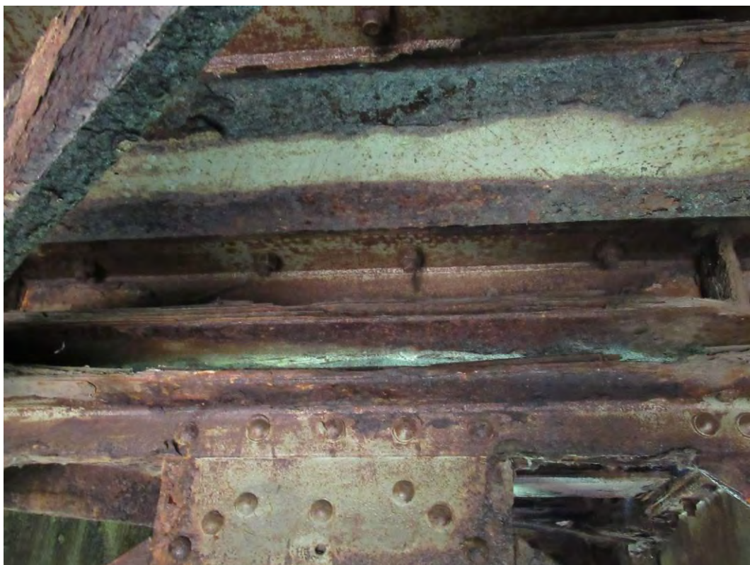
Дубинска корозија са умањењем основног пресека и лиснатом корозијом вертикале спрега за бочне ударе које се налазе код попречних укрућења подужних носача
