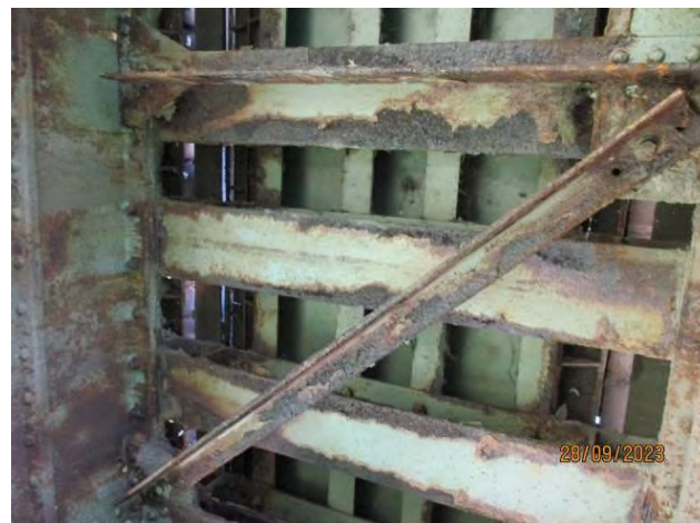
Дубинска корозија са умањењем основног пресека површине дијагонале спрега за бочне ударе у пољу 2-3
