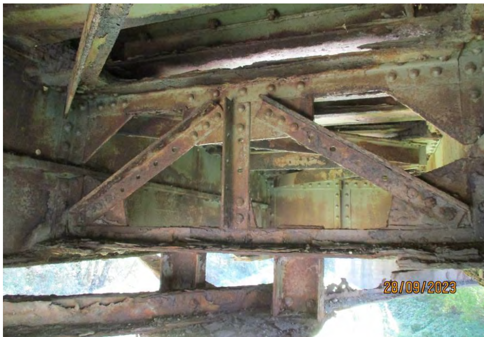
Попречна укрућења подужних носача
