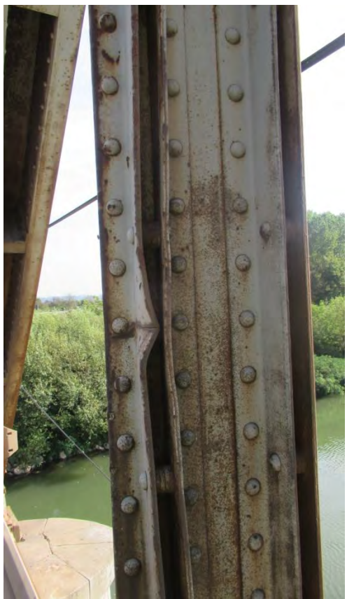
Механичко оштећење вертикале I' десног решеткастог носача конструкције КЗ
