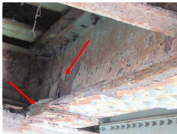
Дубинска корозија и деградација подужног носач- Зона ослањања носача 5 на попречни носач 2
