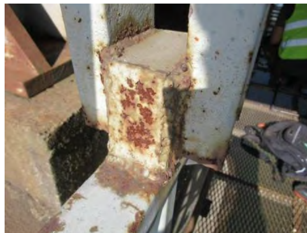
Лошије изведени заварени спојеви захваћени површинском корозијом
