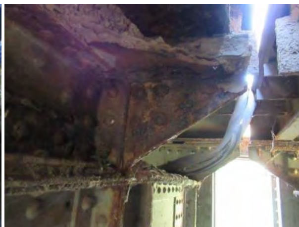
Дубинска корозија конзоле подужног носача код попречног носача ПНО
