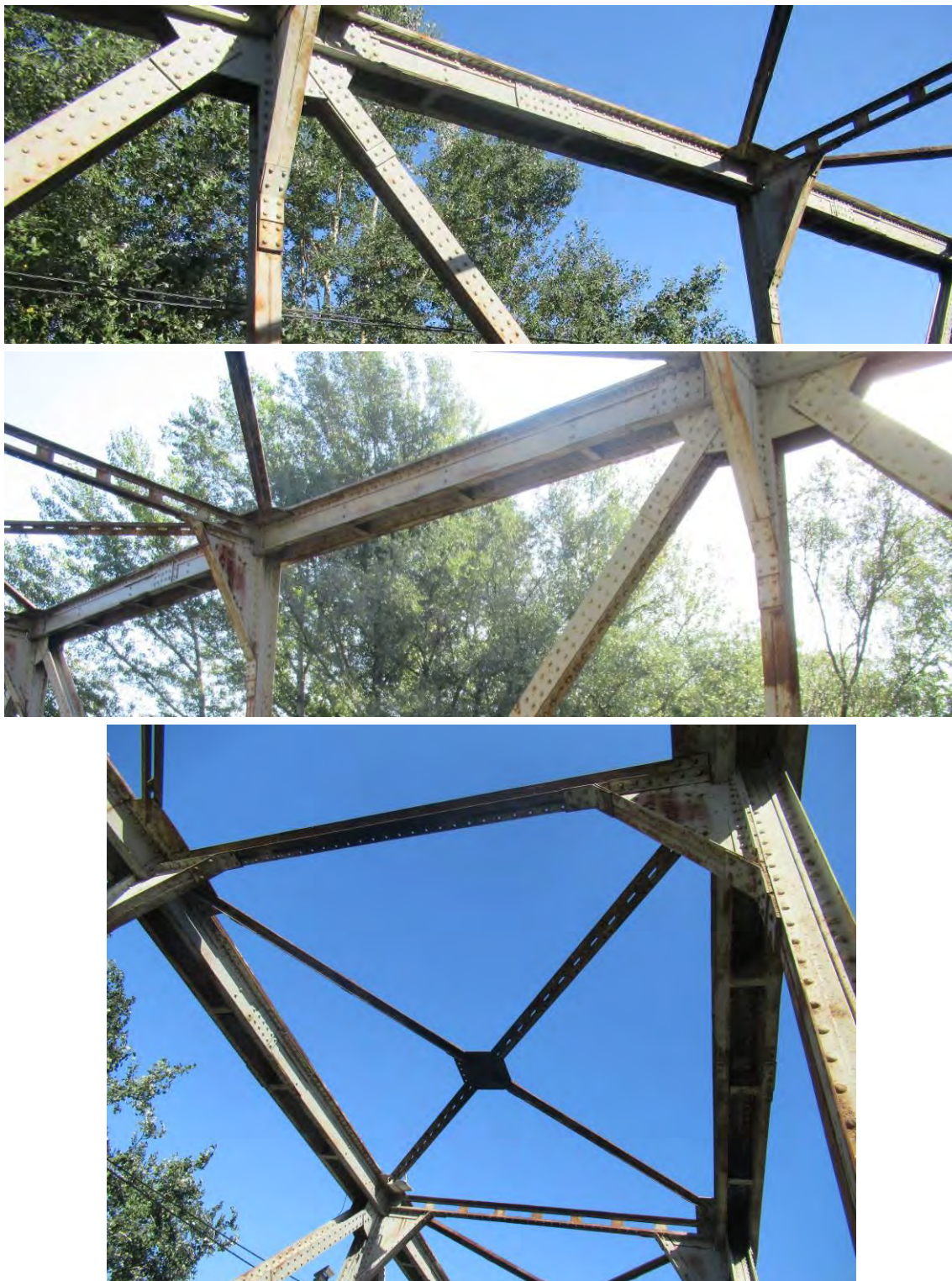
Горњи појас конструкције K2
