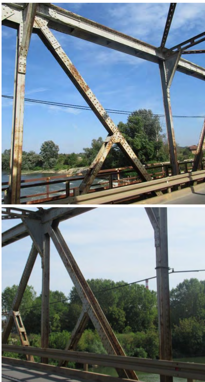
Дијагонале левог и десног решеткастог носача конструкције КЗ
