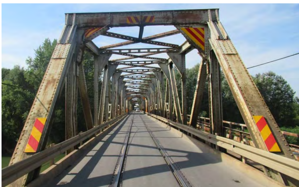
Излазни портални рам конструкције К3
