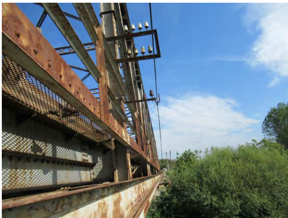
Развучени лимови на конструкцији K4 - поглед са доње стране
