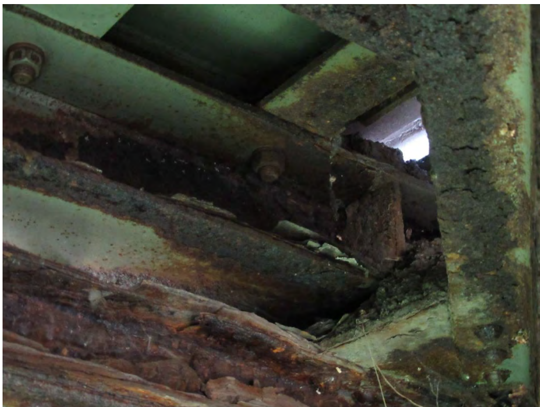
Укрућење вертикалног лима секундарних попречних укрућења подужних носача
