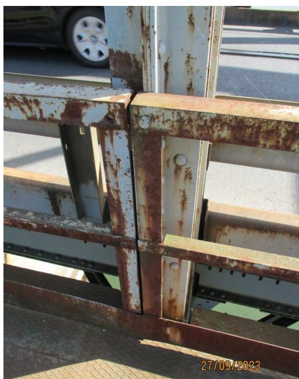
Недостатак спојног средства на вези рукохвата унутрашње ограде за вертикалу конструкције КЗ
