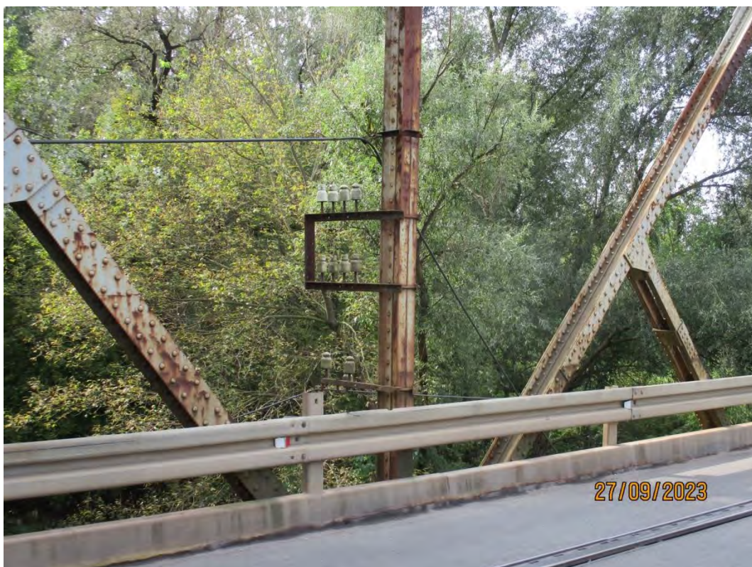
Инсталација на десној страни моста на почетку моста
