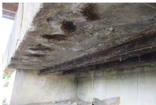
Оштећења заштитног слоја бетона дограђене лежишне греде
