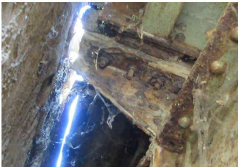
Дубинска корозија конзоле подужног носача код попречног носача ПНО
