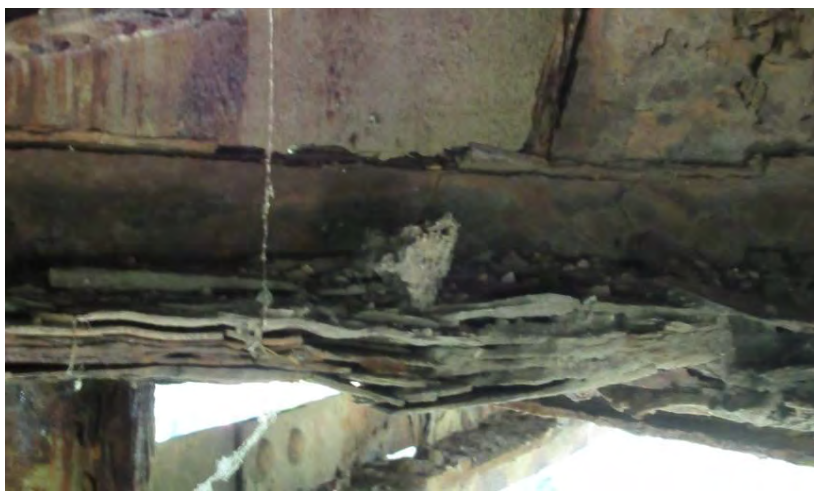
Лисната корозија вертикале попречних укрућења подужних носача
