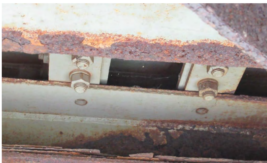
Недостатак неколико завртњева и неутегнути завртњеви на вези секундарних попречних носача коловоза и ортотропне плоче
