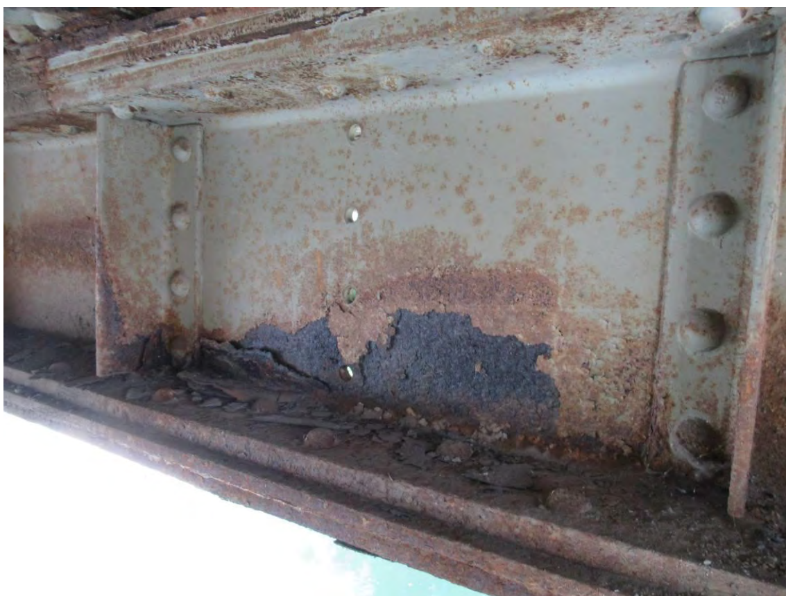
Локална дубинска корозија ребра попречног носача ПН1
