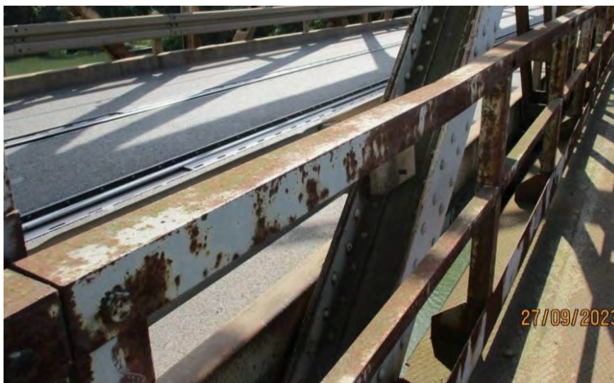
Мања деформација рукохвата унутрашње ограде код претпоследње вертикале конструкције К3
