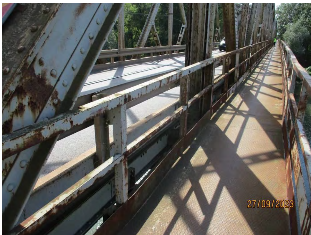
Унутрашња ограда пешачке стазе на конструкцији К3
