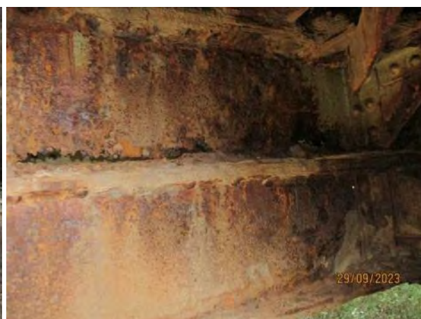
Деградација ребра левог подужног носача у пољу 4-5, дужине око 250ст - прекид везе за доњом фланшом
