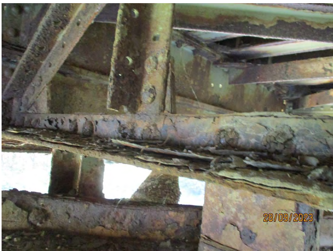
Лоше стање заковица на везама попречних укрућења подужних носача са "U" профилима доњег спрега
