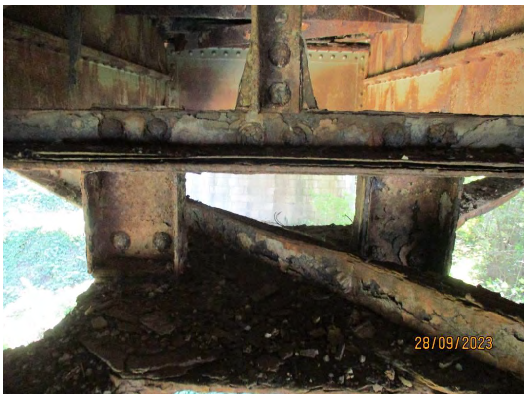
Лисната корозија вертикале попречних укрућења подужних носача
