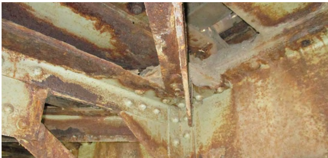
Веза дијагонале и чворног лима спрега за бочне ударе изведена завртевима
