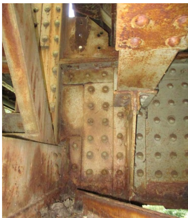
Попречни носачи у зони везе са главним носачима захваћени дубинском корозијом
