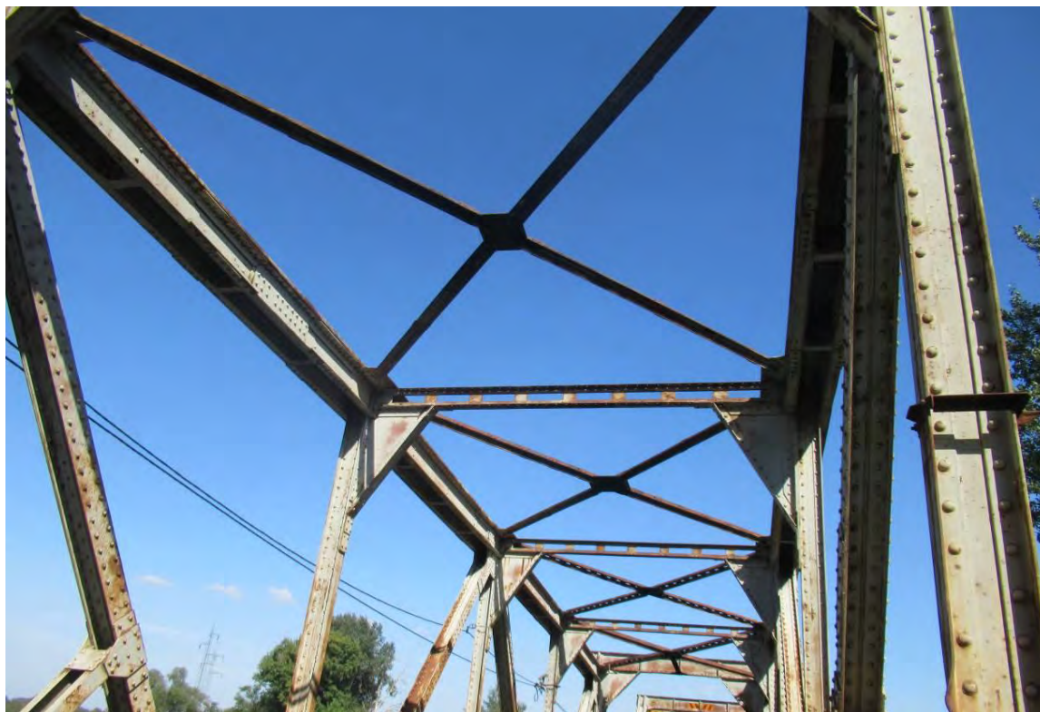
Горњи спрег за ветар конструкције K2
