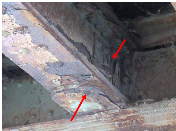
Дубинска корозија и деградација подужног носач- Зона ослањања носача 3 на попречни носач 1
