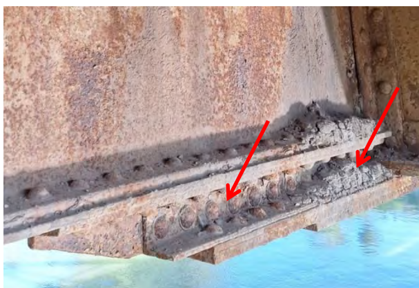
Зона континуитета десног (узводног) подужног носача код попречног носача ПН4' - дубинска корозија доњег угаоника, вертикалног лима и заковица на споју угаоника
