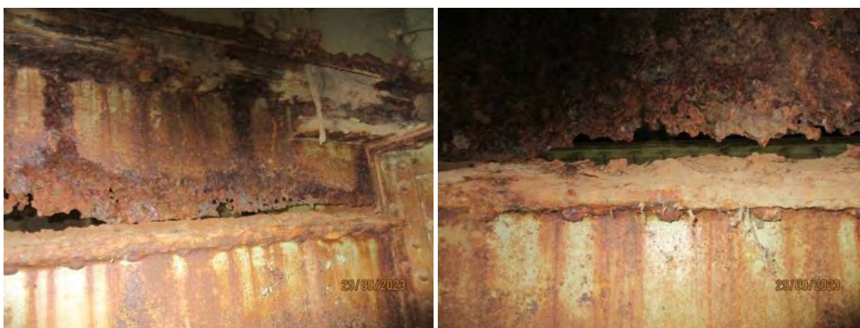
Деградација ребра левог подужног носача у пољу 4'-3', местимично - прекид везе за доњом фланшом
