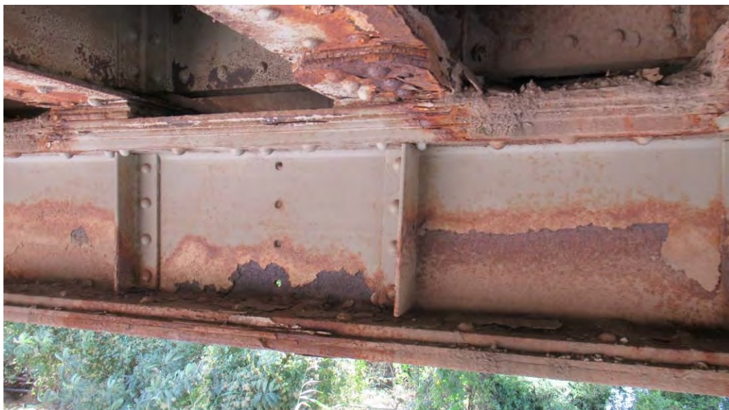
Локална дубинска корозија ребра попречног носача ПНЗ'
