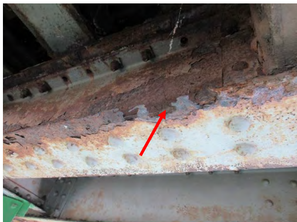
Дубинска корозија доње фланше и губитак попречног пресека носача 3 у пољу 2-3
