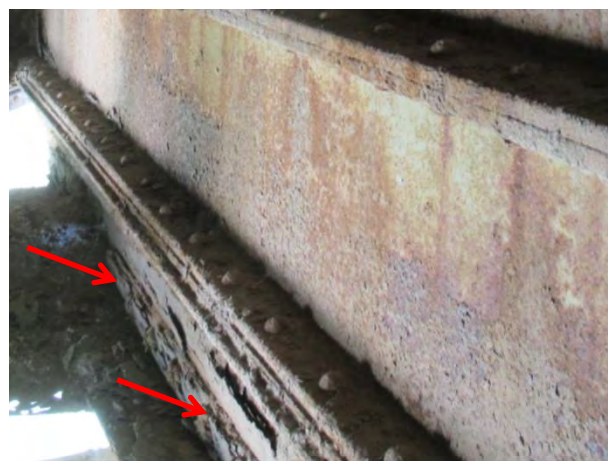
Зона континуитета левог (низводног) подужног носача код попречног носача ПН0 - дубинска корозија доњег угаоника, вертикалног лима и заковица на споју угаоника
