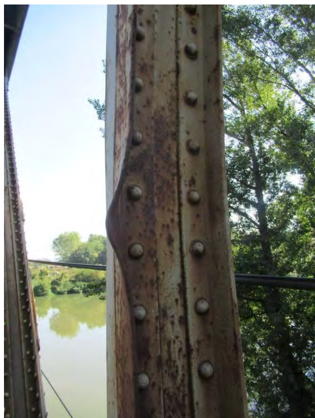
Механичко оштећење вертикале IV' десног решеткастог носача конструкције K2
