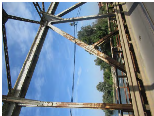
Површинска корозија - главнирешеткасти носач конструкције K3
