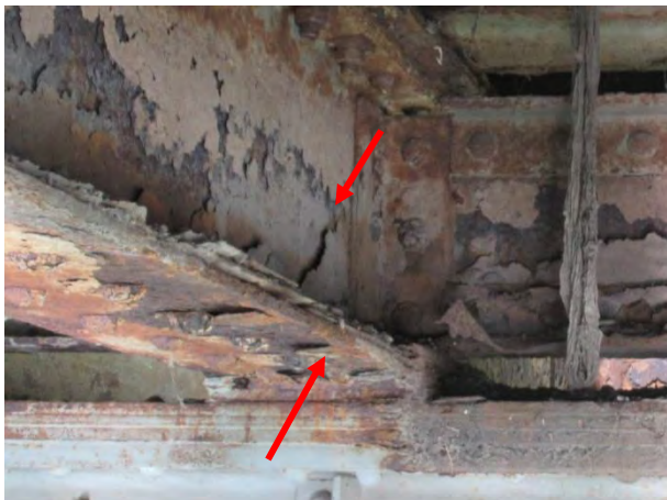
Дубинска корозија и деградација подужног носач- Зона ослањања носача 5 на попречни носач 3
