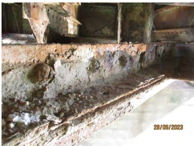
Оштећене заковице доњег спрега за ветар услед дубинске корозије
