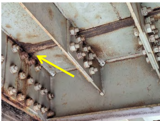
Трагови процуривања на месту монтажнoг наставка - поље 5-4'
