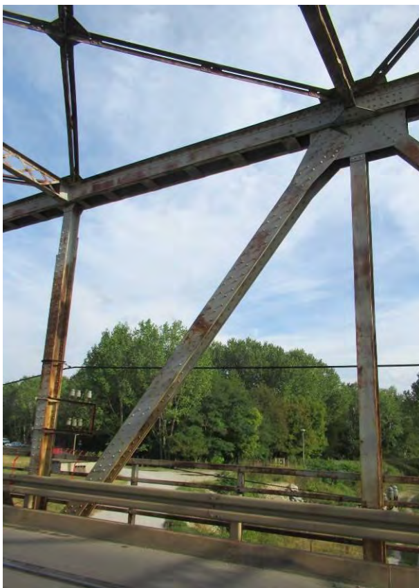
Вертикале левог и десног решеткастог носача конструкције K4
