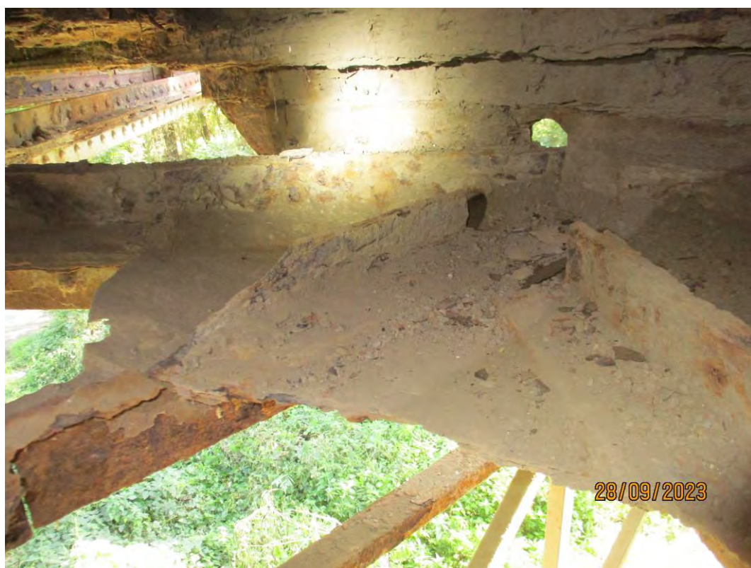
Чворни лимови спрега за кочење у првом пољу конструкције К1
