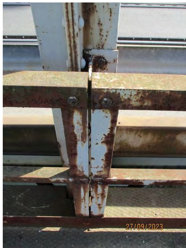
Стубови унутрашње ограде пешачке стазе код вертикала конструкција К1-К3
