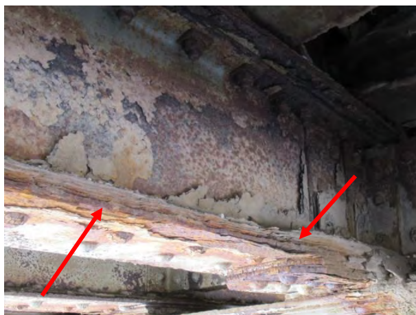
Дубинска корозија доње фланше и губитак попречног пресека носача 3 у пољу 3'-2'
