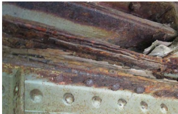
Дубинска корозија са умањењем основног пресека површине и лиснатом корозијом вертикале спрега за бочне ударе које се налазе изнад попречних носача
