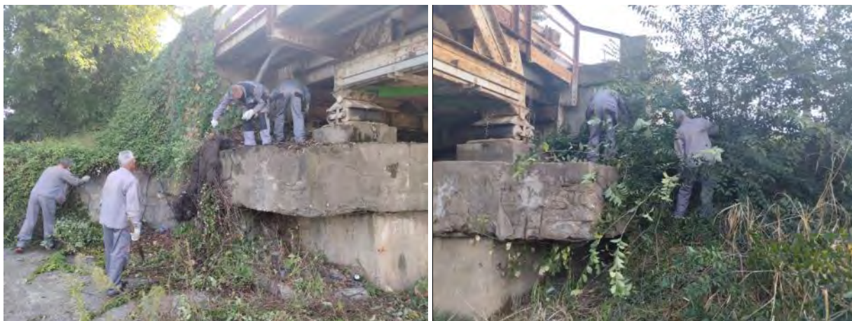
Чишћење вегетације на обалном стубу C5
