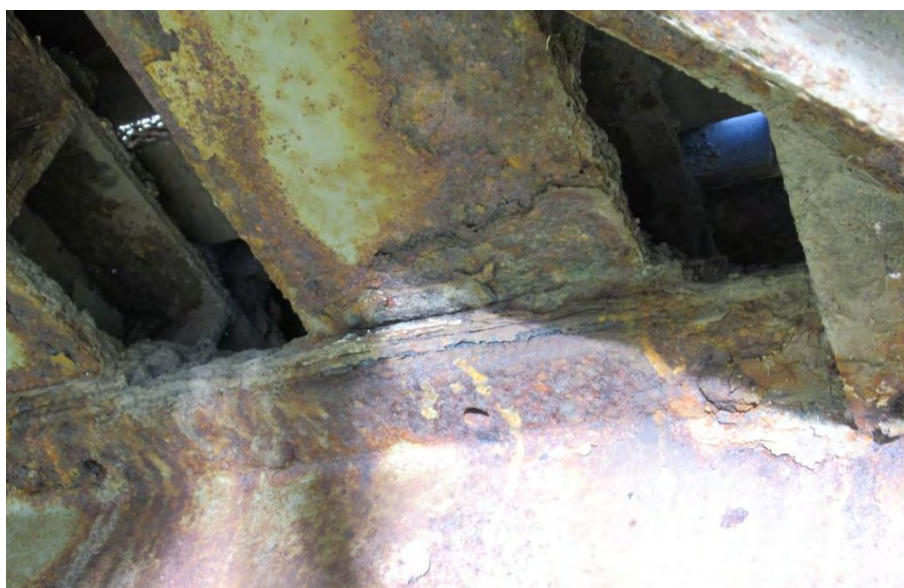
Завртњеви захваћени дубинском корозијом и недостатак неколико завртњева на вези секундарних попречних носача коловоза и подужних носача
