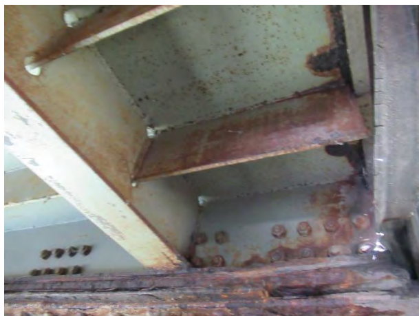
Површинска корозија орто-плоче у зони дилатације конструкције K4
