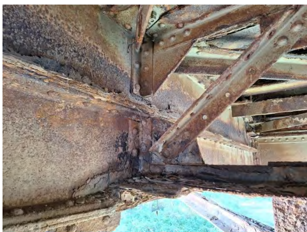
Дубинска корозија ребра у зони прикључка попречног укрућења подужних носача
