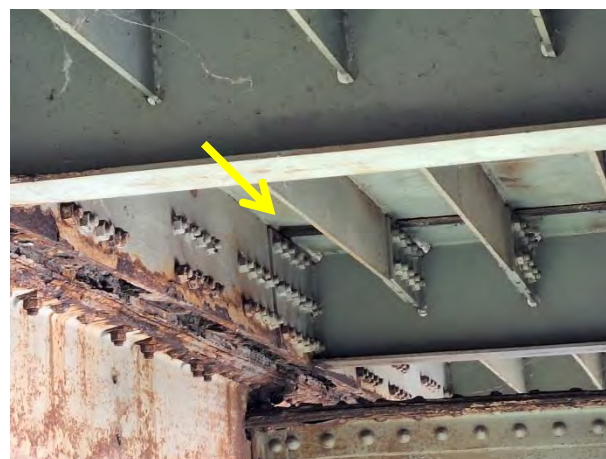
Трагови процуривања на месту монтажнoг наставка - поље 4'-3'
