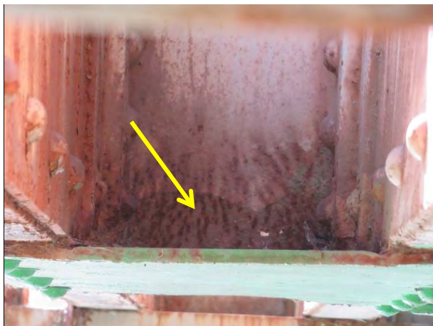
Тачкаста дубинска корозија ребра вертикале узводне решетке
