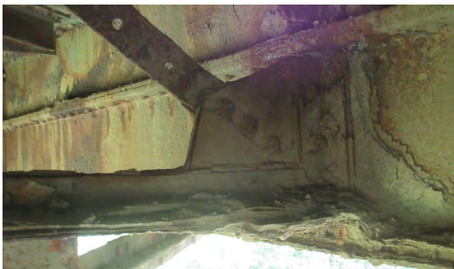
Лоше стање заковица на везама штапова и чворних лимова попречних укрућења и чворних лимова укрућења и подужних носача
