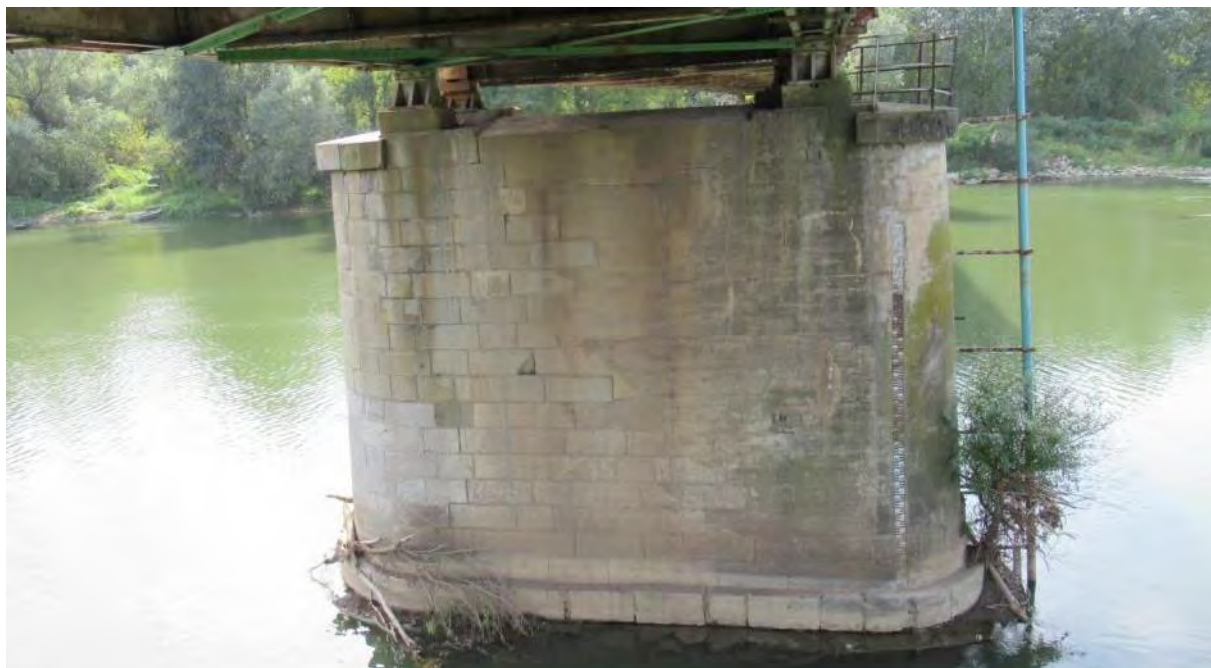
Страна стуба ка стубу С5. Развијена вегетација са низводне стране. Нанос са узводне стране стуба
