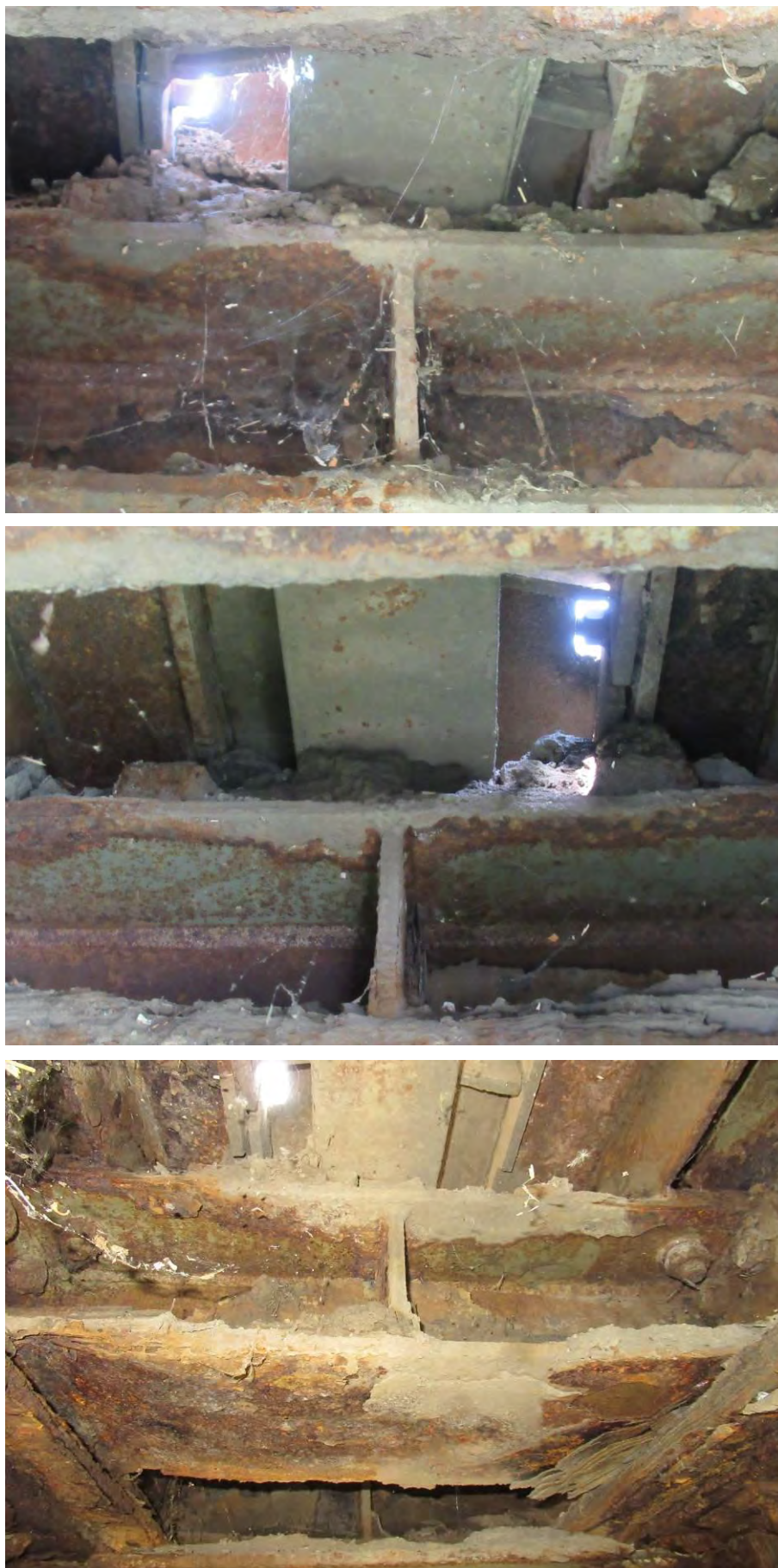
Наслаге земљаног материјала и отпада на горњем и доњем лиму секундарних попречних носача коловоза
