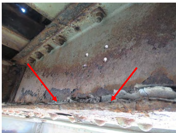
Дубинска корозија доње фланше и губитак попречног пресека носача 5 у пољу 0-1
