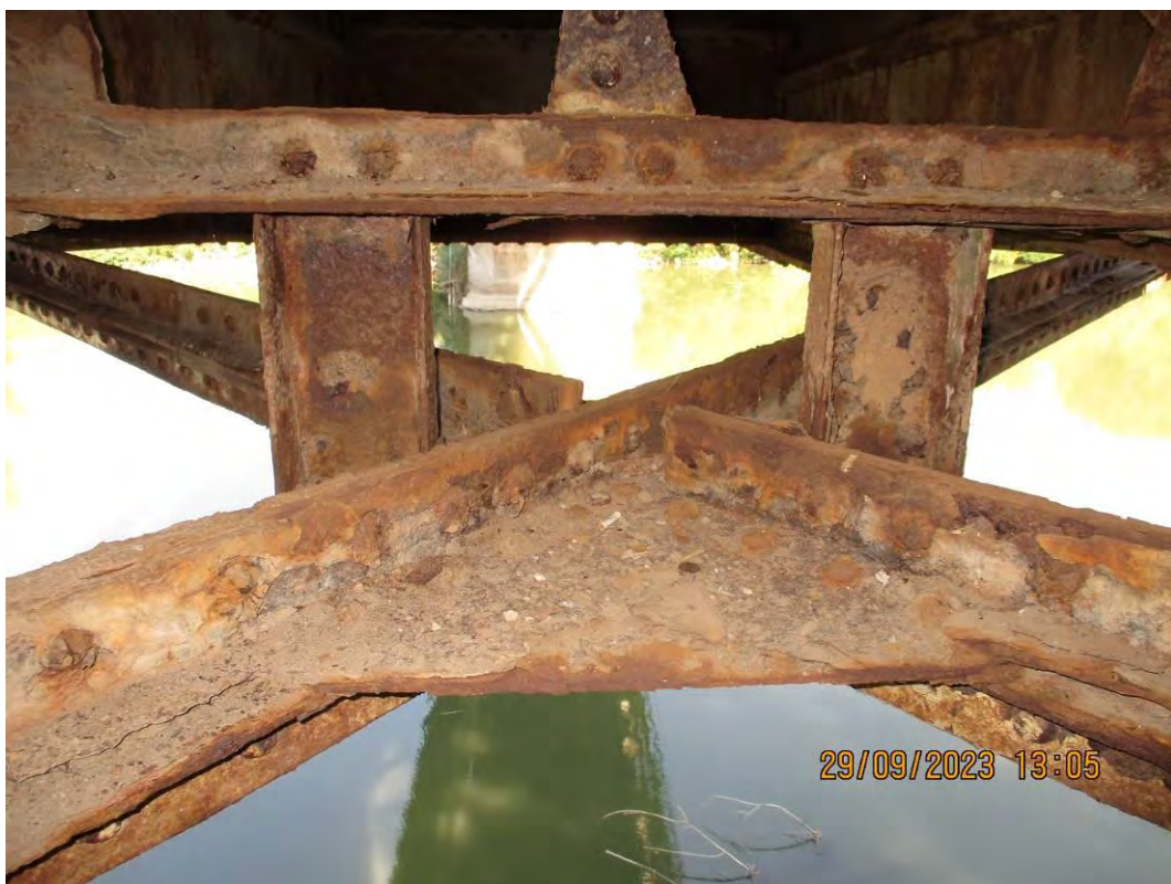
Дијагонале и чворни лим на укрштању дијагонала доњег спрега за ветар у првом пољу
