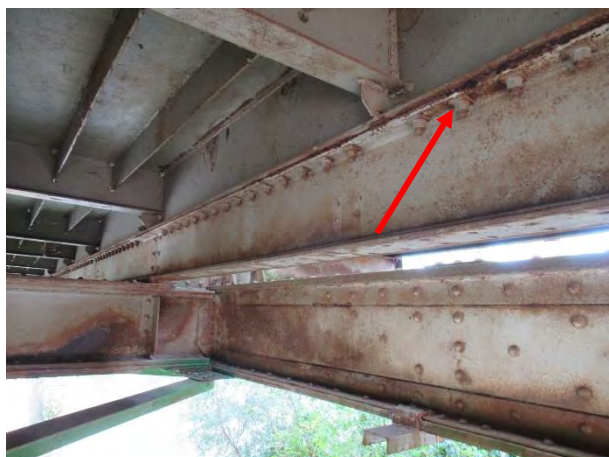
Локално појачана корозија са унутрашње стране низводног носача
