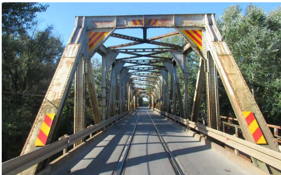
Излазни портални рам конструкције K2
