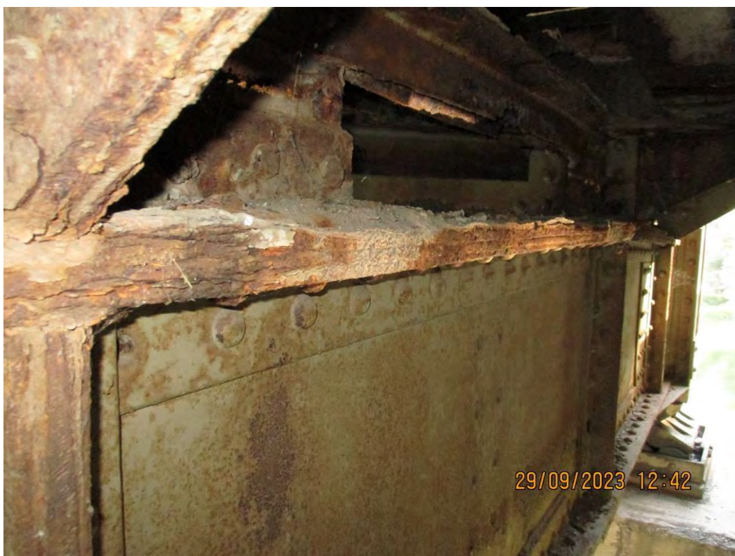
Попречни носач ПНО - дубинска корозија горње ножице и заковица
