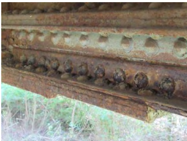
Зона континуитета десног (узводног) подужног носача код попречног носача ПН3' - појачана корозија доњег угаоника, вертикалног лима и заковица на споју угаоника
