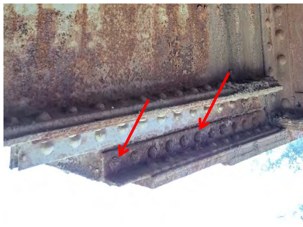
Зона континуитета десног (узводног) подужног носача код попречног носача ПН3' - дубинска корозија доњег угаоника, вертикалног лима и заковица на споју угаоника
