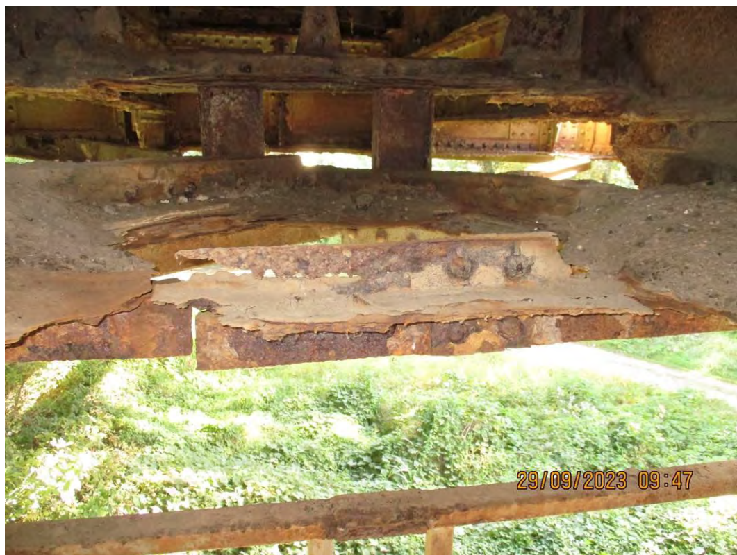
Вертикала спрега за кочење у првом пољу конструкције К2
