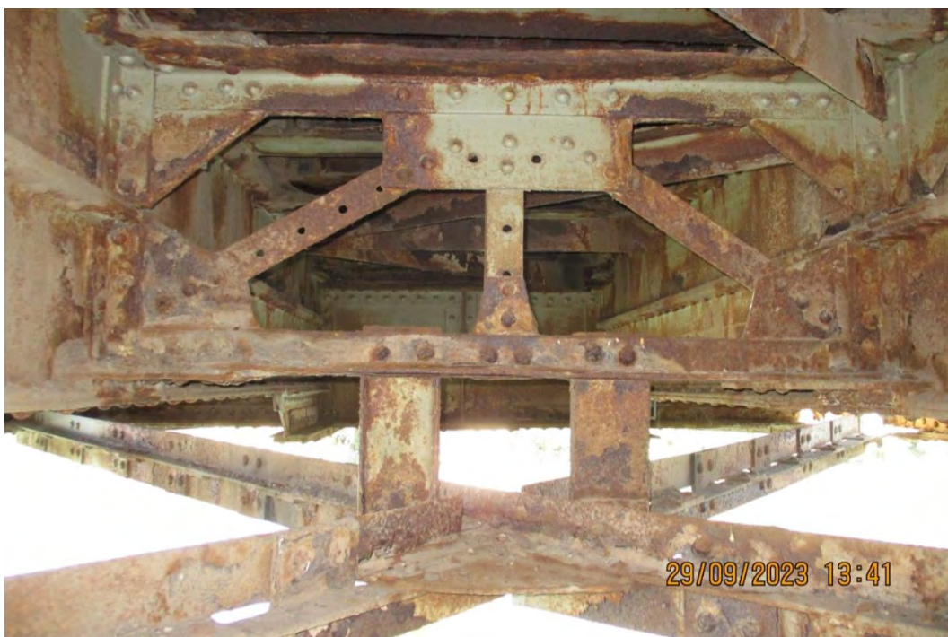
Попречна укрућења подужних носача конструкције КЗ
