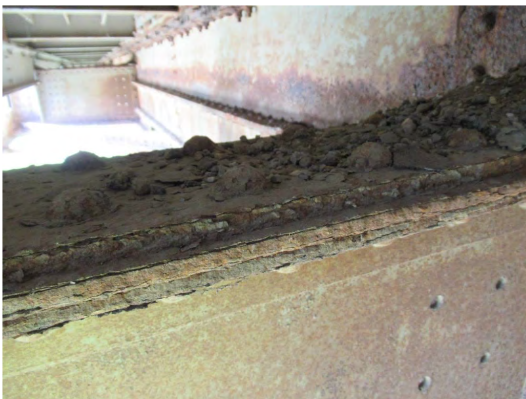
Попречни носач ПНО' стање горње ножице и заковица
