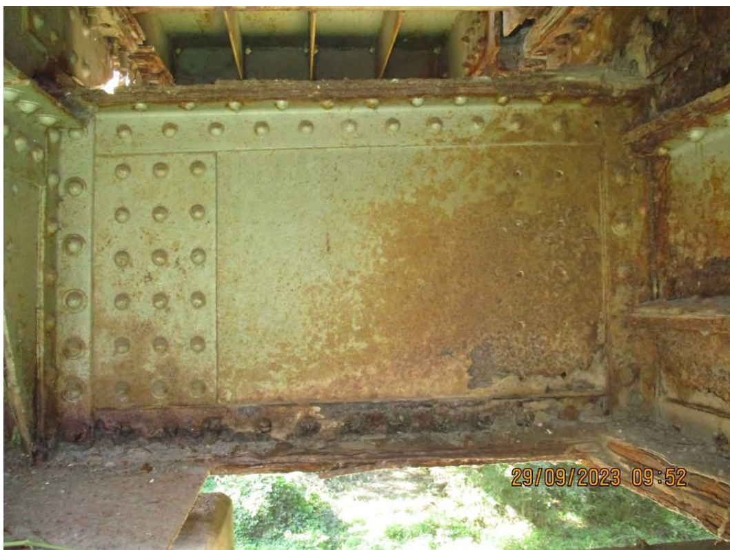
Попречни носач ПН0 - страна ка ПН1 вертикални лим у зони подужних носача захваћен дубинском корозијом
