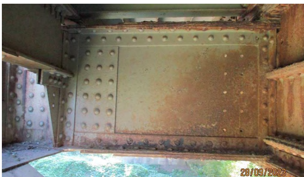
Вертикални лим попречних носача у зони подужних носача захваћен дубинском корозијом
