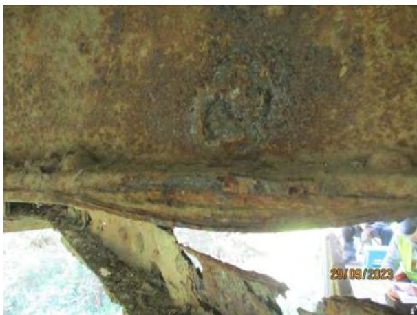
Деформација доње ламеле услед дубинске корозије и недостатка заковице у споју - леви подужни носач у пољу 3'-2'
