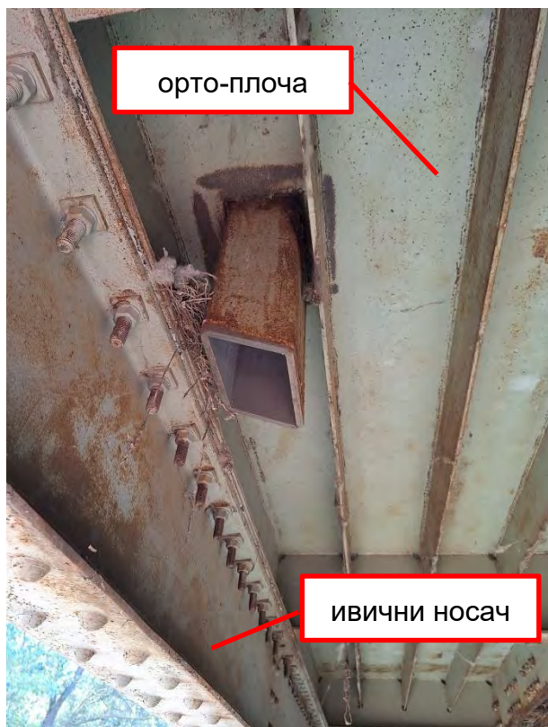
Сливничке вертикале захваћене површинском корозијом, недовољне дужине постављене на погрешан начин (краћа страна ближе ивичном носачу) - Конструкција К2
