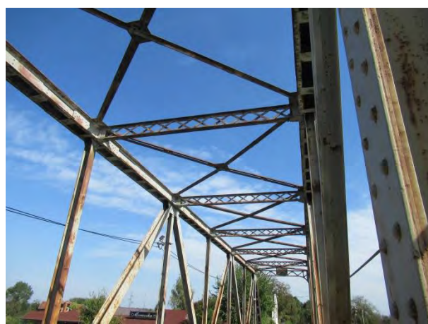
Површинска корозија - главнирешеткасти носач конструкције K4
