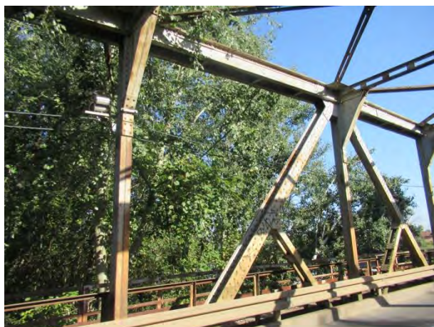
Површинска корозија - главнирешеткасти носач конструкције K2
