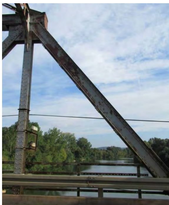
Дијагонале 0-1 левог и десног решеткастог носача конструкције K4
