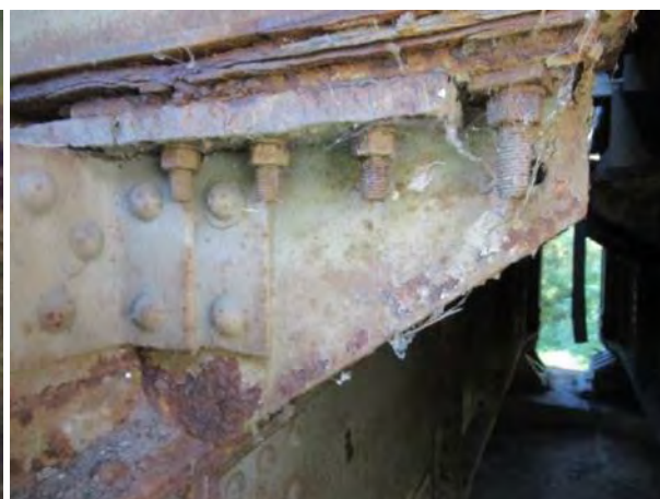
Конзоле подужних носача код попречног носача ПНО'
