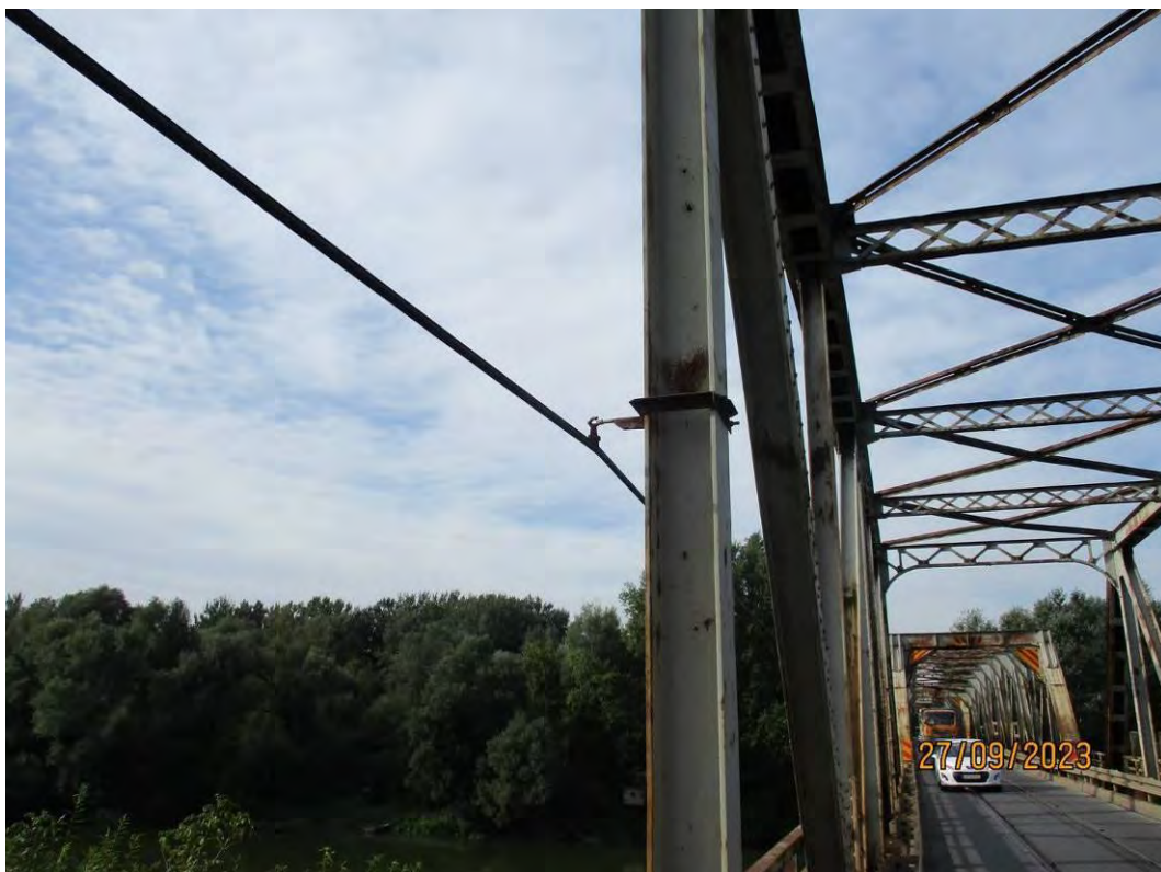
Новији носачи инсталација на десној страни моста
