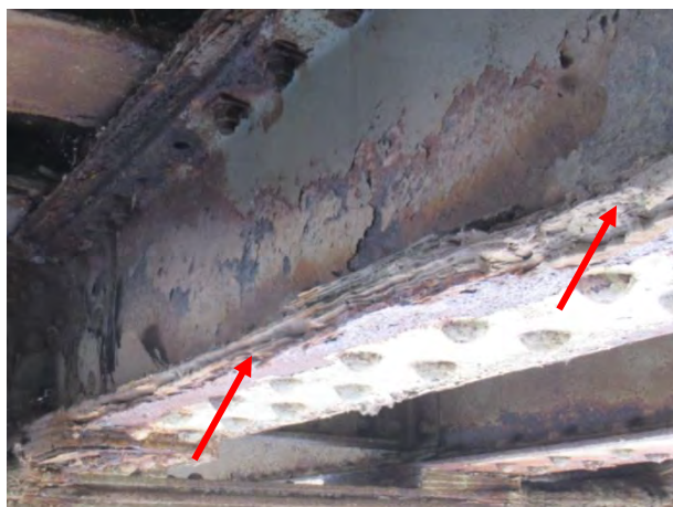
Дубинска корозија доње фланше и губитак попречног пресека носача 3 у пољу 4'-3'
