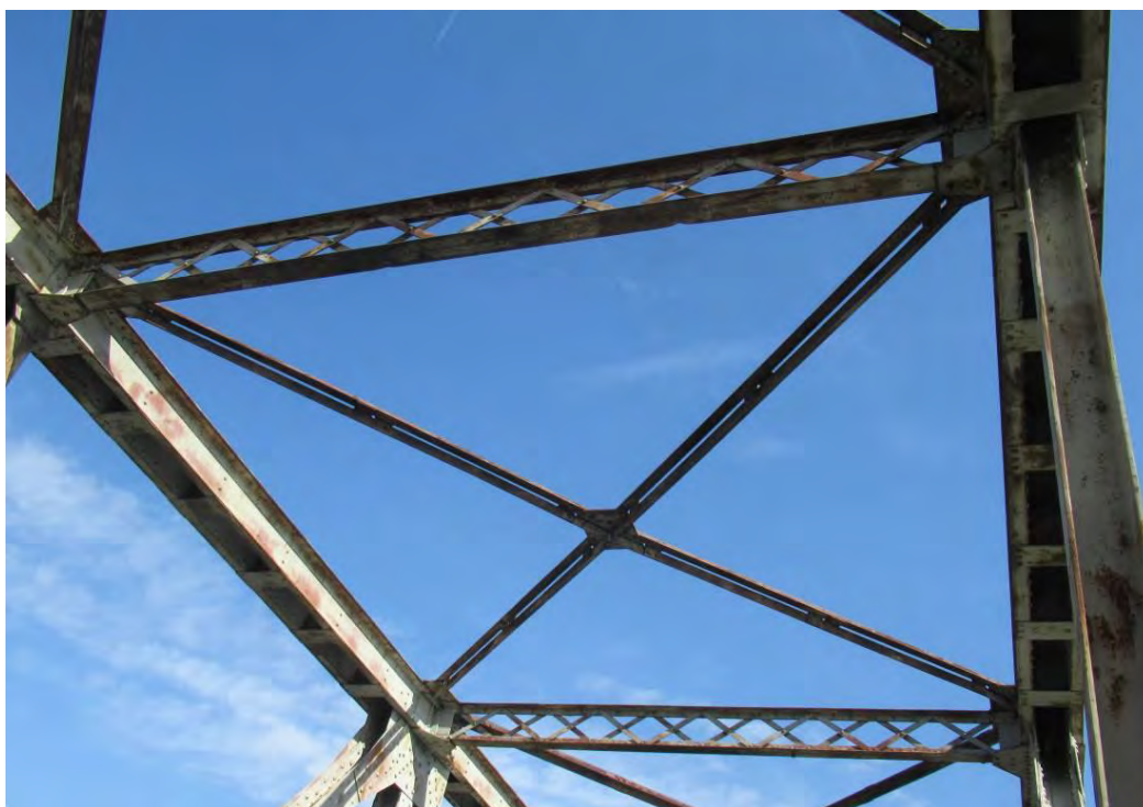
Горњи спрег за ветар конструкције K4
