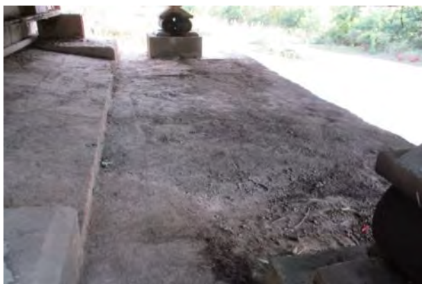
Лежишна греда - деградирана горња површина бетона
