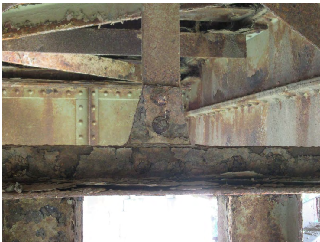
Лисната корозија неколико вертикала попречних укрућења подужних носача конструкције КЗ
