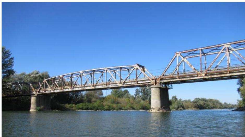
изглед конструкција са узводне стране
