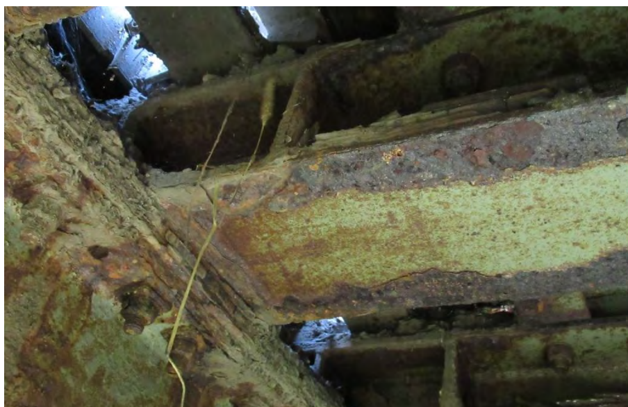
Везе секундарних попречних носача коловоза и подужних носача
