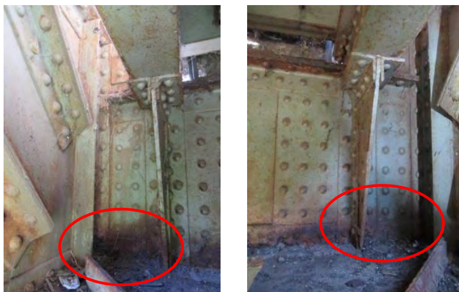
Попречни носач ПН0 ка ПН1 - зачеци дубинске корозије у доњој зони везе
