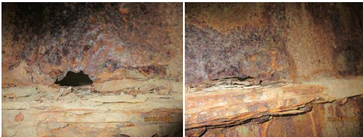
Деградација ребра левог подужног носача у пољу 4'-3', местимично - прекид везе за доњом фланшом
