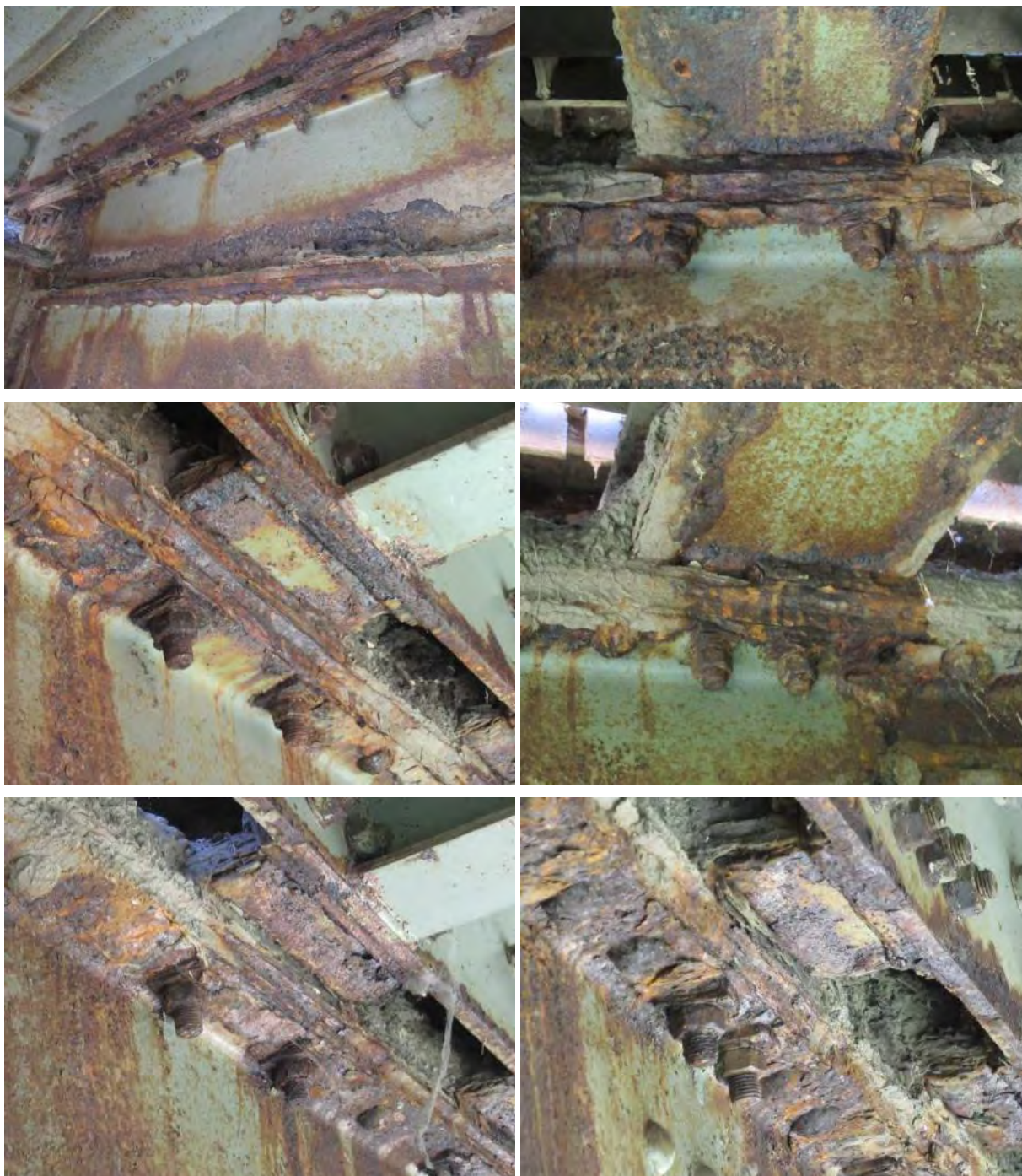
Дубинска корозија горње фланше и спојних средстава код оба горња носача, посебно у зонама ослањања секундарних попречних носача
