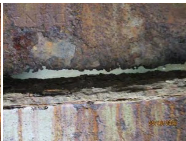
Деградација ребра левог подужног носача у пољу 3-4, дужине око 100ст - прекид везе за доњом фланшом
