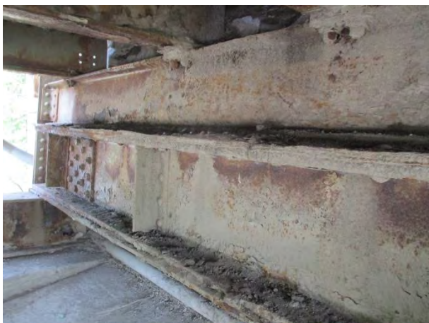
Ослоначка конструкција захваћена корозијом
