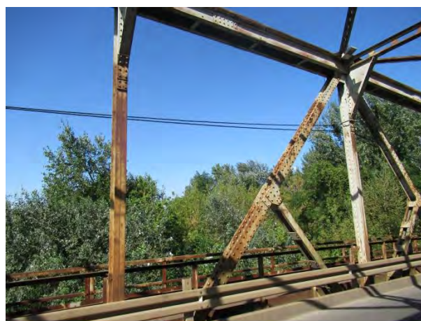
Површинска корозија - главни решеткасти носач конструкције К1
