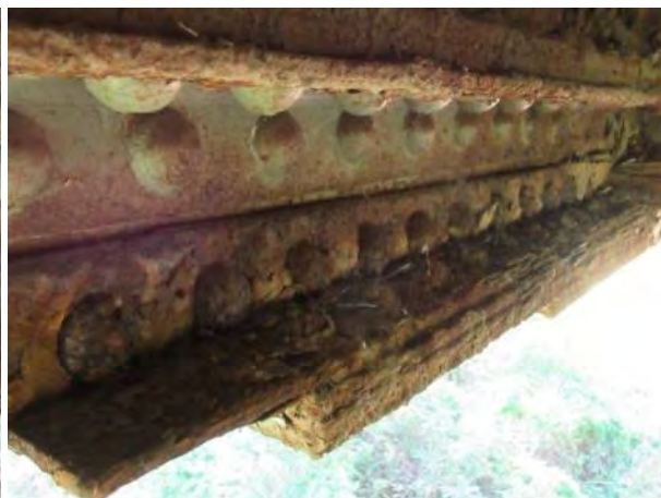
Зона континуитета десног (узводног) подужног носача код попречног носача ПН3' - појачана корозија доњег угаоника, вертикалног лима и заковица на споју угаоника
