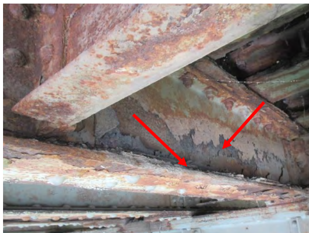
Дубинска корозија доње фланше и губитак попречног пресека носача 4 у пољу 2-3
