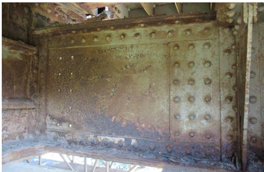
Попречни носач ПНО' - унутрашња страна - вертикални лим захваћен дубинском корозијом
