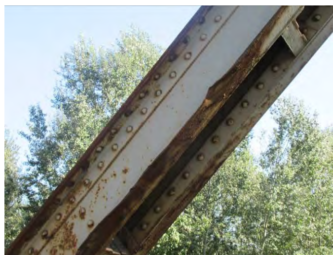
Механичка оштећења дијагонале I'-0' десног решеткастог носача конструкције K1
