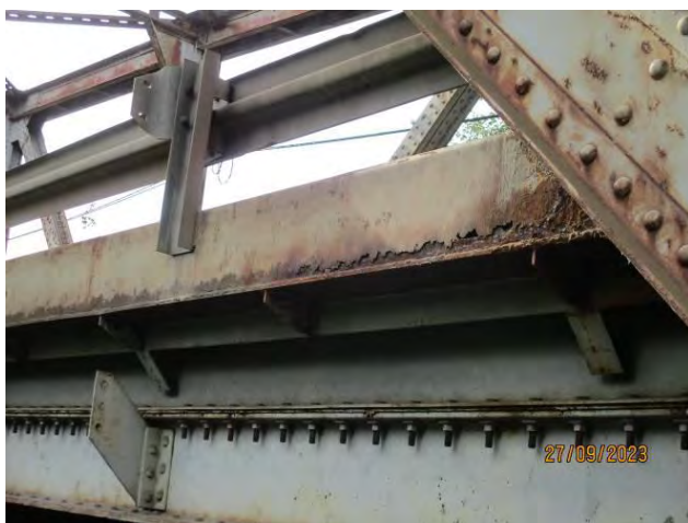
Велика оштећења челика десног ивичњака у зонама усецања ивичњака код ојачаних дијагонала
