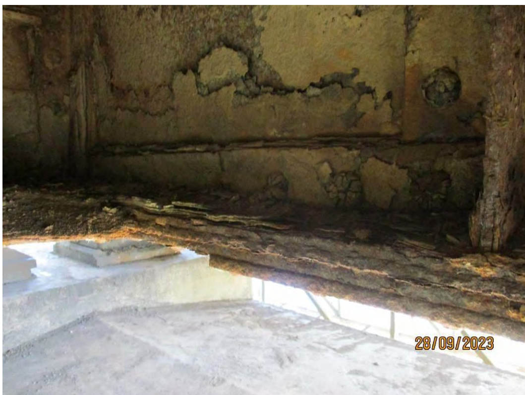
Попречни носач ПНО' - дубинска корозија горње и доње ножице и стање заковица
