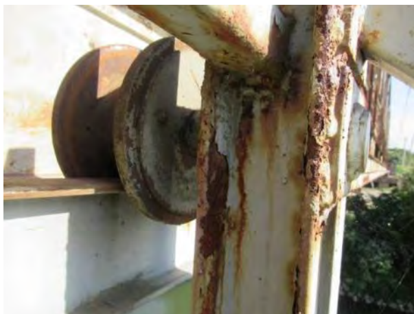
Лошије изведени заварени спојеви захваћени површинском корозијом
