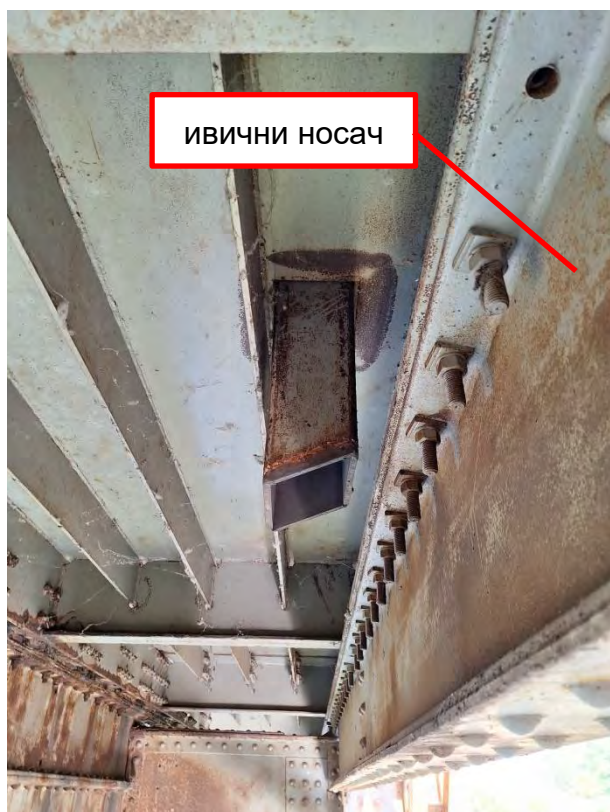
Сливничке вертикале захваћене површинском корозијом, недовољне дужине постављене на погрешан начин (краћа страна ближе ивичном носачу) - Конструкција К3
