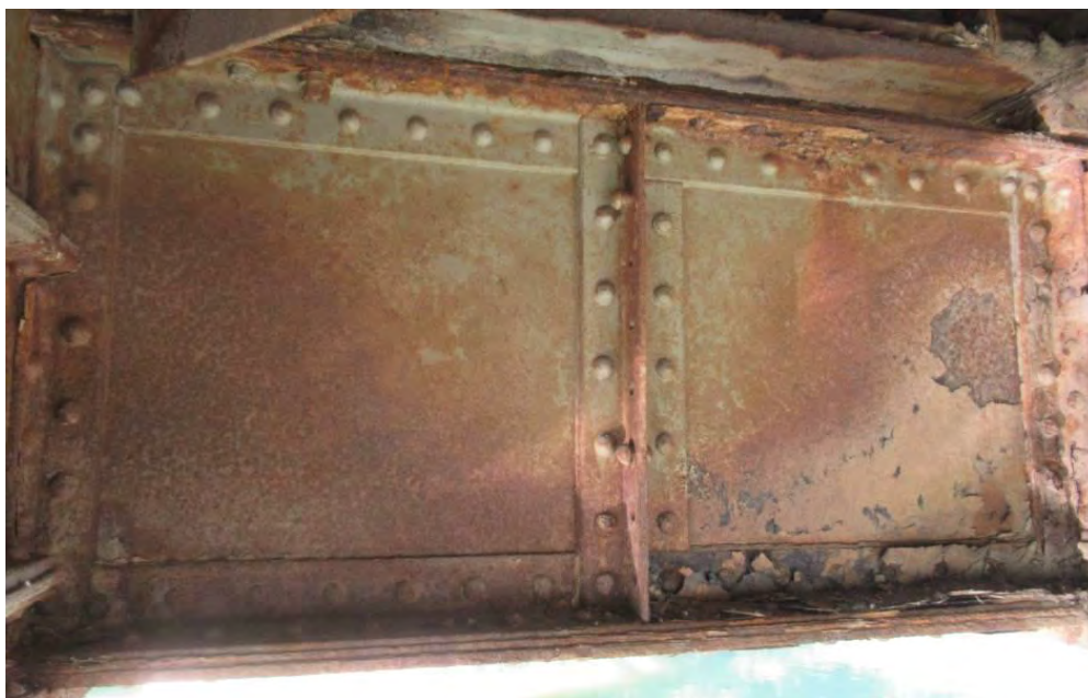
Средњи део попречних носача захваћен дубинском корозијом местимично са умањењем пресека
