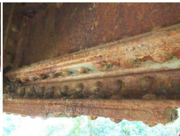
Зона континуитета десног (узводног) подужног носача код попречног носача ПН5 - појачана корозија доњег угаоника, вертикалног лима и заковица на споју угаоника
