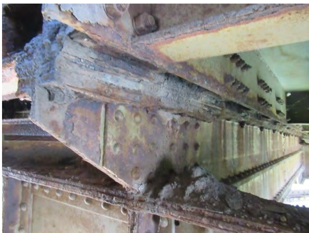
Дубинска корозија конзоле подужног носача
