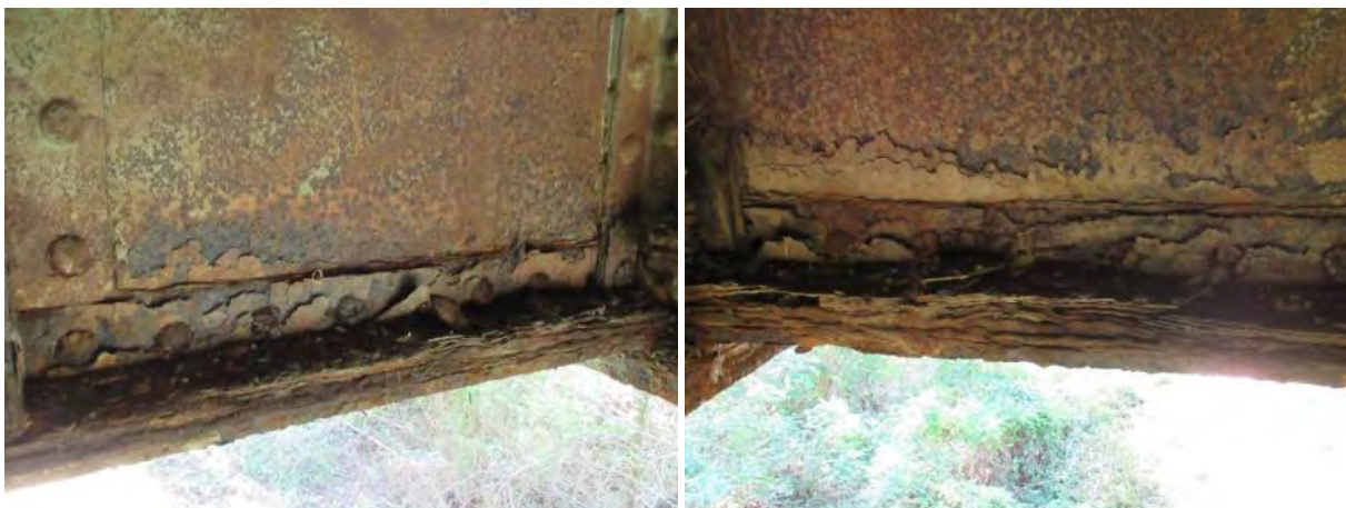
Средњи део ПН3', доњи појас - изражена дубинска корозија са тоталном деградацијом угаоника
