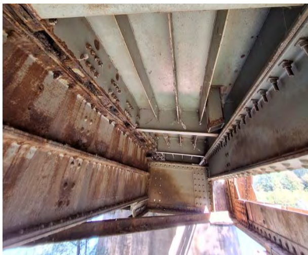
Дубинска корозија у зони споја ребра и доње фланше у свим осталим пољима конструкције К2
