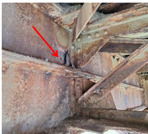
Дубинска корозија ребра у зони прикључка попречног укрућења подужних носача
