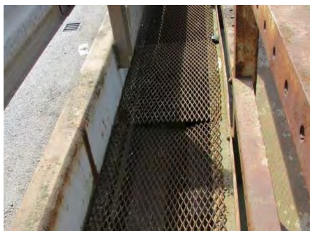
Локална деформација развученог лима на левој страни моста
