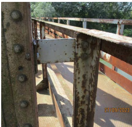
Веза унутрашње ограде пешачке стазе за вертикале конструкција К1-К3
