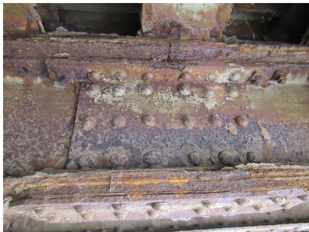
Дубинска корозија подвезица монтажних наставка носача 4 у пољу 4'-3'
