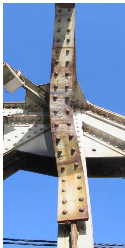
Механичко оштећење левог укрућења излазног порталног рама конструкције К2
