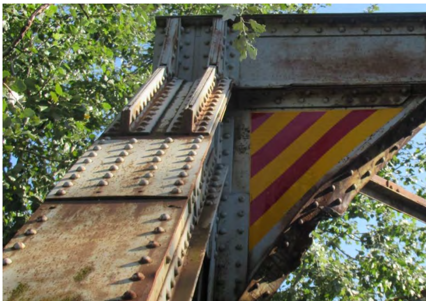
Недостатак заковица у горњем делу дијагонале O-I левог решеткастог носача конструкције K2
