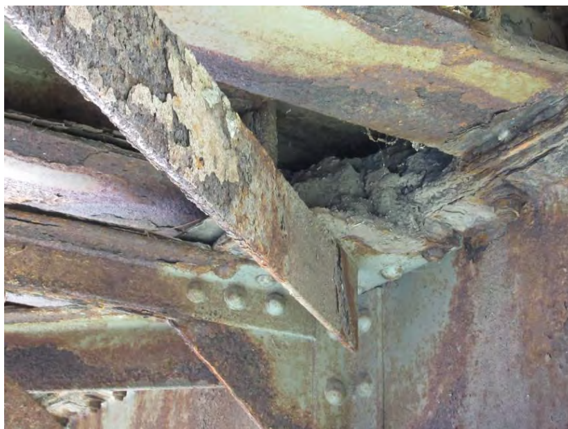
Веза дијагонале и чворног лима спрега за бочне ударе изведена завртевима
