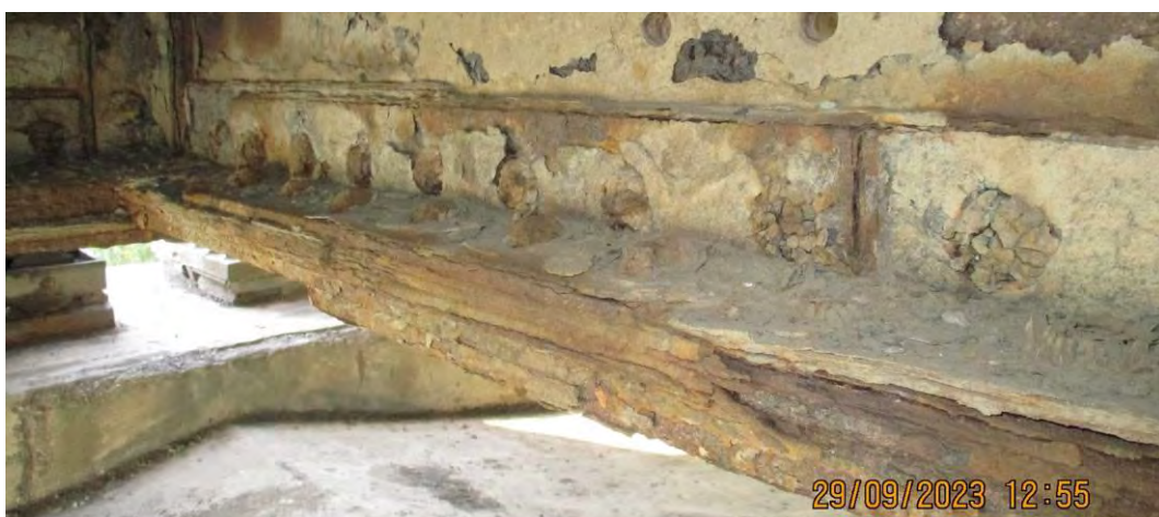
Попречни носач ПНО - стање заковица
