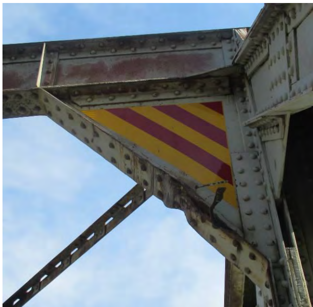
Механичко оштећење десног укрућења улазног порталног рама конструкције К3
