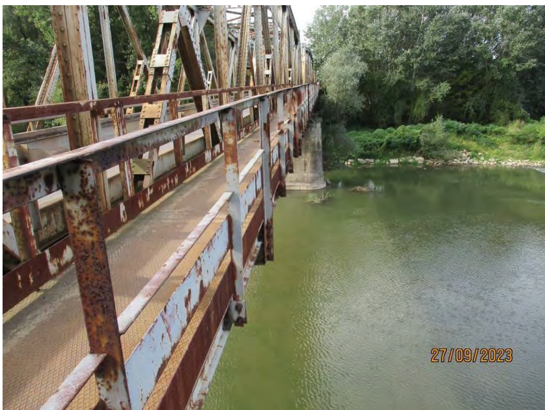
Спољна ограда пешачке стазе на конструкцији КЗ
