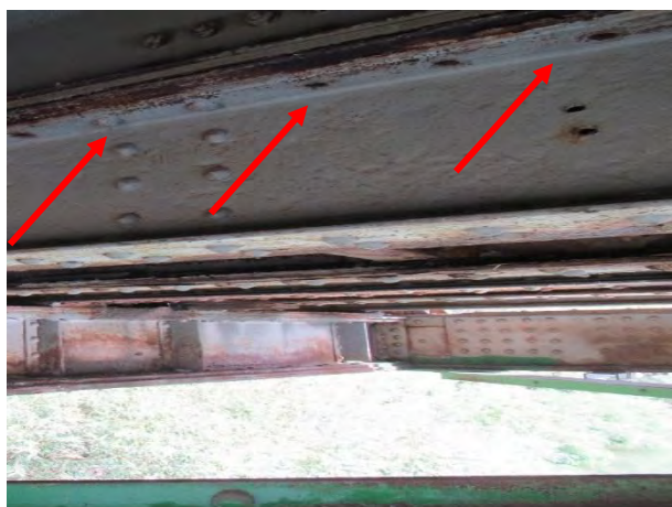
Недостају завртњеви на вези горње фланше носача 2 и орто-плоче у пољу 2-3
