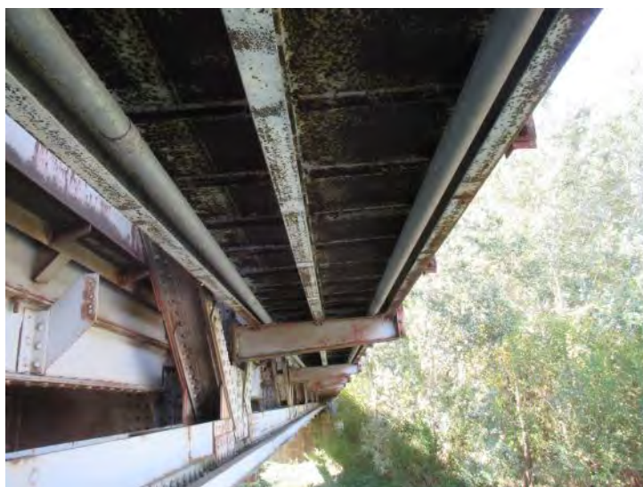
Конзоле пешачке стазе на конструкцији K2
