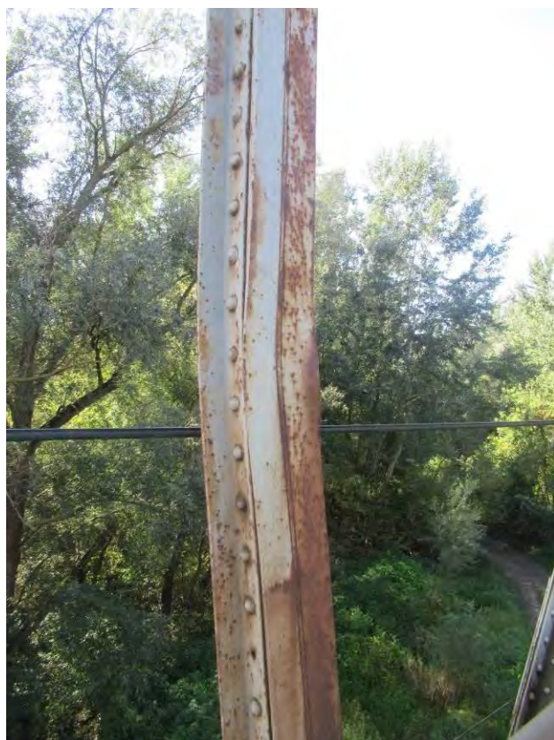
Механичко оштећење вертикале IV' десног решеткастог носача конструкције K2
