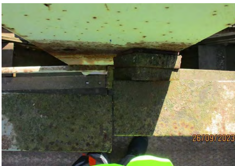
Недостатак спојног средства на вези рукохвата унутрашње ограде за вертикалу конструкције K4
