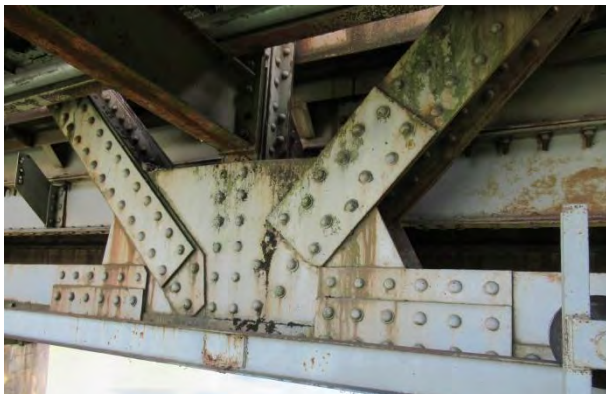
Чворови доњег појаса - генерално у добром стању, захваћени површинском корозијом
