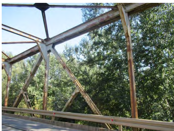
Површинска корозија - главни решеткасти носач конструкције К1
