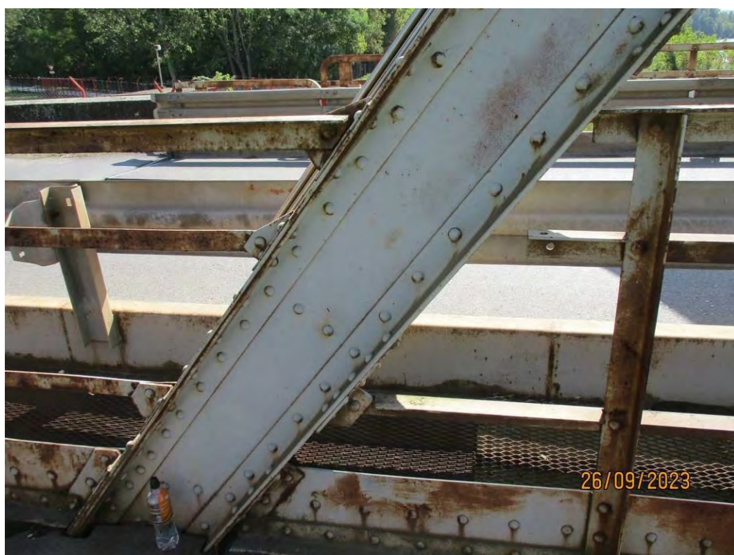
Веза и детаљ унутрашње ограде на конструкцији К4 код последње дијагонале решеткиастог носача
