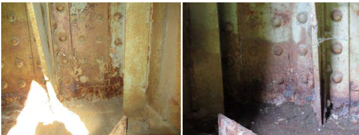
Попречни носач ПН0 ка ПН1 - зачеци дубинске корозије у доњој зони везе
