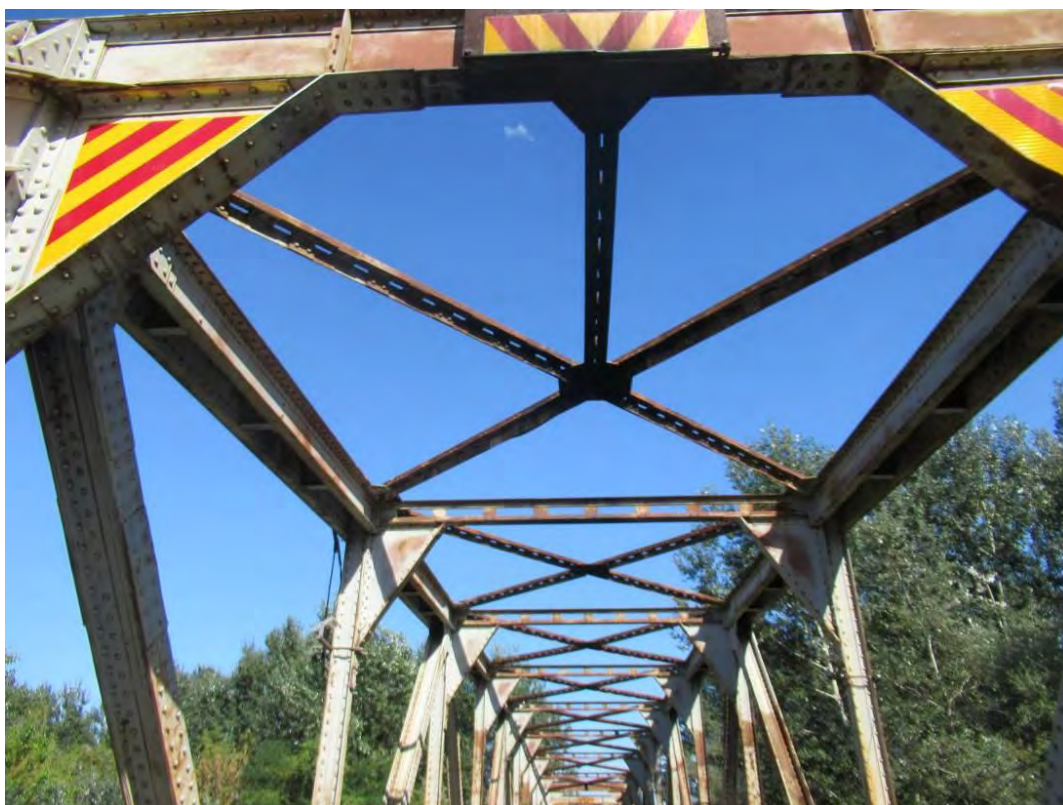
Горњи спрег за ветар конструкције K1
