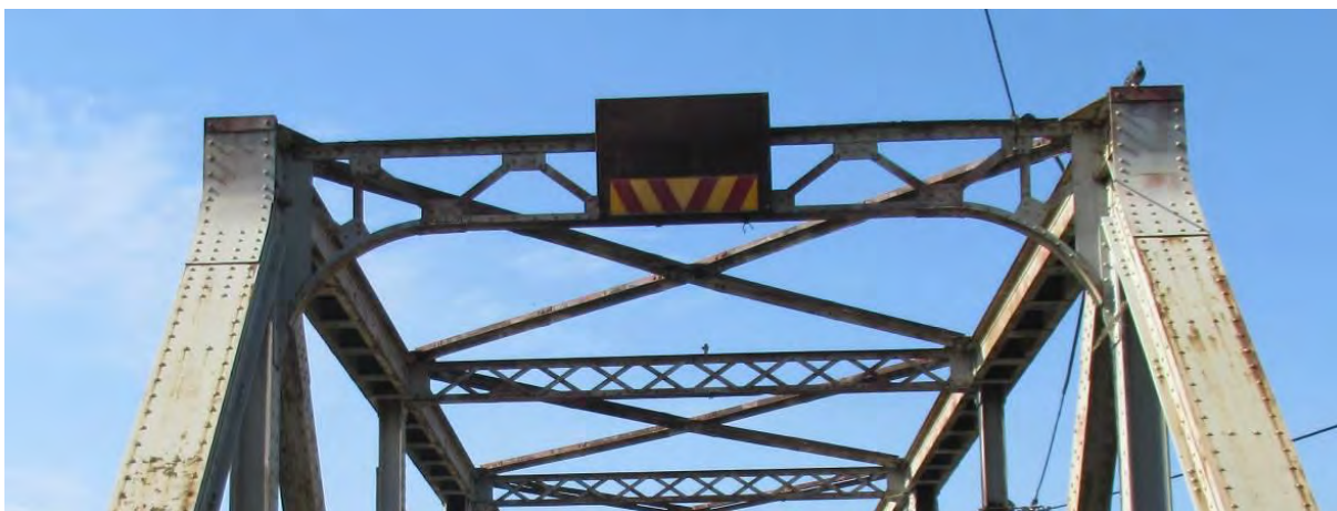
Излазни портални рам конструкције K4
