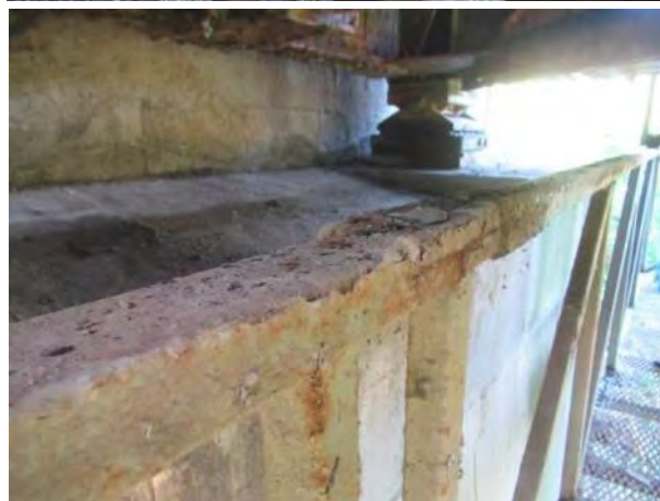
Изражена корозија средњег дела ревизионих колица, АКЗ тотално ван функције
