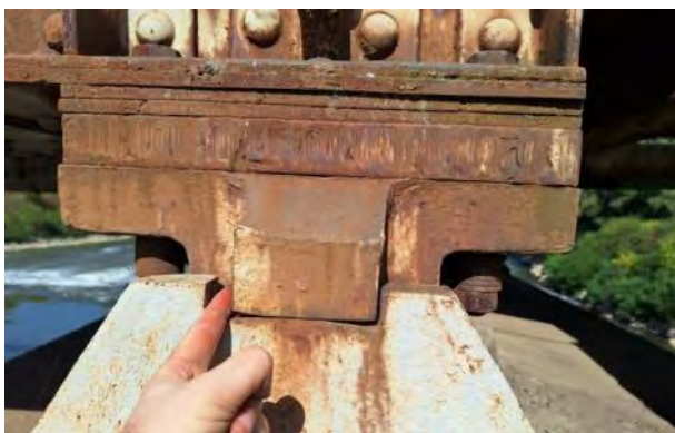
Зазор између граничника око 10mm.
