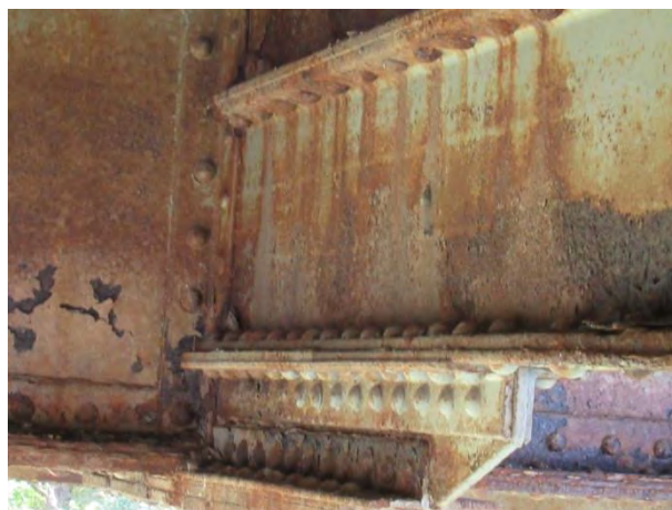
Доње зоне веза доњих подужних носача, унутрашња страна - појачана корозиј
