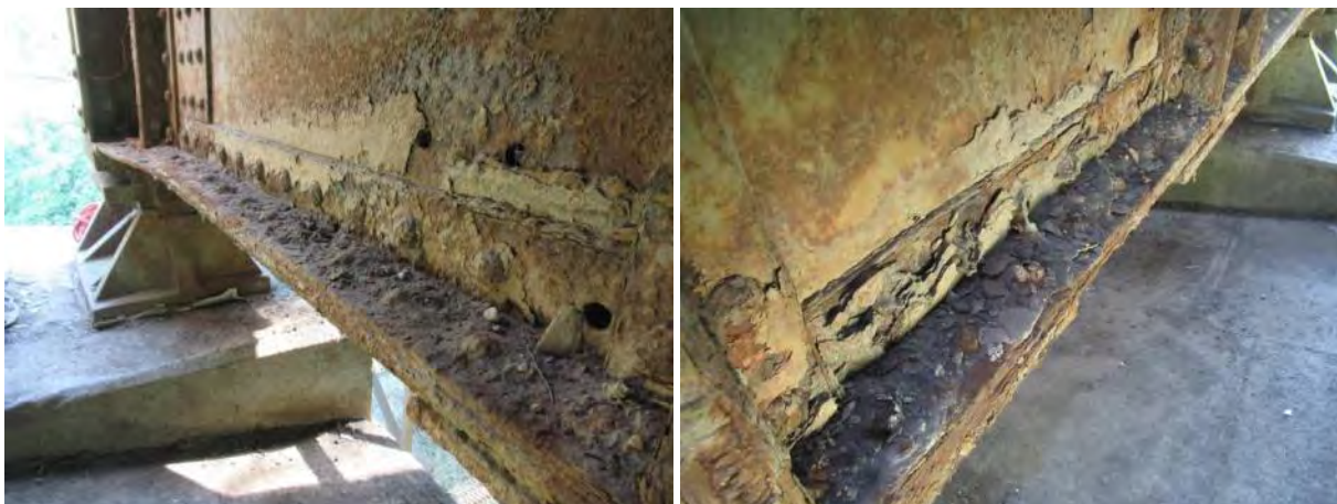
Попречни носач ПНО', ка конструкцији К2 - изражена дубинска корозија са листањем материјала и умањењем пресека лимова и угаоника доњег појаса
