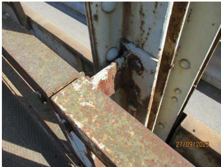
Веза унутрашње ограде пешачке стазе за вертикале конструкција К1-К3
