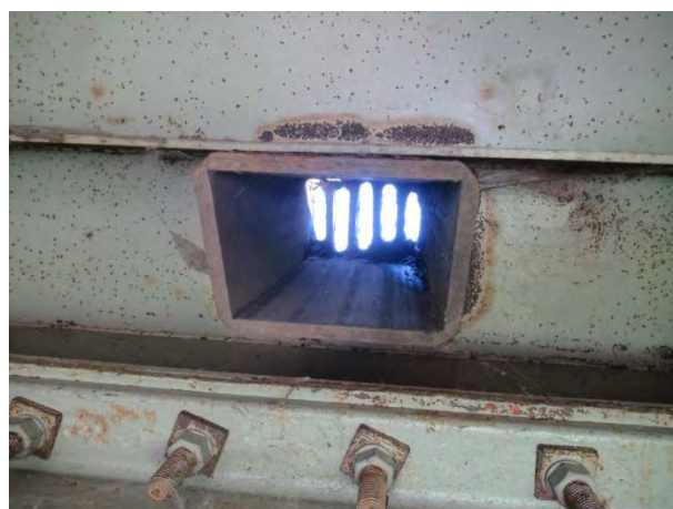
Сливничке вертикале захваћене површинском корозијом, недовољне дужине постављене на погрешан начин (краћа страна ближе ивичном носачу) - Конструкција К1
