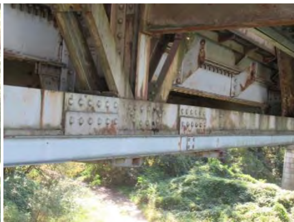
Шине и кратке конзоле генерално у добром стању
