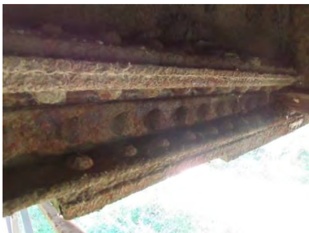
Зона континуитета десног (узводног) подужног носача код попречног носача ПН5 - појачана корозија доњег угаоника, вертикалног лима и заковица на споју угаоника
