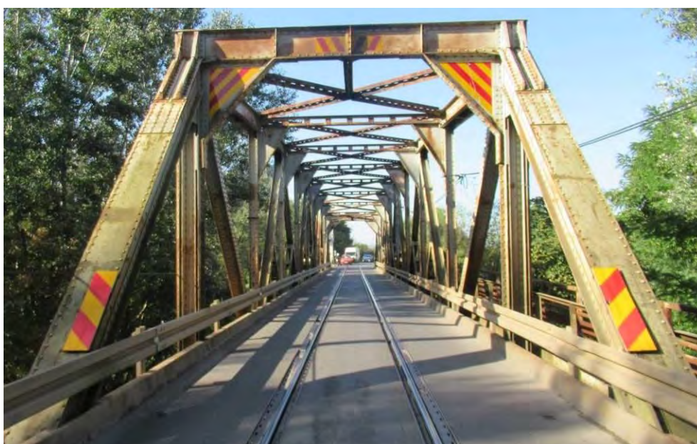
Излазни портални рам конструкције K1
