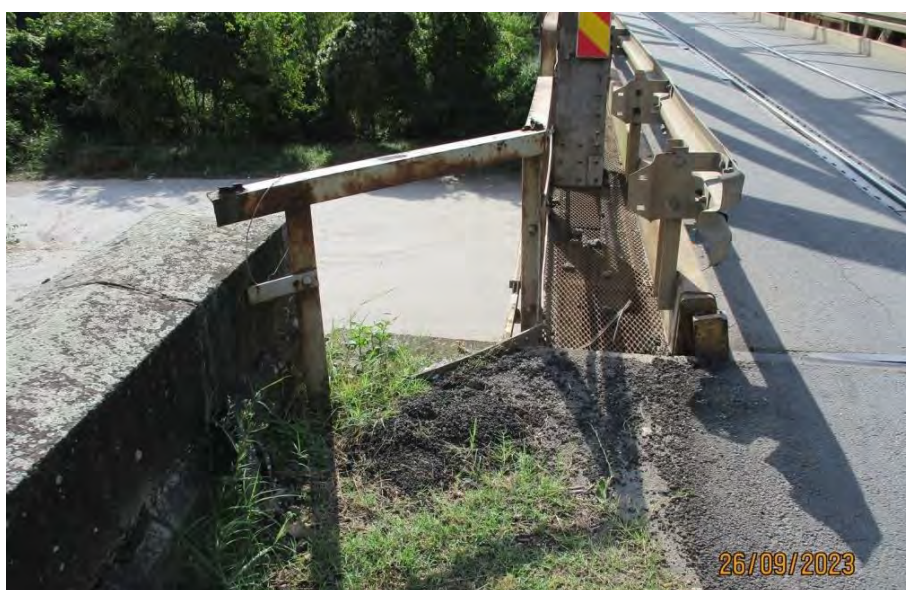
Крајњи сегмент десне ограде на конструкцији K4
