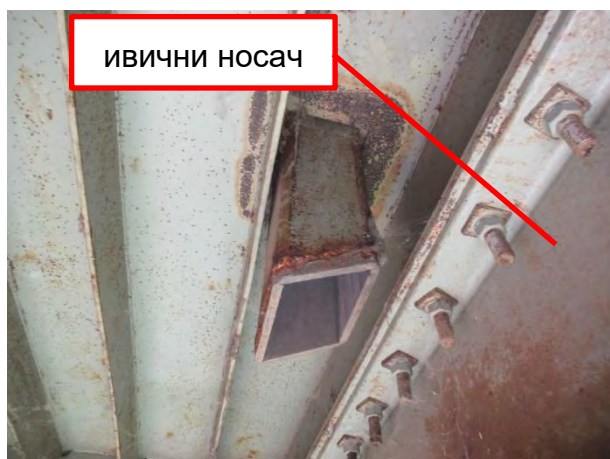
Сливничке вертикале захваћене површинском корозијом, недовољне дужине постављене на погрешан начин (краћа страна ближе ивичном носачу) - Конструкција К1
