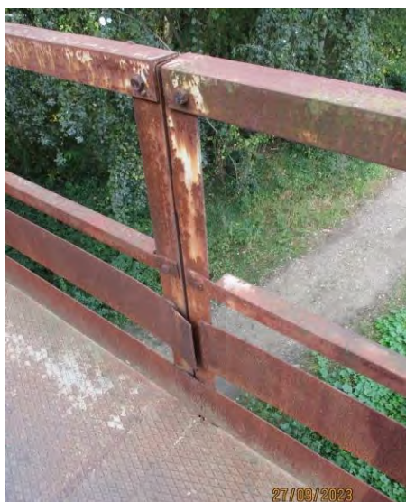
Локално прекинут горњи лим на средини распона C2-C3 (конструкција K2)
