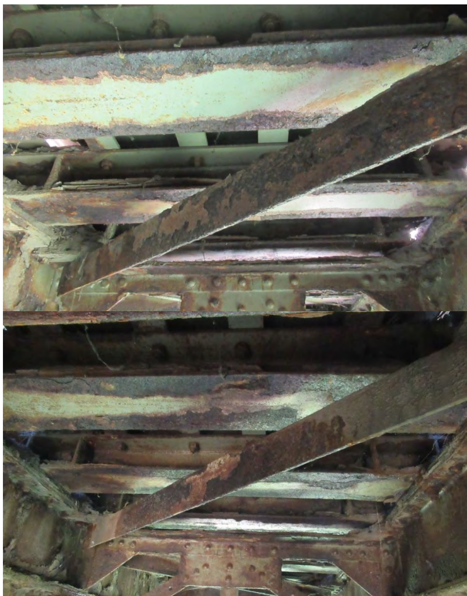
Секундарни попречни носачи коловоза конструкције К1
