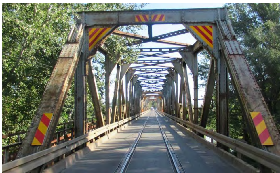
Улазни портални рам конструкције K2
