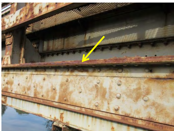
Дубинска корозија на горњој фланши и ребру доњег појаса
