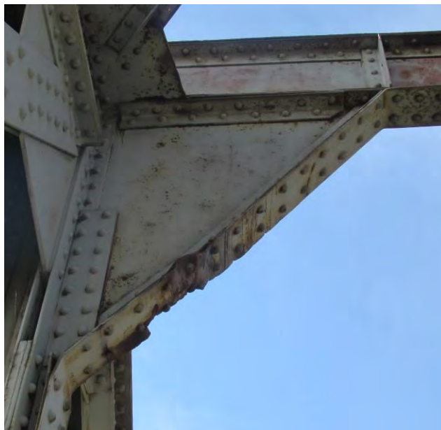
Механичко оштећење десног укрућења улазног порталног рама конструкције К3
