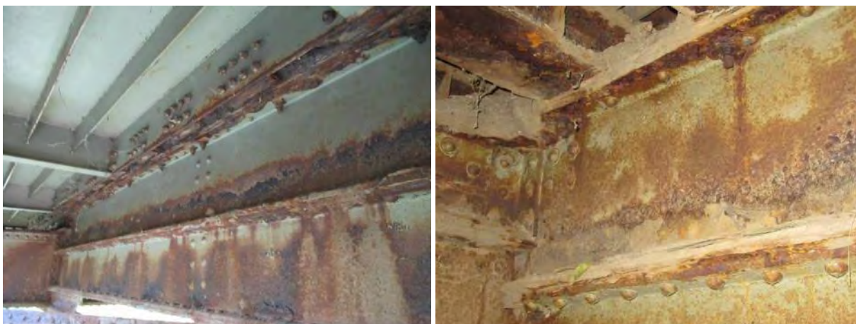
Дубинска корозија са листањем челика на десном (низводном) носачу у зони споја ребра и доње фланше - поље 1'-0'
