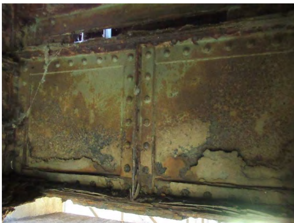
Попречни носач ПНО', ка конструкцији К2 - изражена дубинска корозија са листањем материјала и умањењем пресека лимова и угаоника доњег појаса
