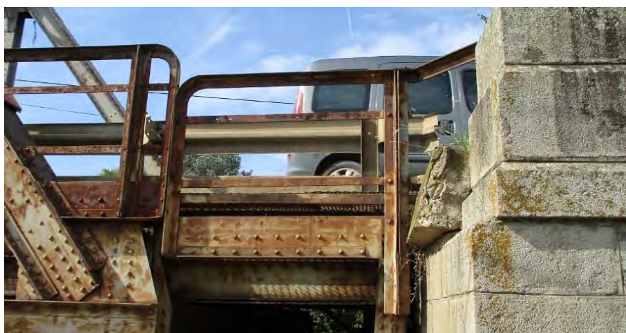
Прекинут горњи коленик десне ограде на конструкцији K4
