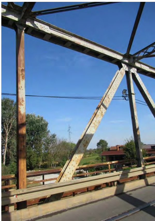
Вертикале левог и десног решеткастог носача конструкције K4
