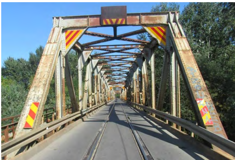
Улазни портални рам конструкције K1
