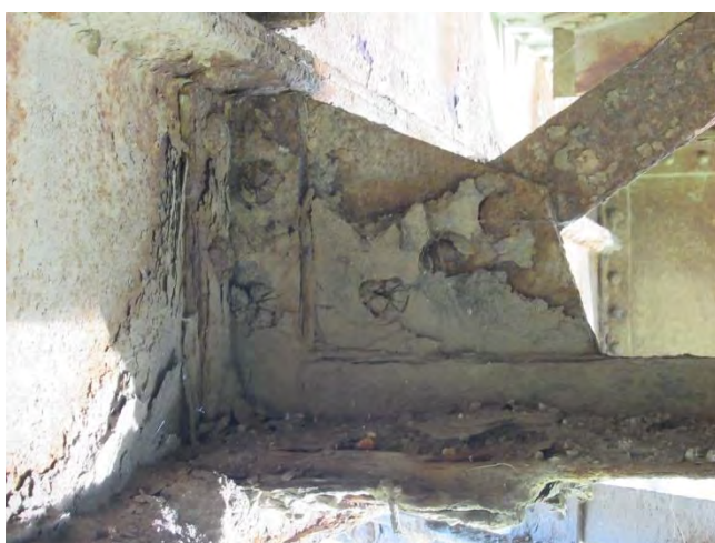
Лоше стање заковица у доњој зони попречних укрућења подужних носача конструкције КЗ
