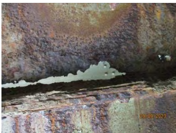
Деградација ребра левог подужног носача у пољу 4-5, дужине око 250ст - прекид везе за доњом фланшом
