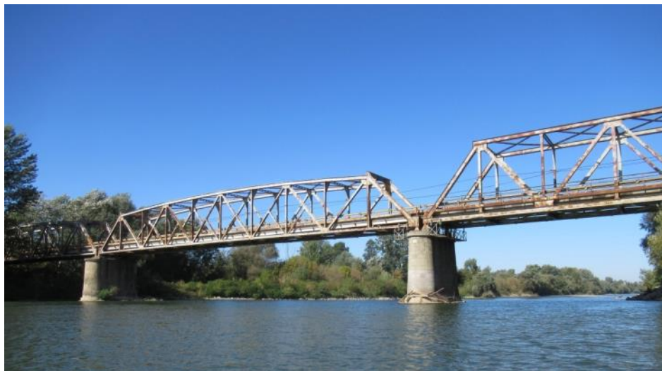
изглед конструкција са узводне стране
