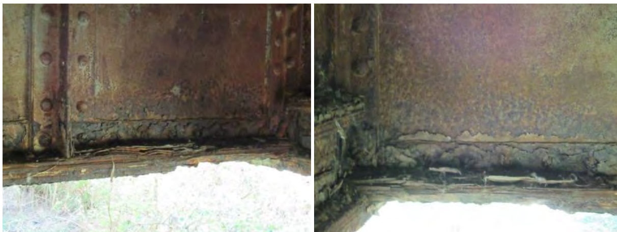
Средњи део ПНЗ', доњи појас - изражена дубинска корозија са тоталном деградацијом угаоника
