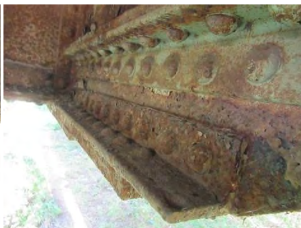
Зона континуитета десног (узводног) подужног носача код попречног носача ПН2' - појачана корозија доњег угаоника, вертикалног лима и заковица на споју угаоника
