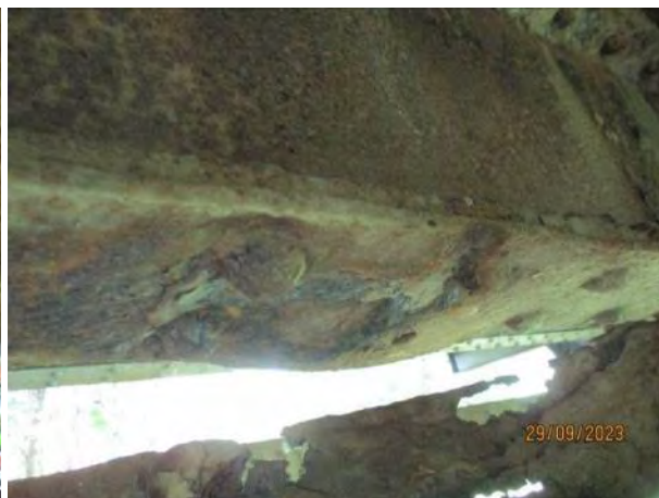
Деформација доње ламеле услед дубинске корозије и недостатка заковице у споју - леви подужни носач у пољу 3'-2'
