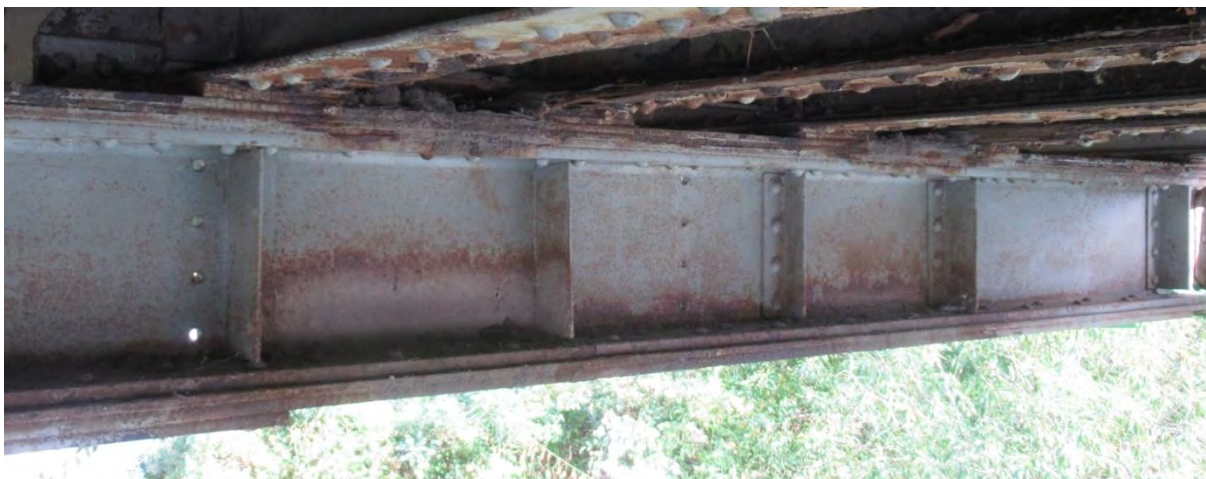
Попречни носачи конструкције K4
