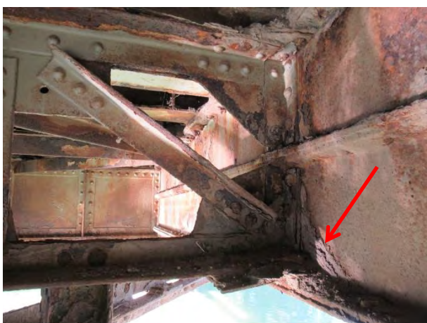
Дубинска корозија ребра са зачецима деградације материјала у зони прикључка попречног укрућења подужних носача
