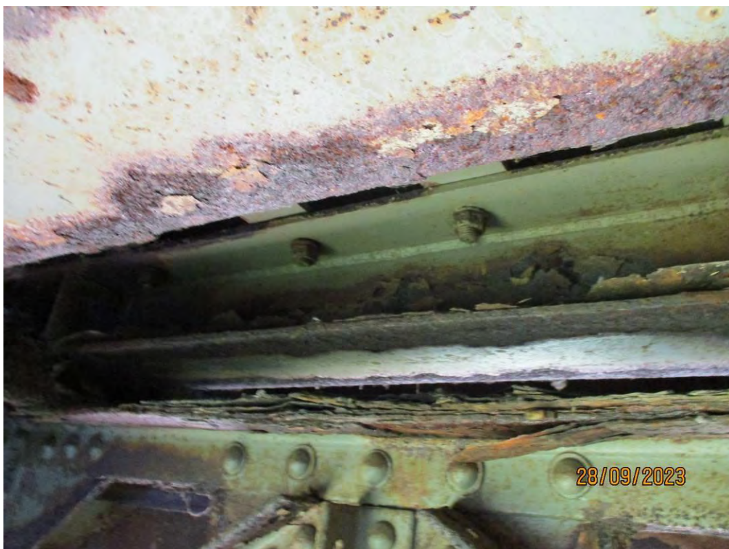
Дубинска корозија са умањењем основног пресека површине и лиснатом корозијом вертикала спрега за бочне ударе које се налазе код попречних укрућења подужних носача
