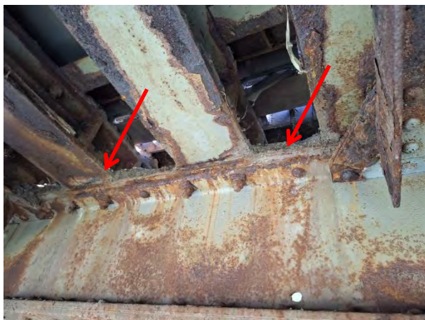
Дубинска корозија горње фланше и спојних средстава код оба горња носача, посебно у зонама ослањања секундарних попречних носача
