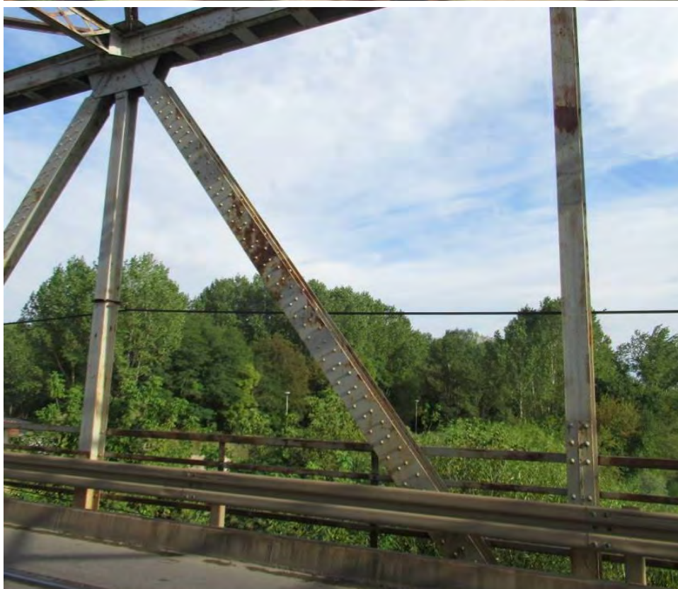
Дијагонале левог и десног решеткастог носача конструкције К4
