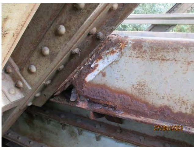
Оштећења челика левог ивичњака у зонама усецања ивичњака код ојачаних дијагонала
