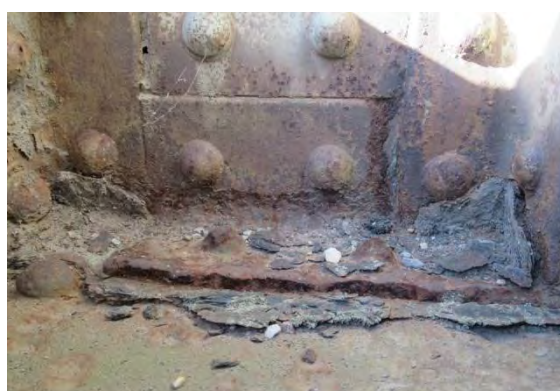
Попречни носачи у зони везе са главним носачима захваћени дубинском корозијом
