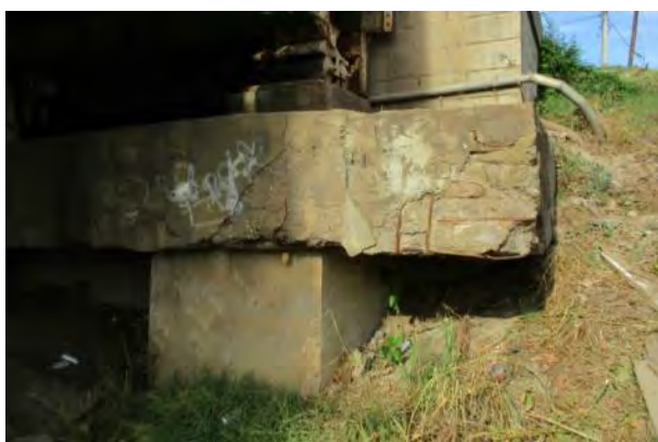
Оштећења заштитног слоја бетона дограђене лежишне греде
