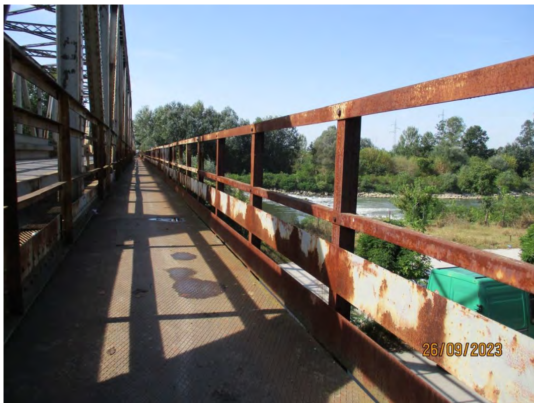
Спољна ограда пешачке стазе на конструкцији K4
