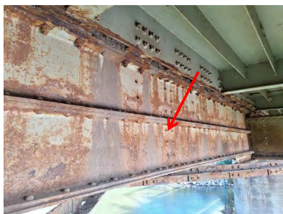
Десни (узводни) доњи подужни носач
