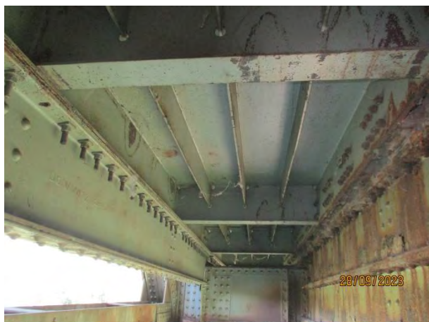
Тачкаста површинска корозија - леви монтажни комад орто-плоче
