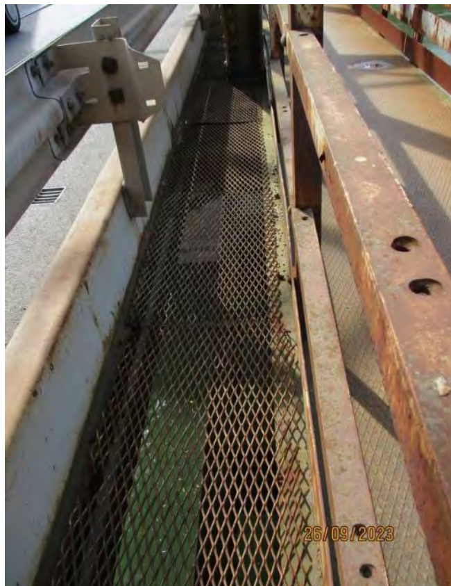
Локална деформација развученог лима на левој страни моста
