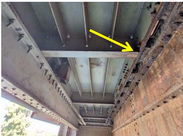
Корозија фланше попречног укрућења. Неадекватно изведен шав
