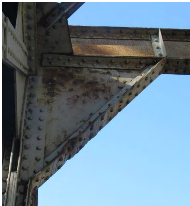
Механичко оштећење десног укрућења улазног порталног рама конструкције К2
