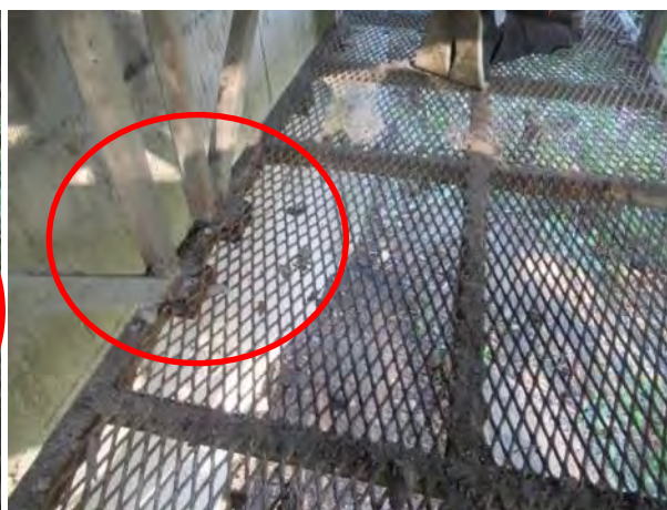
Пуцање развученог лима услед корозије, у средњем делу - небезбедно
