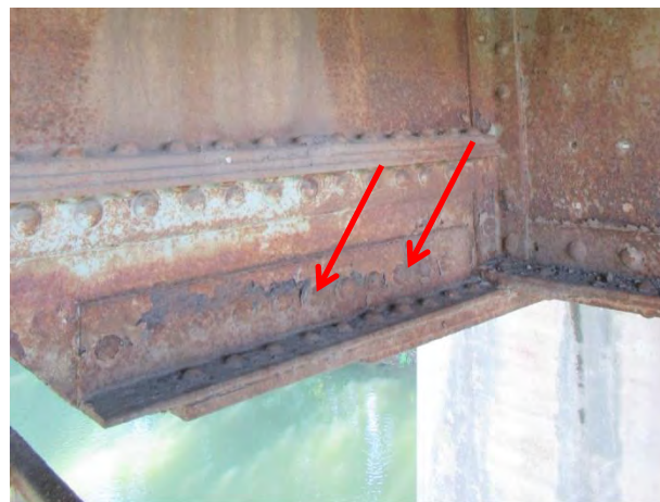
Зона континуитета левог (низводног) подужног носача код попречног носача ПН1 - дубинска корозија доњег угаоника, вертикалног лима и заковица на споју угаоника
