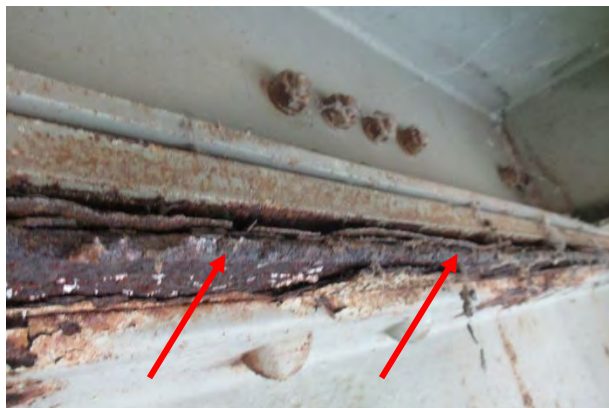
Дубинска корозија, листање и бубрење ламеле на горњој ножици носача
