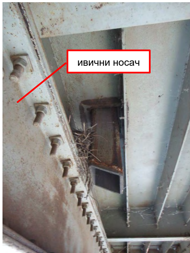
Сливничке вертикале захваћене површинском корозијом, недовољне дужине постављене на погрешан начин (краћа страна ближе ивичном носачу) - Конструкција К3
