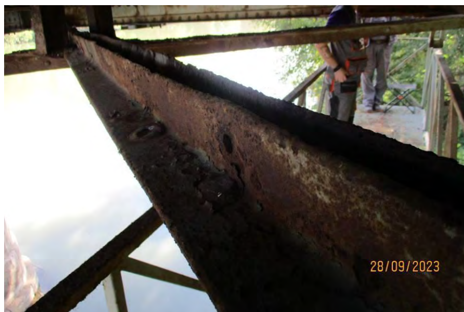
Недостатак спојних средстава на вези профила дијагонале доњег спрега за ветар у пољу 2'-1'
