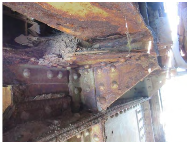
Дубинска корозија конзоле подужног носача
