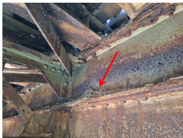
Дубинска корозија ребра у зони прикључка попречног укрућења подужних носача
