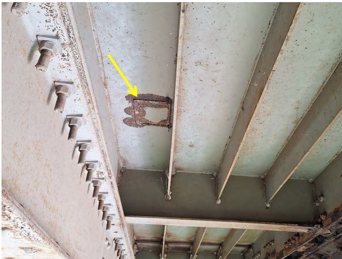
Затворен отвор за сливничку цев кроз који долази до процуривања и услед тога до појаве корозије
