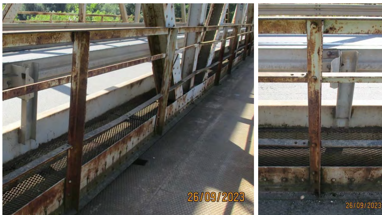
Стубови унутрашње ограде пешачке стазе на конструкцији K4
