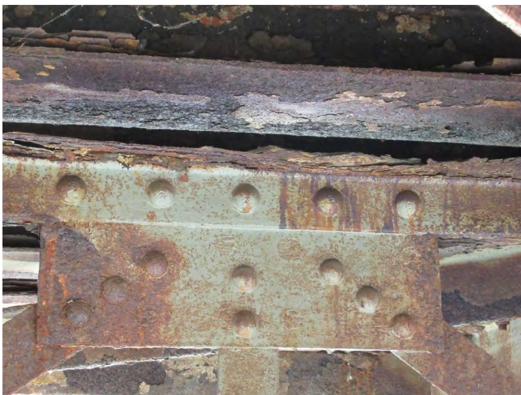
Изражена дубинска корозија и местимична лисната корозија вертикала спрега за бочне ударе које се налазе код попречних укрућења подужних носача
