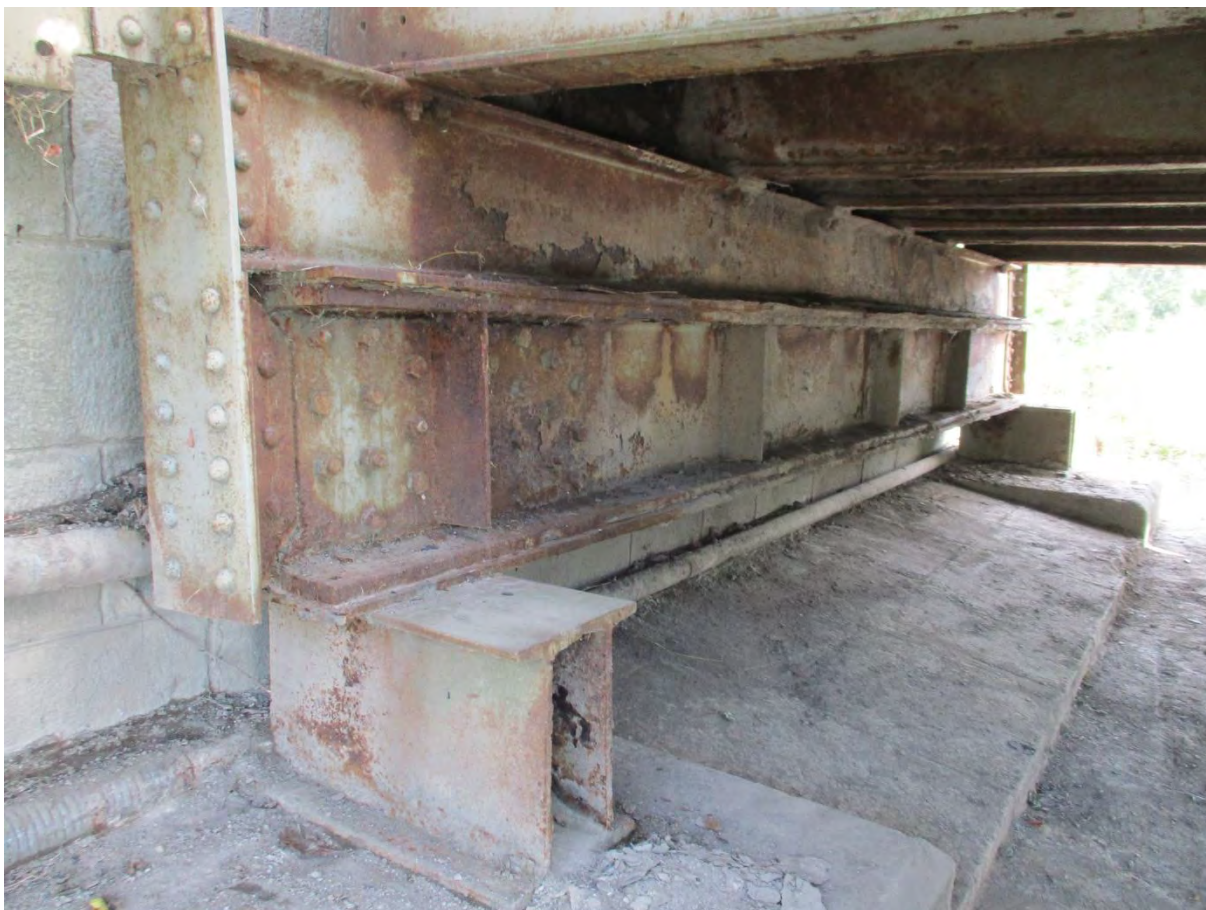
Ослоначка конструкција на стубу С5
