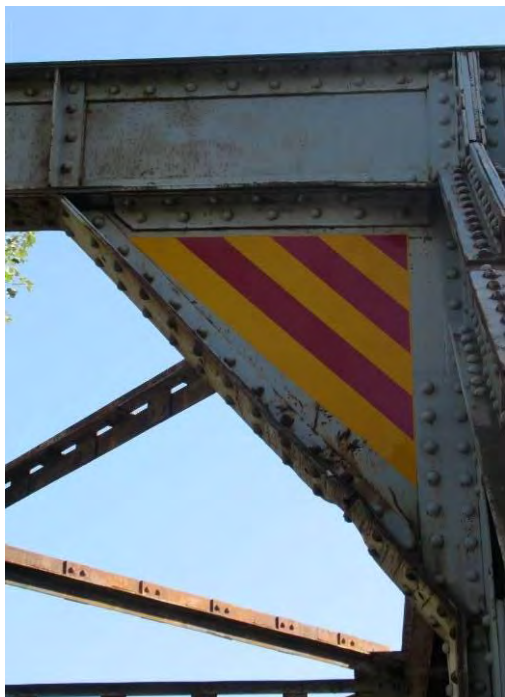
Механичко оштећење десног укрућења улазног порталног рама конструкције К2
