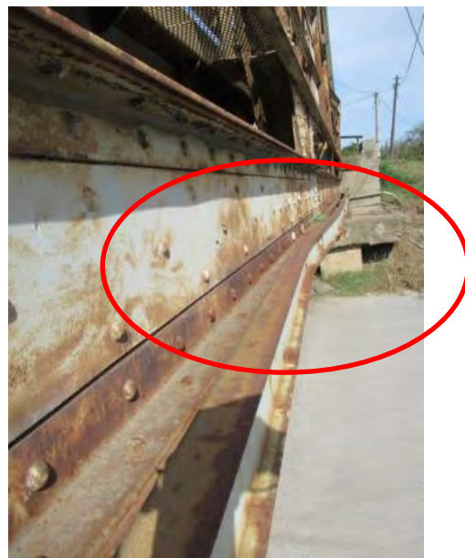
Пуцање везе кратке конзоле као и изражена деформација узводне (десне) шине у пољу 3' - 2' услед ударца возила
