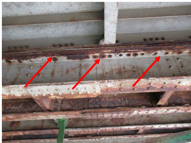
Недостају завртњеви на вези горње фланше носача 5 и орто-плоче у пољу 4'-3'
