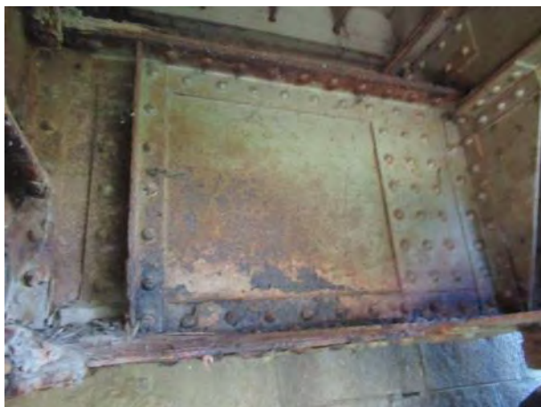
Попречни носач ПН0 ка ПН1, ивични делови - дубинска корозија доњих појасних угаоника и вертикалног лима у доњој зони
