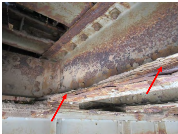
Дубинска корозија доње фланше и губитак попречног пресека носача 4 у пољу 3'-2'
