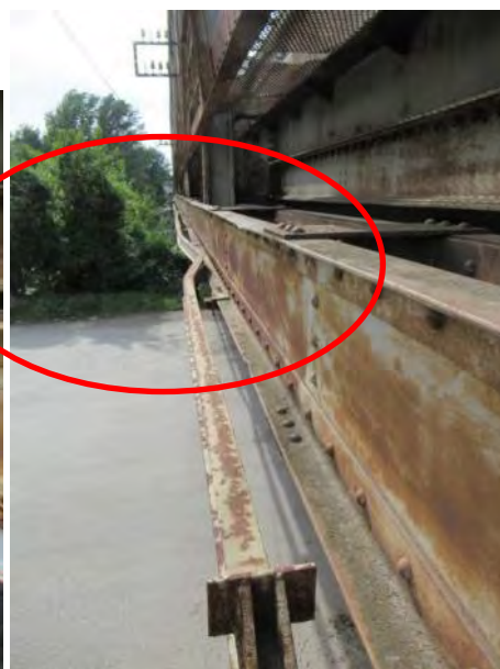
Велика деформација узводне (десне) шине услед ударца возила у пољу 1' - 0'
