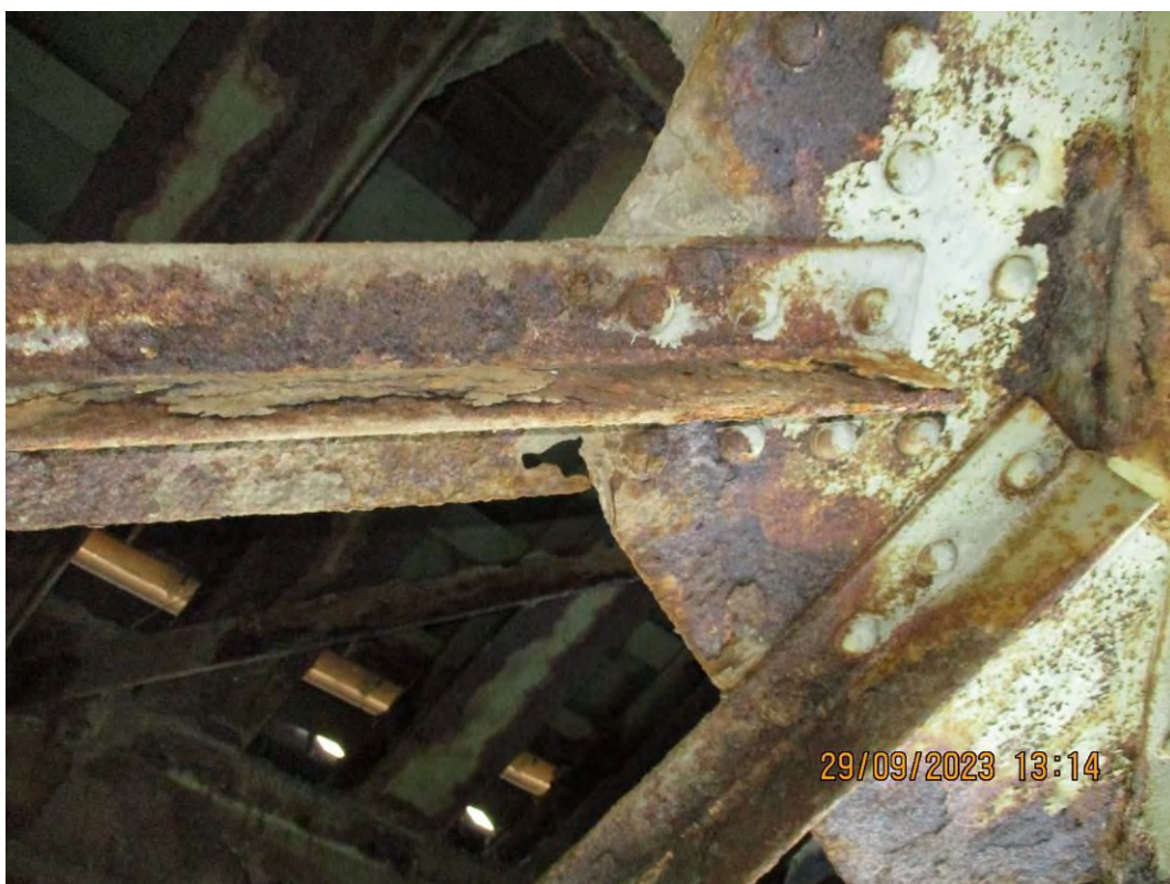
Доње стране чворних лимова спрега за кочење у првом пољу конструкције КЗ
