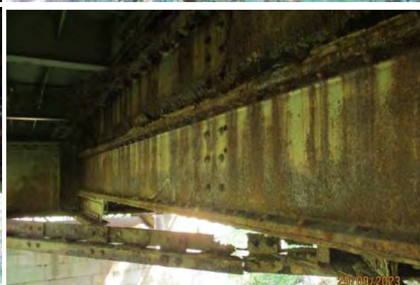
Тотална деградација дијагонала доњег спрега у свим пољима
