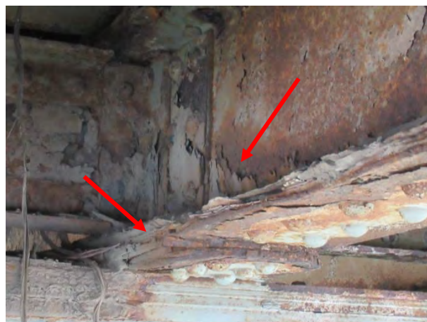
Дубинска корозија и деградација подужног носач- Зона ослањања носача 3 на попречни носач 2
