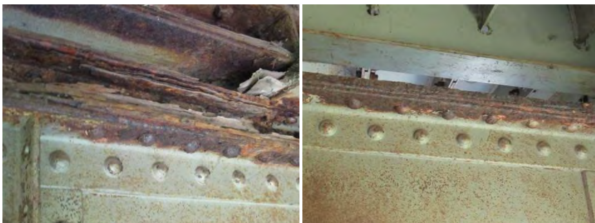
Ивични делови попречних носача у пољу - корозија горње ламеле са зачетком деградације материјала - ТИПСКО СТАЊЕ
