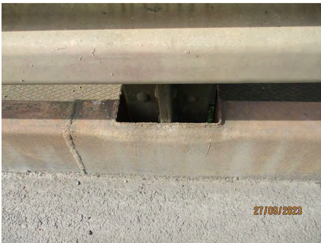
Усецање челичних ивичњака код ојачаних дијагонала и вертикала решеткастих носача
