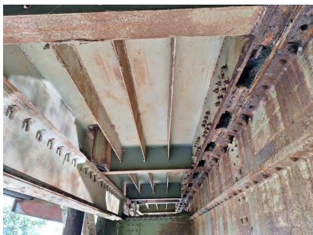
Тачкаста површинска корозија - леви монтажни комад орто-плоче
