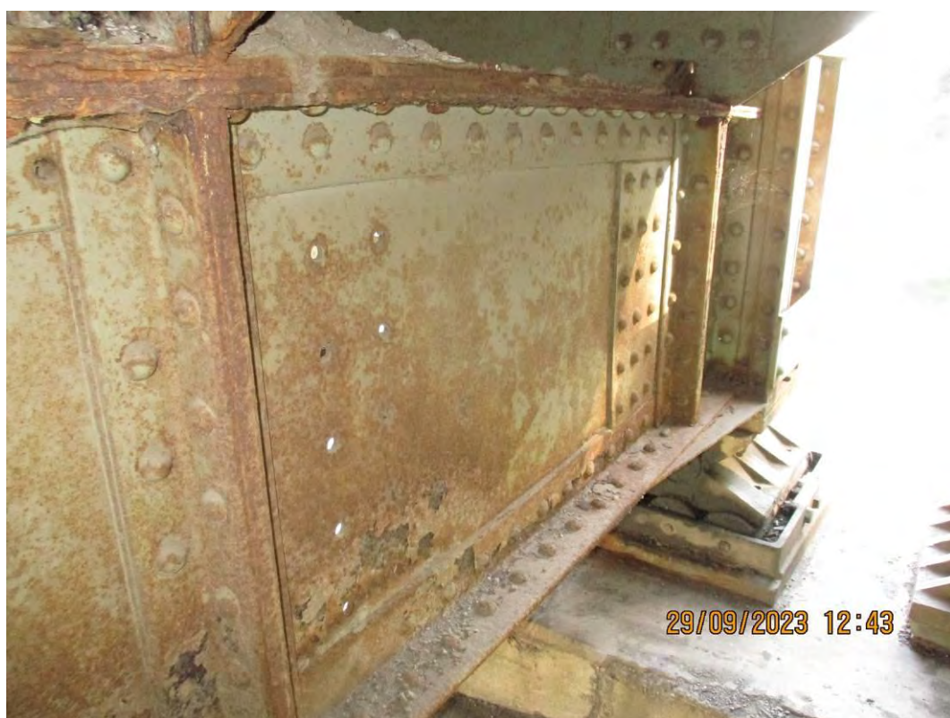
Попречни носач ПН0 - страна ка конструкцији К2 - вертикални лим у зони подужних носача захваћен дубинском корозијом
