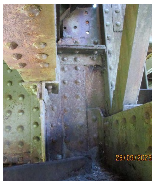
Попречни носачи у зони везе са главним носачима захваћени дубинском корозијом
