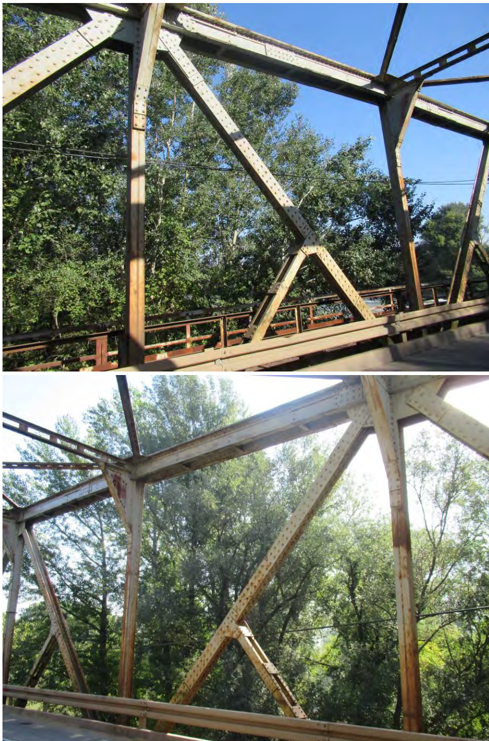
Вертикале левог и десног решеткастог носача конструкције K2
