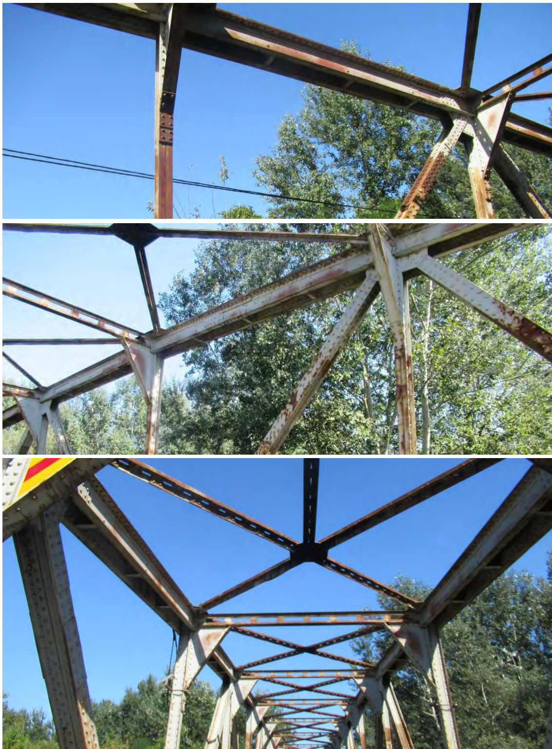
Горњи појас конструкције K1
