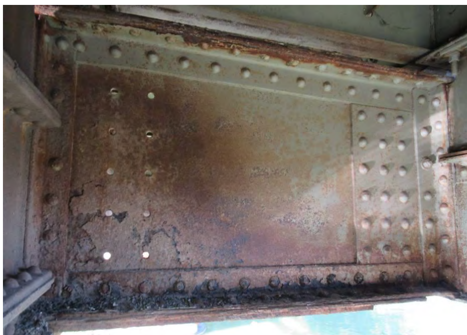
Вертикални лим попречних носача у зони подужних носача захваћен дубинском корозијом
