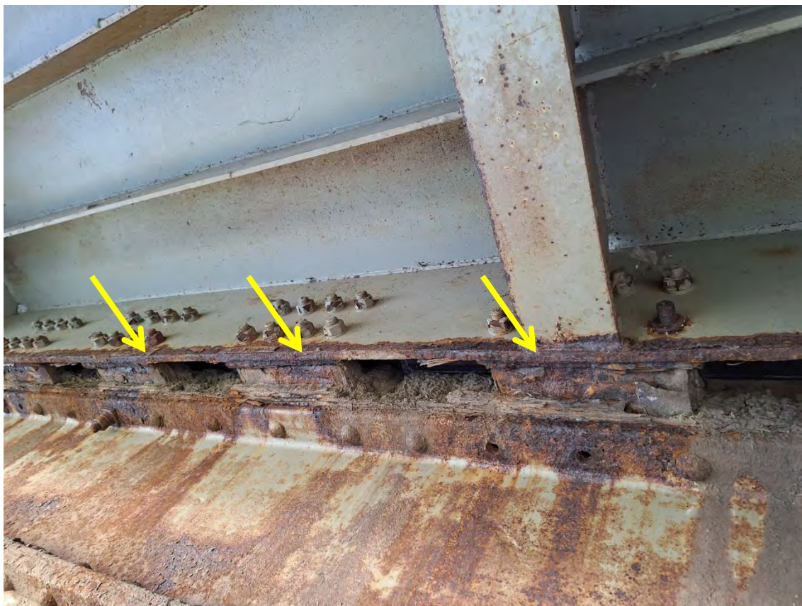
Корозија ивичног ребра орто-плоче уз шину, као и завртњева на вези са секундарним попречним носачима
