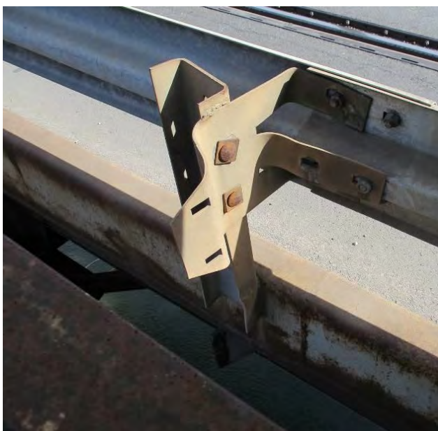
Два искривљена стуба одбојне ограде на левој страни моста
