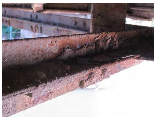
Дубинска корозија са умањењем основног пресека дијагонала доњег спрега за ветар конструкције КЗ
