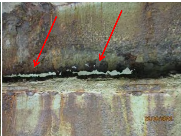
Деградација ребра левог подужног носача у пољу 3-4, дужине око 100ст - прекид везе за доњом фланшом
