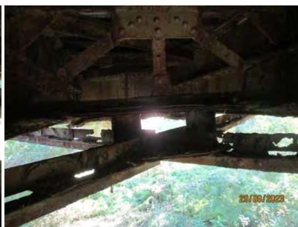
Тотална деградација дијагонала доњег спрега у свим пољима
