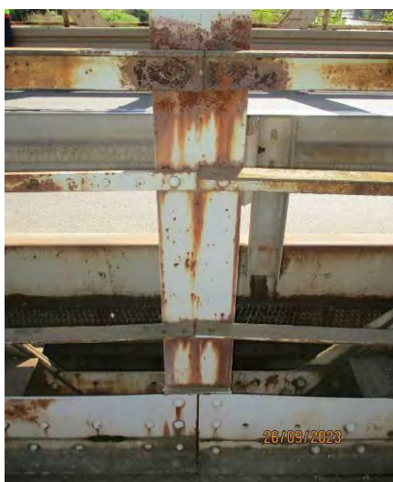
Недостатак спојног средства на вези рукохвата унутрашње ограде за вертикалу конструкције K4
