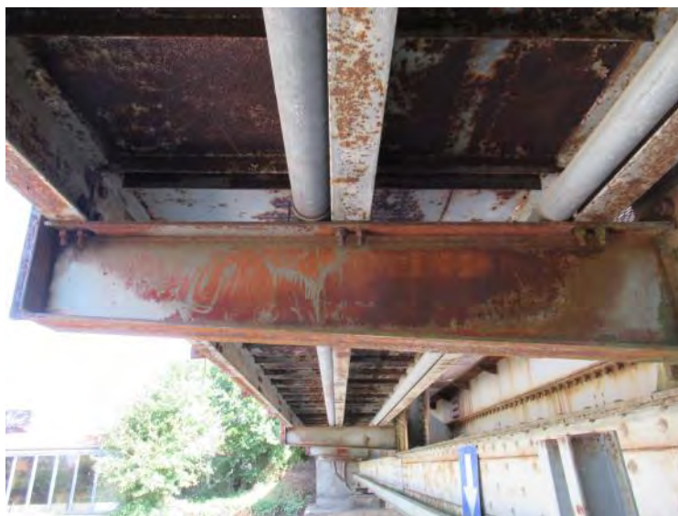
Конзола пешачке стазе на конструкцији K4
