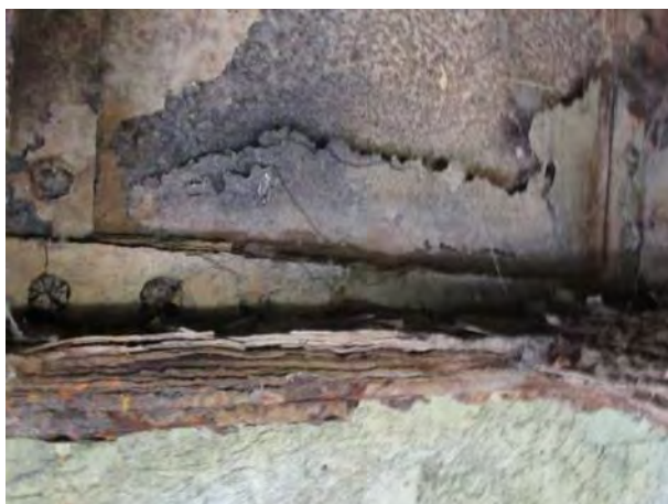
Попречни носач ПН0 ка ПН1, средњи део - тотална деградација доњих појасних угаоника и вертикалног лима у доњој зони
