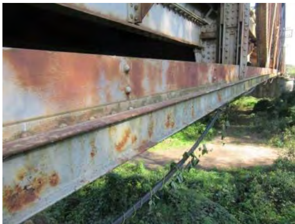
Шине и кратке конзоле генерално у добром стању, површинска корозија
