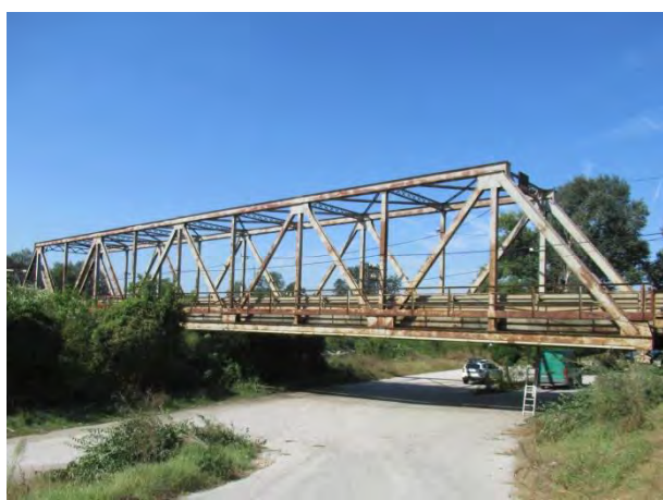
Површинска корозија - главнирешеткасти носач конструкције K4
