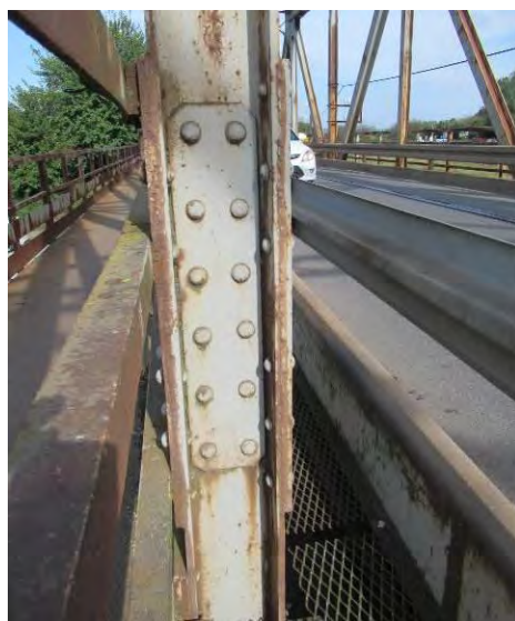
Монтажни наставак вертикале V левог решеткастог носача конструкције K4
