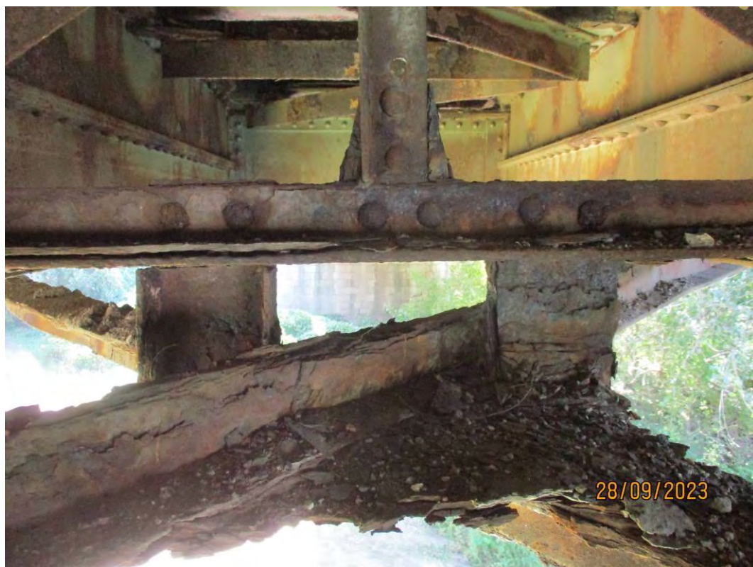
Два "U" профила на чворном лиму на месту укрштања дијагонала доњег спрега
