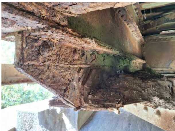
Зона континуитета десног (узводног) подужног носача код попречног носача ПН0 - дубинска корозија доњег угаоника, вертикалног лима и заковица на споју угаоника
