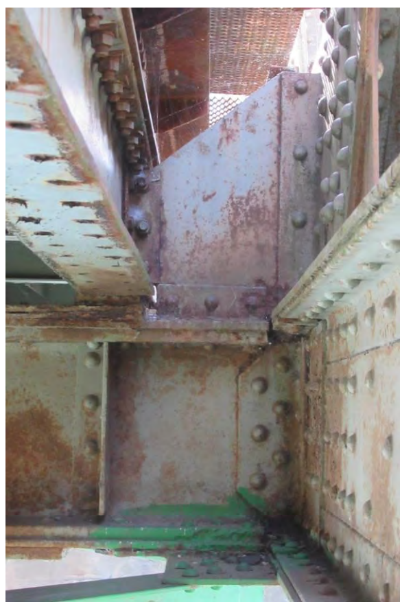
Површинска корозија попречних носача у зонама везе са главним носачима
