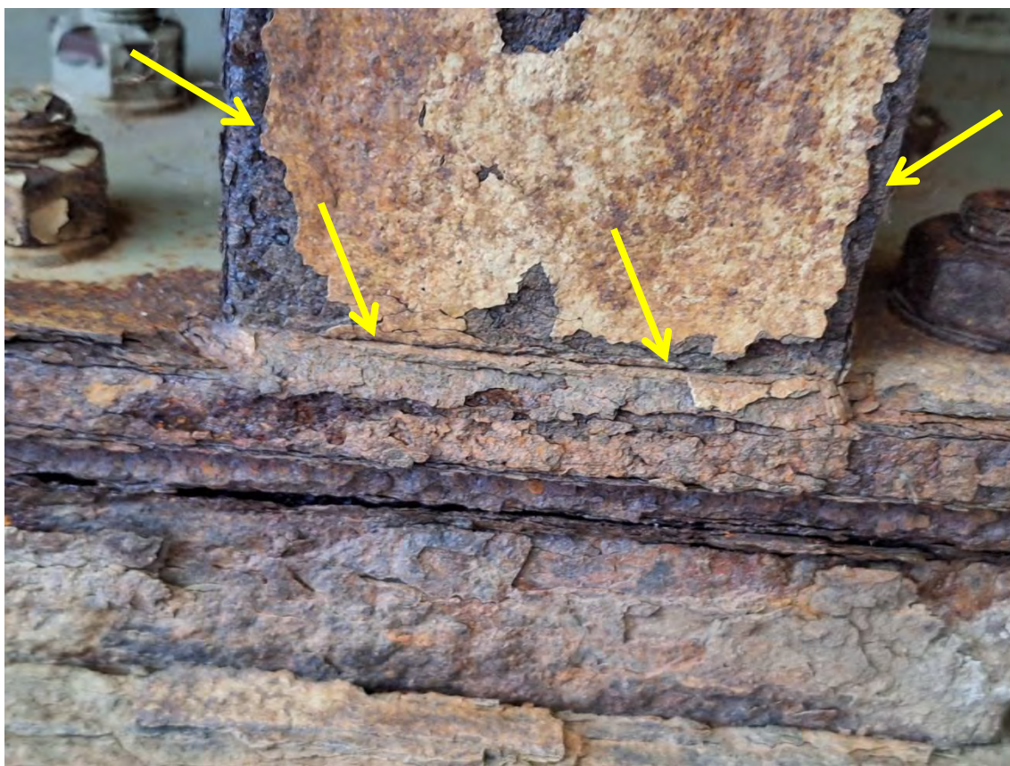
Корозија фланше попречног укрућења. Неадекватно изведен шав
