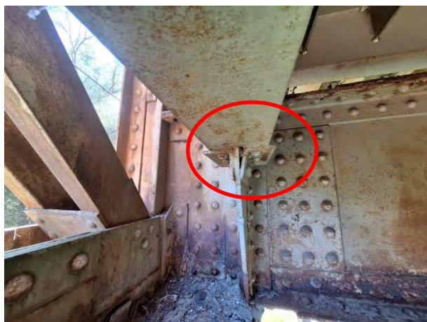
Деформисан угаоник ослонца подужног носача
