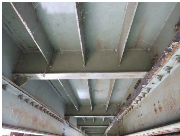
Тачкаста површинска корозија - леви монтажни комад орто-плоче
