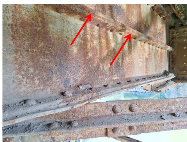
Дубинска корозија у зони споја ребра и доње фланше у свим осталим пољима конструкције К3
