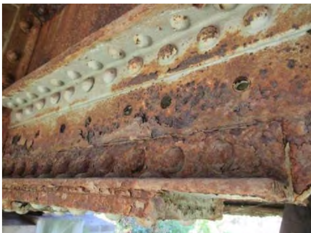
Зона континуитета десног (узводног) подужног носача код попречног носача ПН1 - дубинска корозија доњег угаоника, вертикалног лима и заковица на споју угаоника
