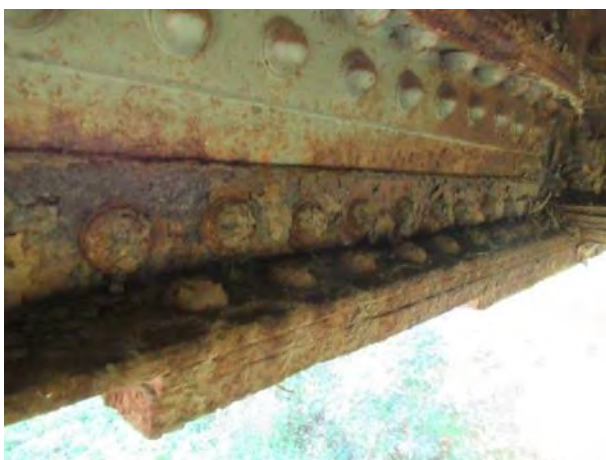
Зона континуитета десног (узводног) подужног носача код попречног носача ПН2' - појачана корозија доњег угаоника, вертикалног лима и заковица на споју угаоника
