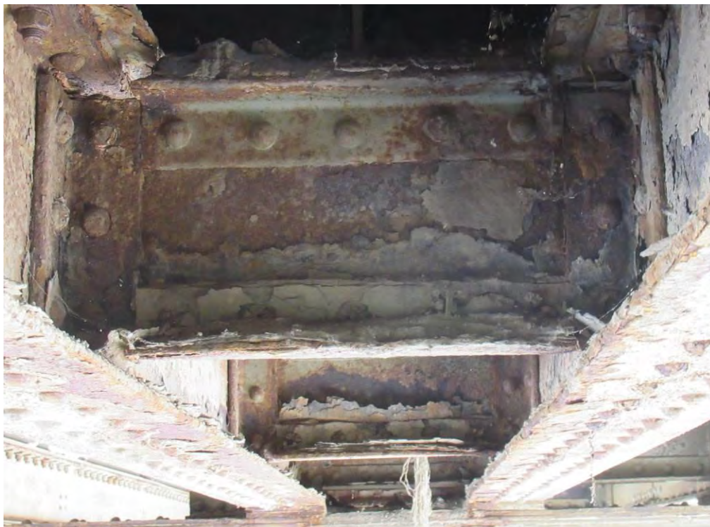
Попречна укрућења подужних носача конструкције К4
