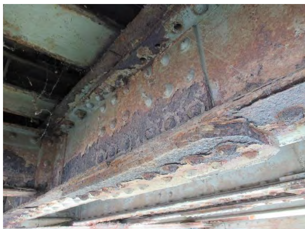
Дубинска корозија подвезица монтажног наставка носача 3 у пољу 1-2
