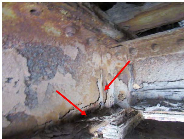
Дубинска корозија и деградација подужног носача- Зона ослањања носача 4 на попречни носач 0'
