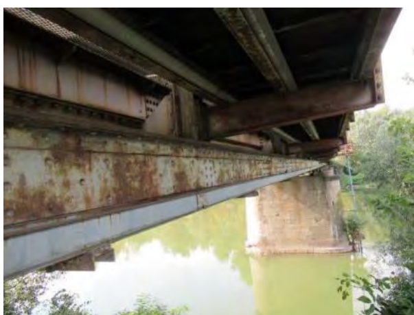
Низводна и узводна шина (у осталим пољима) са местимичном површинском корозијом, добре геометрије
