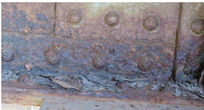
Попречни носач ПНО' - стање доње зоне и заковица
