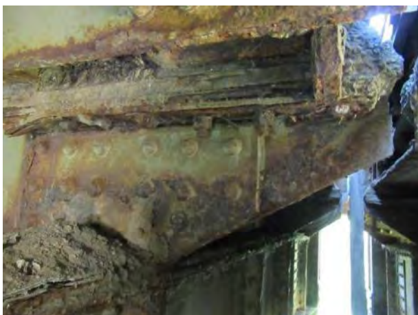
Дубинска корозија конзоле подужног носача код попречног носача ПНО
