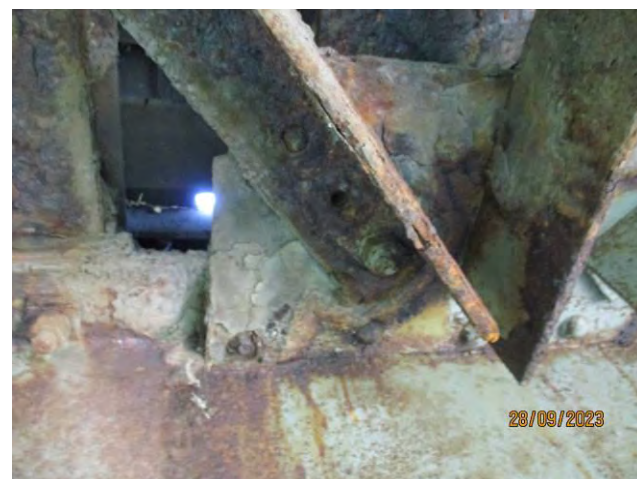
На више места веза штапова спрега и чворних лимова је остварена завртњевима. На неколико места уочен је недостатак завртњева.
