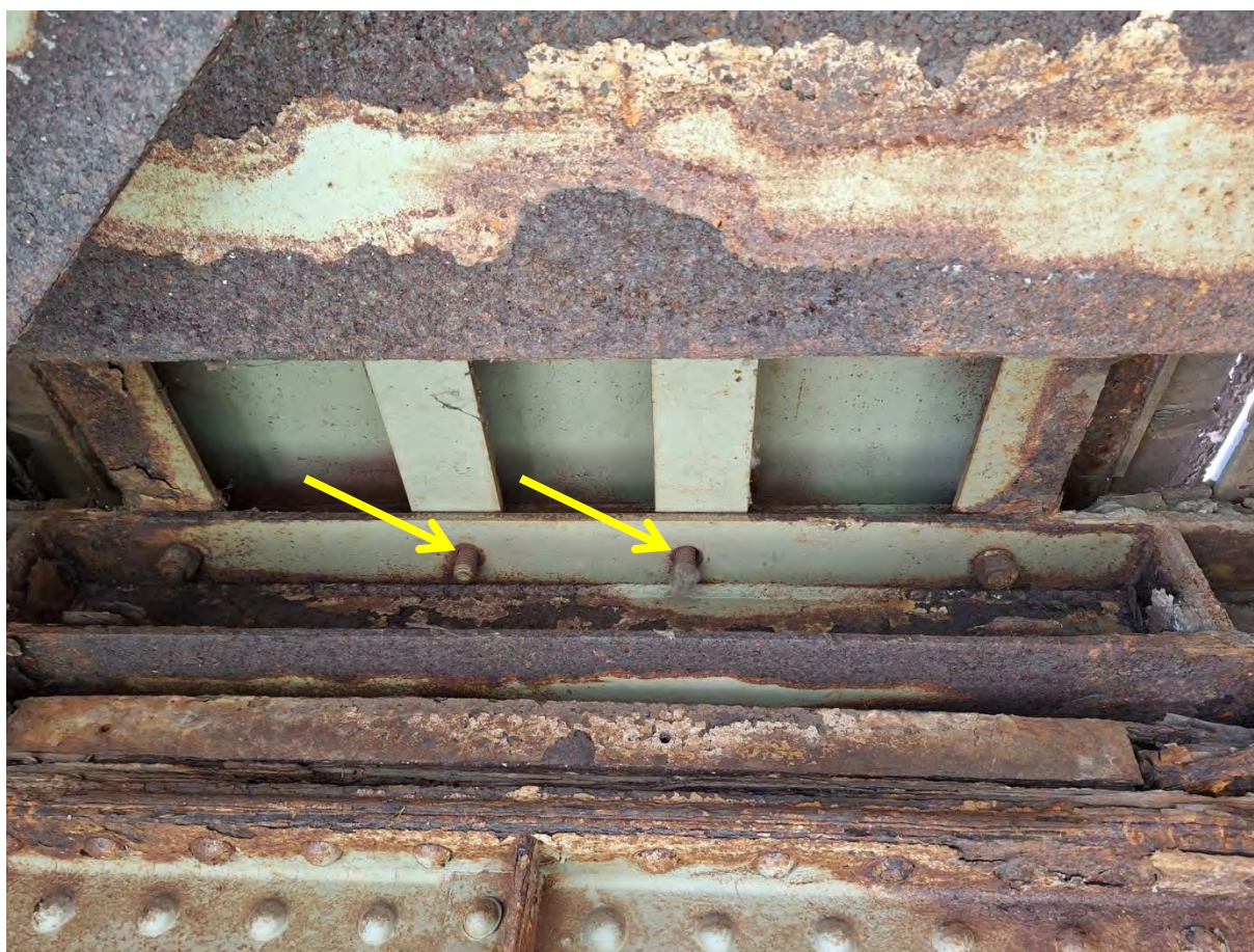
Недостаје матица завртња на вези са секундарним попречним носачем
