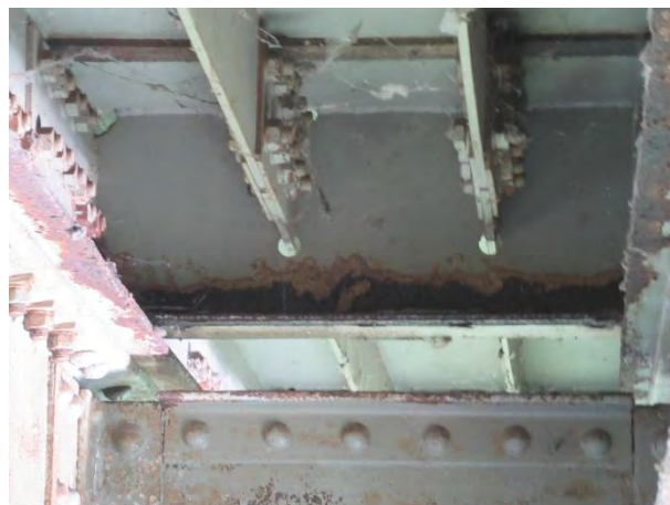
Тачкаста површинска корозија - средњи монтажни комад орто-плоче
