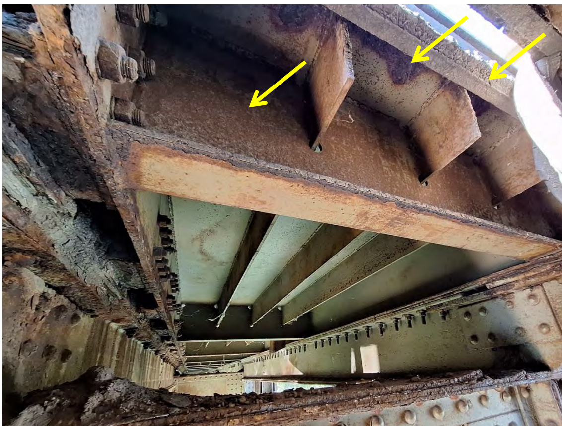
Корозија орто-плоче у зони дилатирања конструкције
