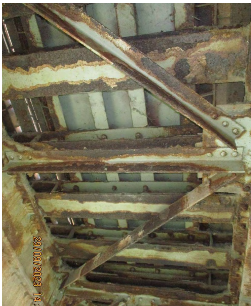
Секундарни попречни носачи коловоза конструкције КЗ
