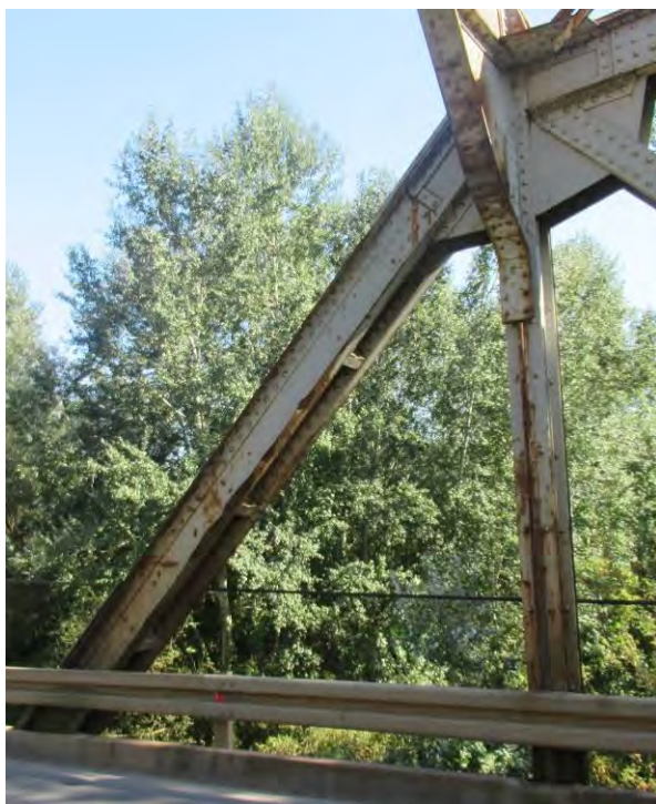
Механичка оштећења дијагонале I'-0' десног решеткастог носача конструкције K1
