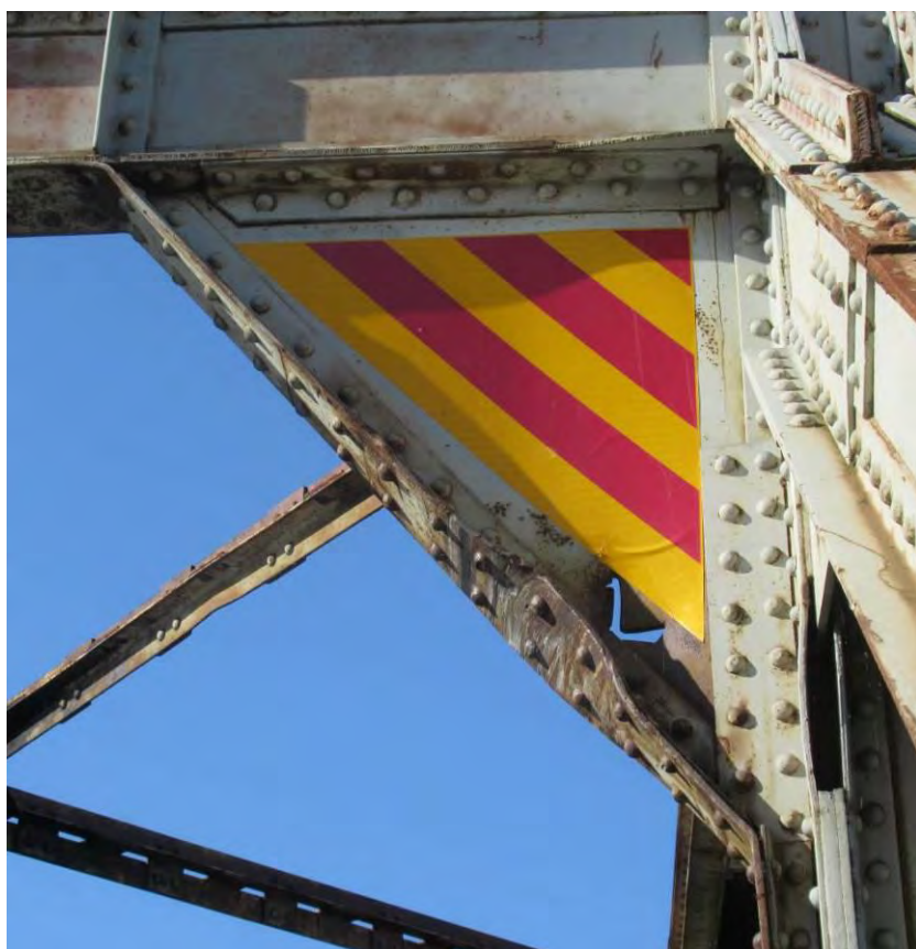
Механичко оштећење левог укрућења излазног порталног рама конструкције К2
