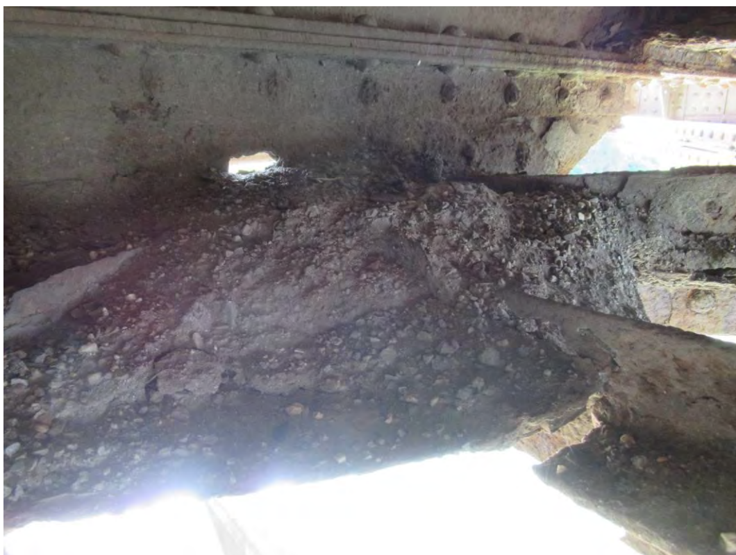
Депоновани земљани материјал на чворном лиму спрега за кочење у крајњем пољу конструкције К3
