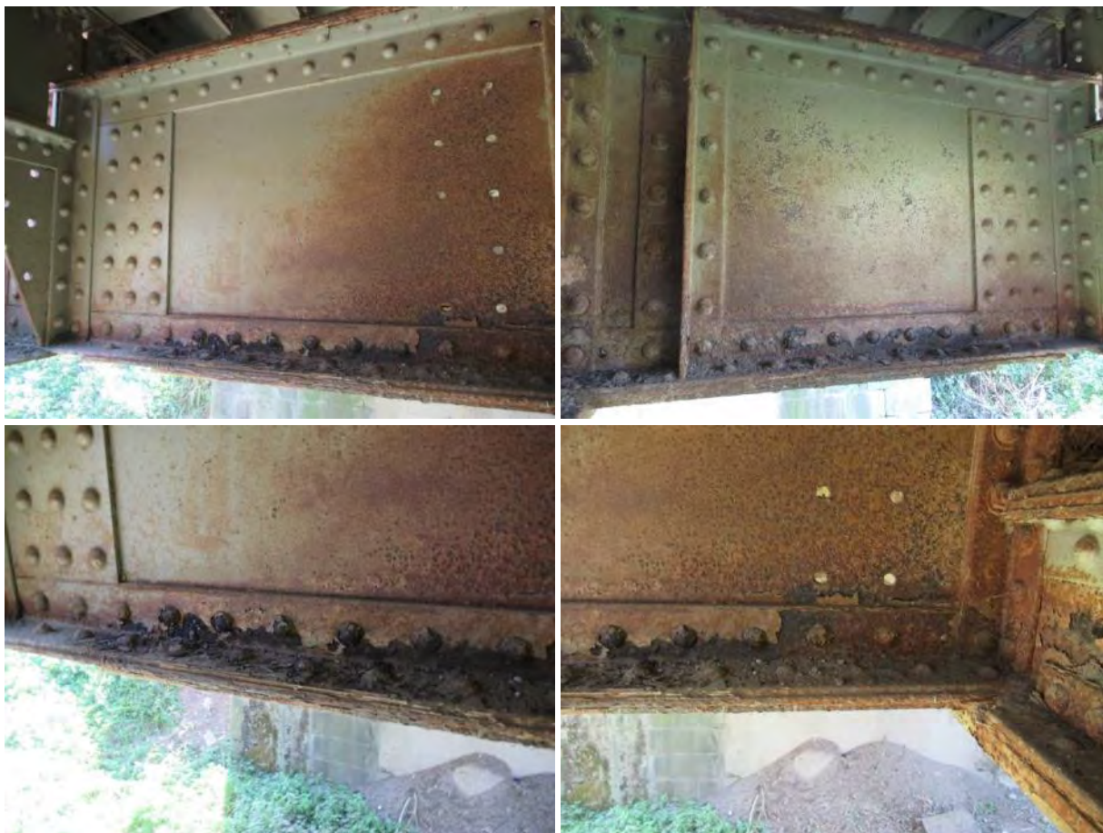
Ивични делови попречних носача у пољу - појачана корозија са зачетком деградације материјала доњег појаса (угаоника, ребра и заковица) - ТИПСКО СТАЊЕ
