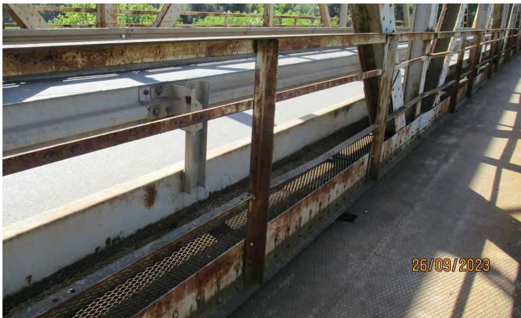
Сегмент унутрашње ограде на конструкцији K4 где је уместо L профила коленик изведен од лима
