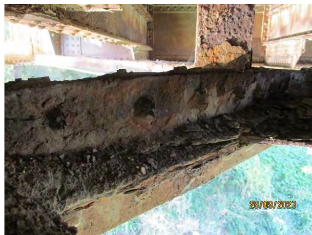
Оштећене заковице доњег спрега за ветар услед дубинске корозије
