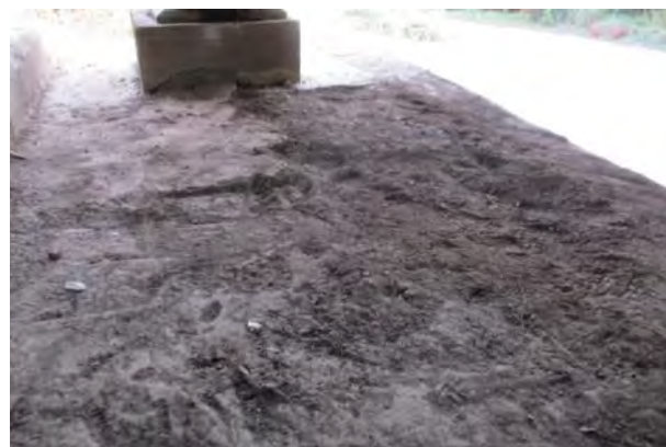
Лежишна греда - деградирана горња површина бетона
