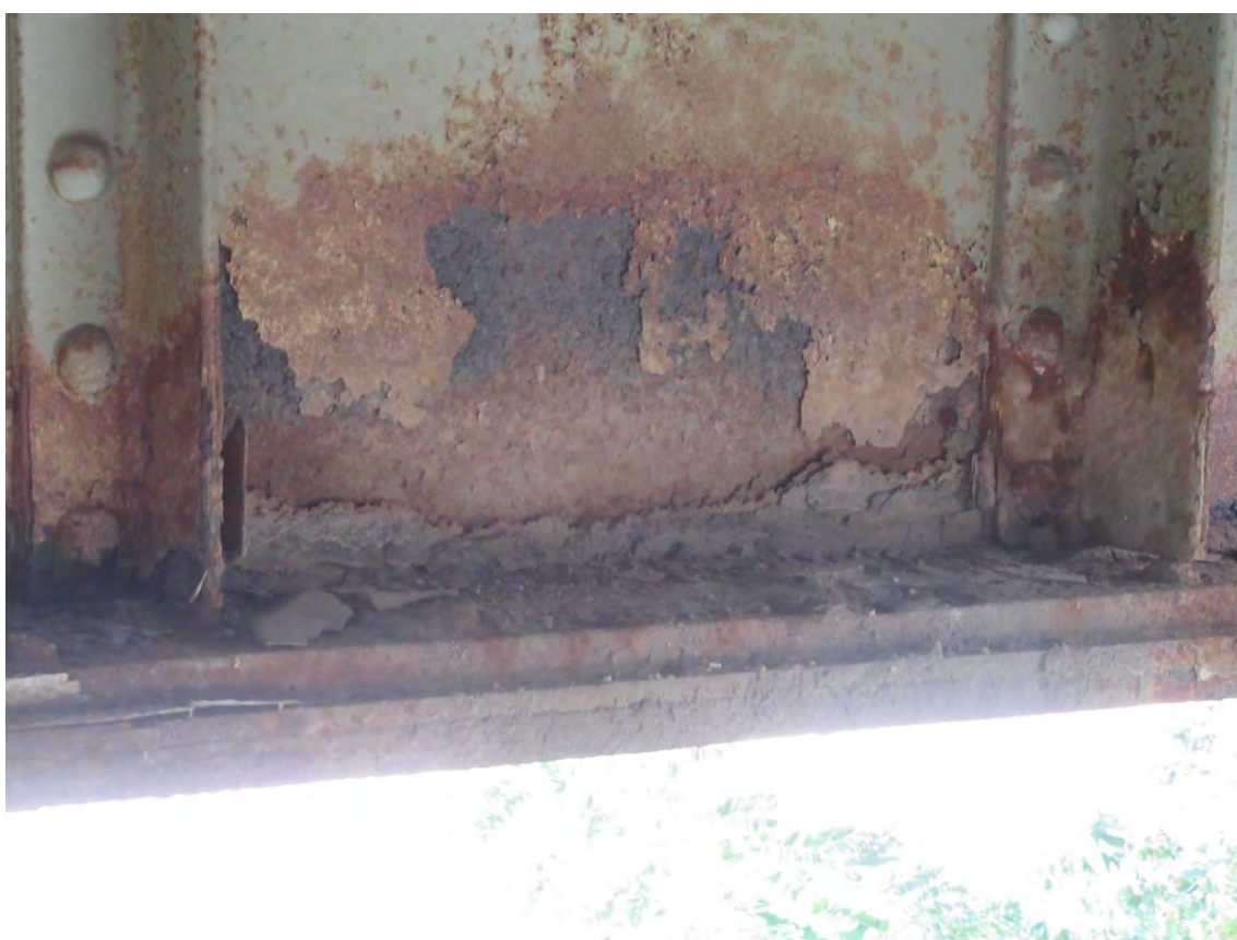
Локална дубинска корозија ребра попречног носача ПН5
