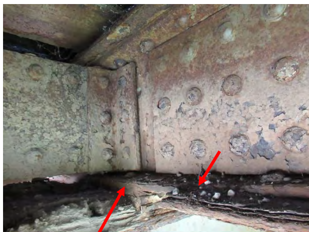
Дубинска корозија и деградација подужног носач- Зона ослањања носача 2 на попречни носач 0
