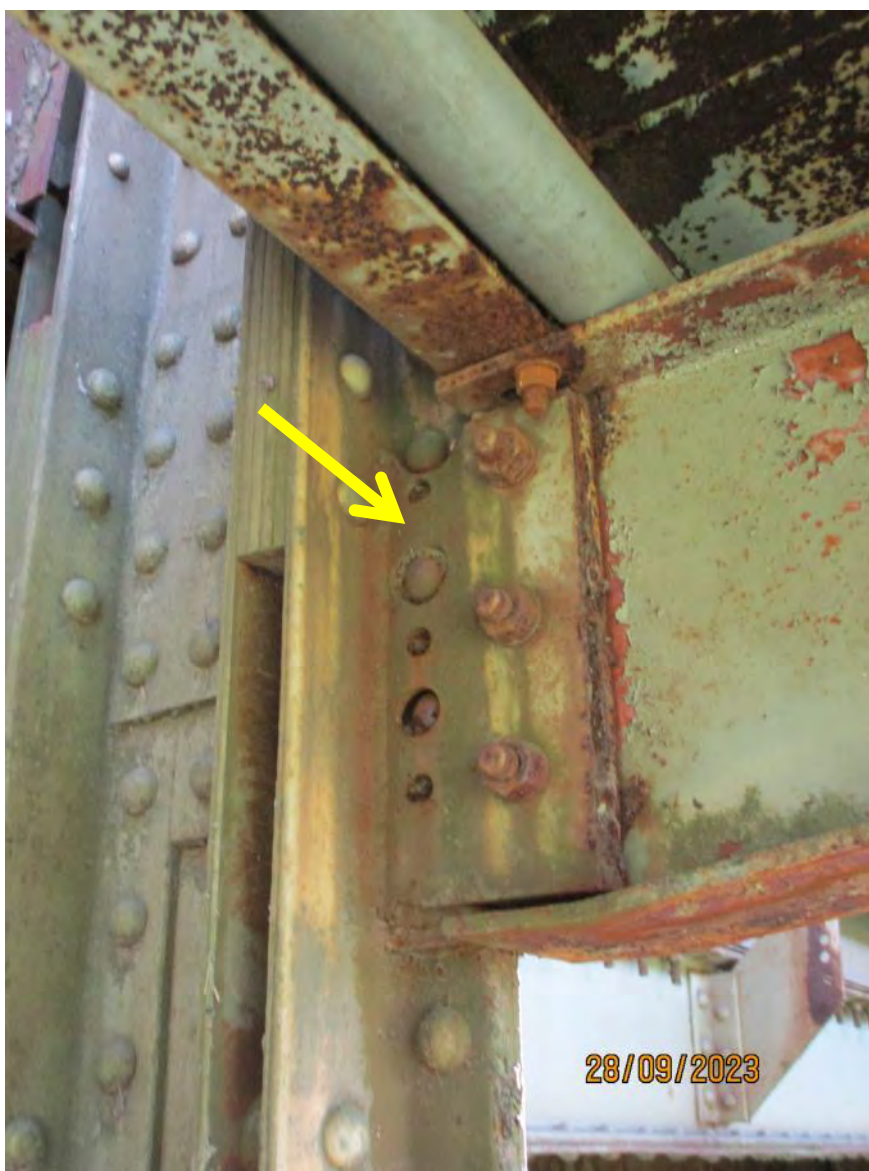
Неадекватна веза конзоле за главни носач на конструкцији K1
