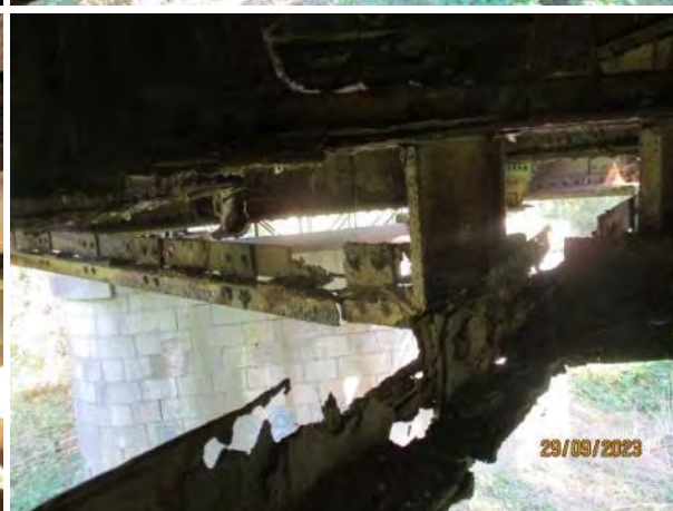
Тотална деградација чворних лимова и профила за везу доњег спрега у свим пољима
