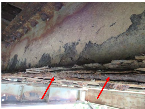
Дубинска корозија доње фланше и губитак попречног пресека носача 3 у пољу 4-5
