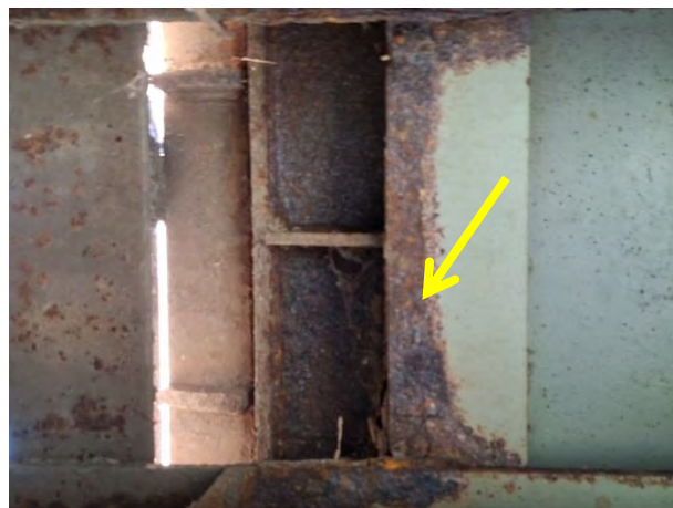
Корозија ивичног ребра средњег монтажног комада орто-плоче уз шину
