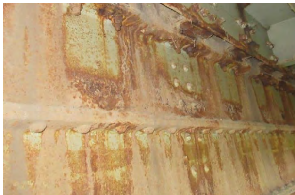
Лоше стање горње ножице и закивака на споју два носача
