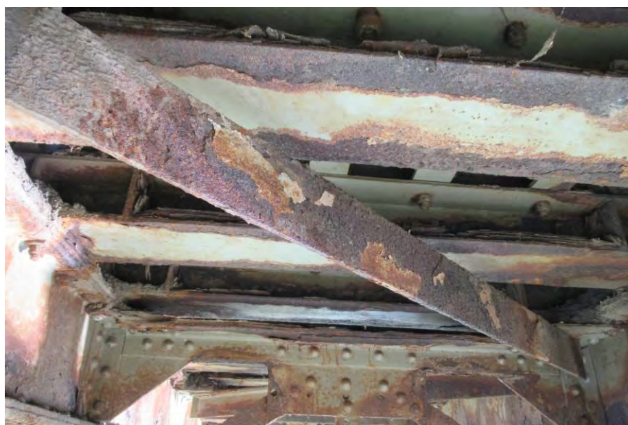
Дубинска корозија свих штапова спрега за бочне ударе
