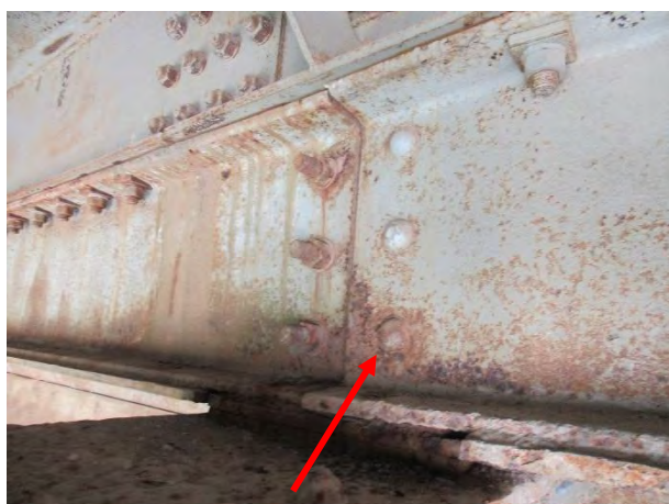
Локално појачана корозија са унутрашње стране низводног носача
