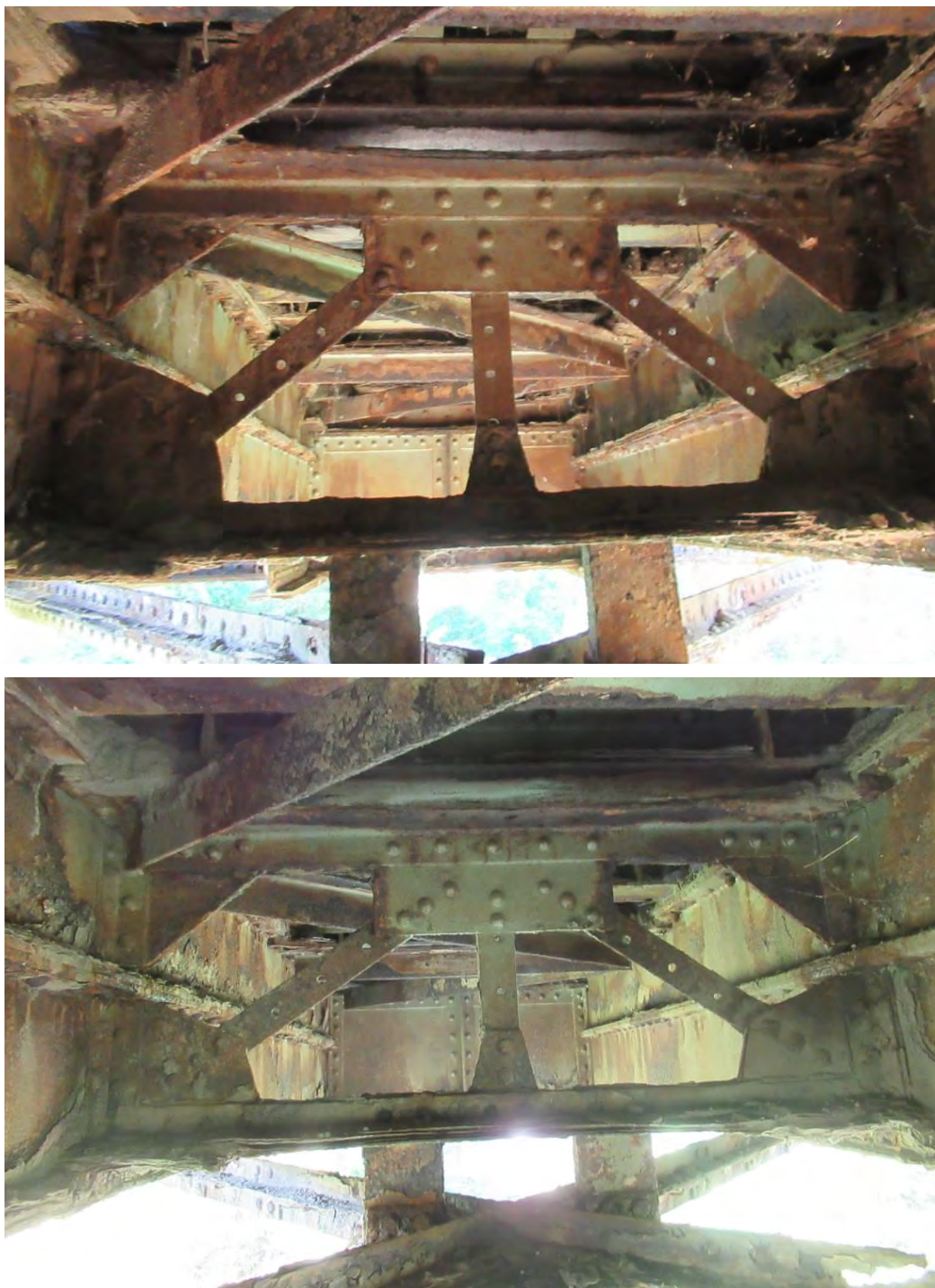
Попречна укрућења подужних носача
