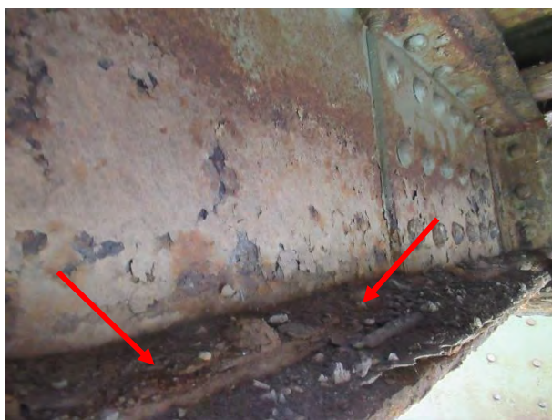
Дубинска корозија доње фланше и губитак попречног пресека носача 4 у пољу 0-1
