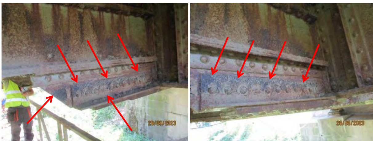
Зона континуитета левог (низводног) подужног носача код попречног носача ПН1 - дубинска корозија доњег угаоника, вертикалног лима и заковица на споју угаоника
