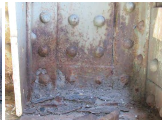
Попречни носачи у зони везе са главним носачима захваћени дубинском корозијом
