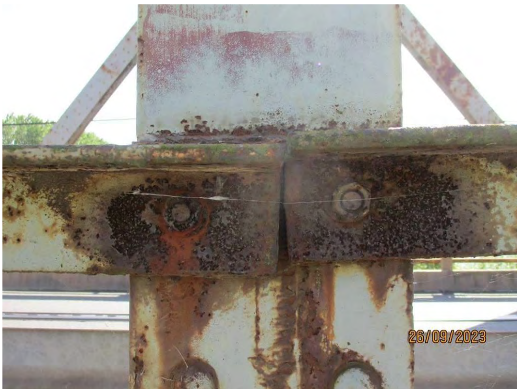
Кратак навој за вртњева на вези рукохвата унутрашње ограде за вертикалу
