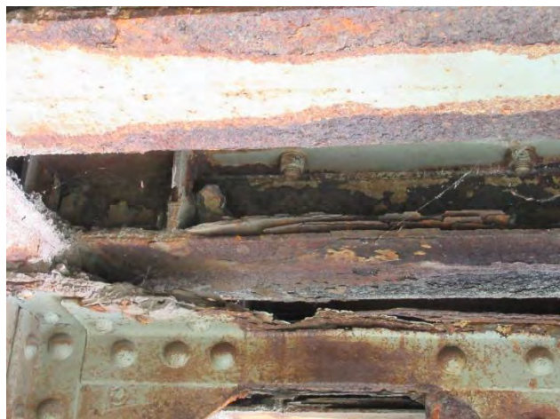
Дубинска корозија са умањењем основног пресека површине и лисната корозија доњег лима секундарних попречних носача коловоза конструкције КЗ
