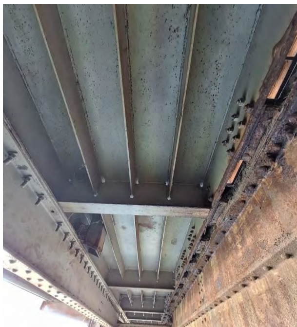
Тачкаста површинска корозија - леви монтажни комад орто-плоче
