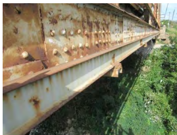
Низводна и узводна шина (у осталим пољима) са местимичном површинском корозијом, добре геометрије
