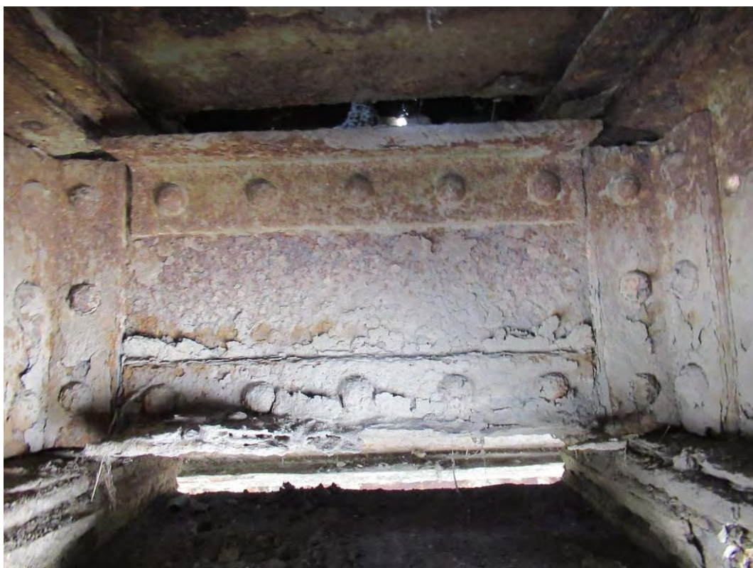
Попречна укрућења подужних носача код попречног носача ПНО'
