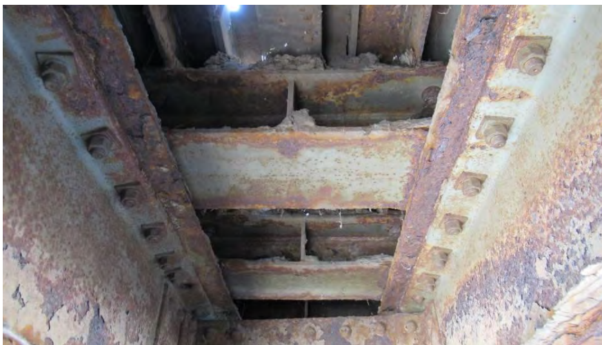
Секундарни попречни носачи коловоза на конструкцији К4
