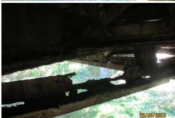
Тотална деградација дијагонала доњег спрега у свим пољима
