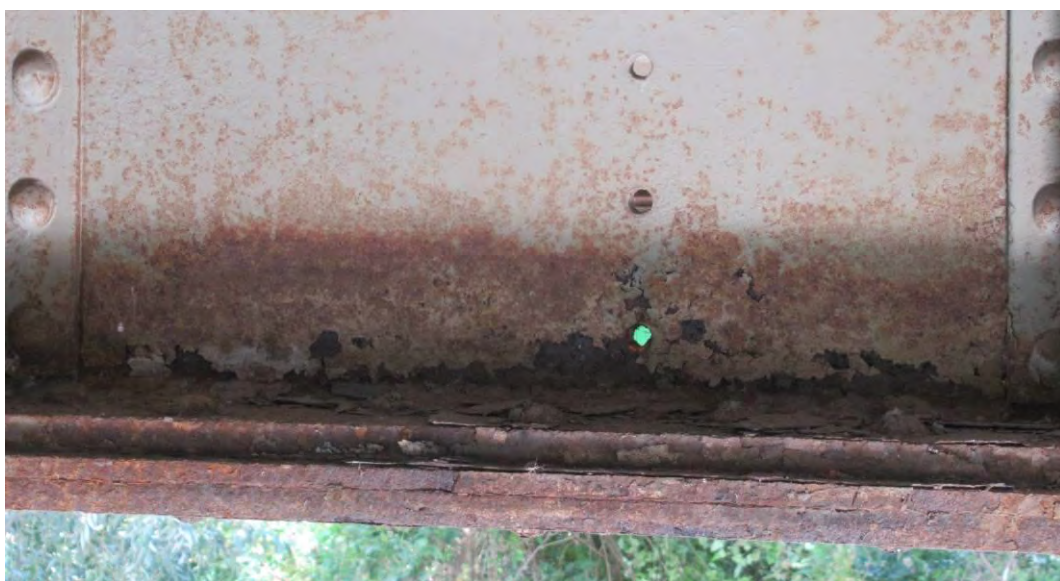
Површинска корозија доње ножице и заковица попречних носача
