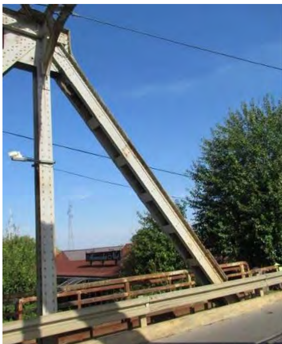
Дијагонале I'-0' левог и десног решеткастог носача конструкције K4
