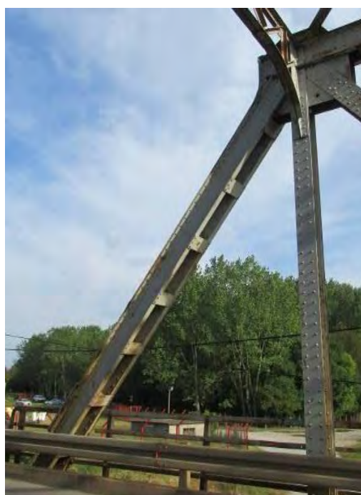
Дијагонале I'-0' левог и десног решеткастог носача конструкције K4
