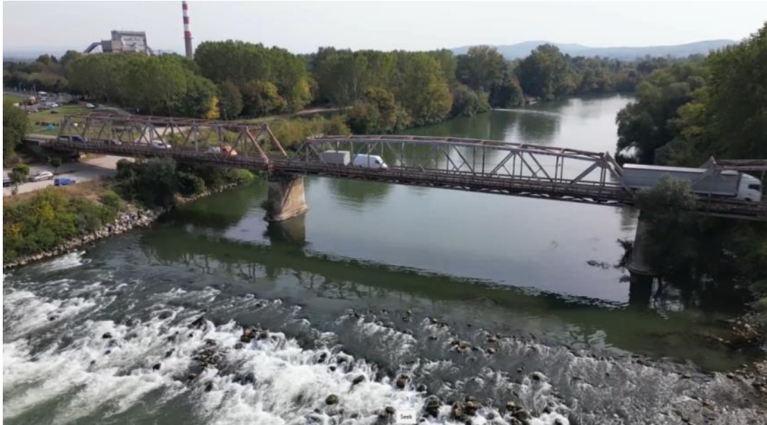
изглед конструкција са низводне стране
