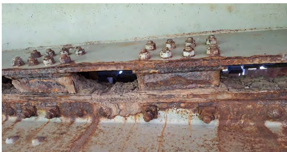
Везе секундарних попречних носача коловоза и подужних носача
