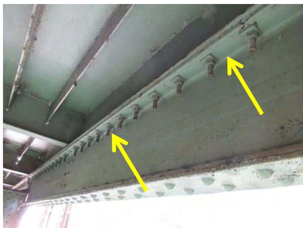
Веза подужног носача и орто-плоче
