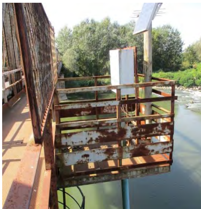
Проширење пешачке стазе код средњег стуба С4 - постављена опрема за мониторинг водостаја
