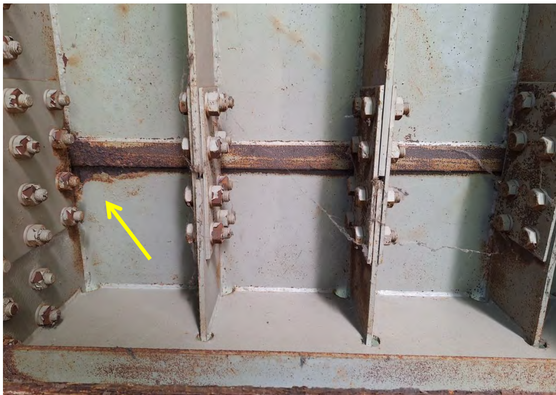
Трагови процуривања на месту монтажнoг наставка - поље 2-3
