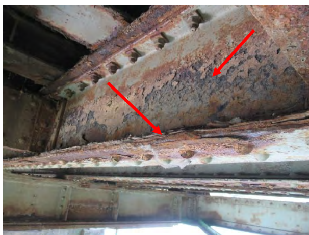
Дубинска корозија доње фланше и губитак попречног пресека носача 4 у пољу 1-2
