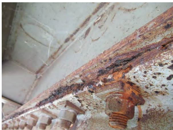
Локално појачана корозија са унутрашње стране низводног носача
