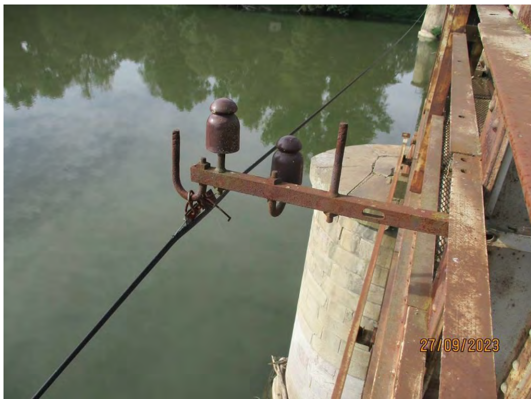
Старији носачи инсталација на десној страни моста
