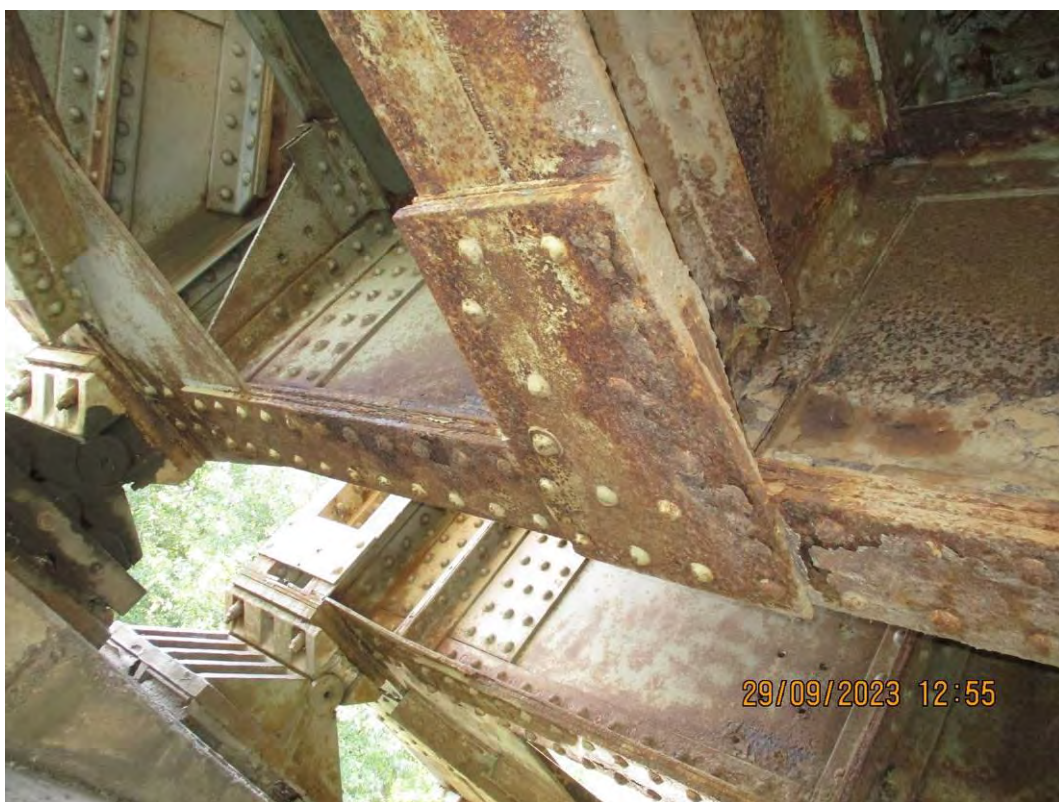
Попречни носач ПНО - погледи одоздо
