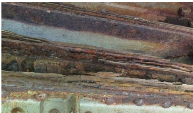
Дубинска корозија са умањењем основног пресека површине и лиснатом корозијом вертикале спрега за бочне ударе које се налазе изнад попречних носача
