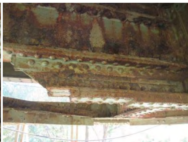
Зона континуитета десног (узводног) подужног носача код попречног носача ПН2 - дубинска корозија доњег угаоника, вертикалног лима и заковица на споју угаоника
