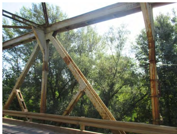
Површинска корозија - главнирешеткасти носач конструкције K2
