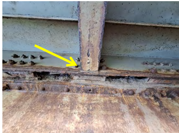
Корозија фланше попречног укрућења. Неадекватно изведен шав
