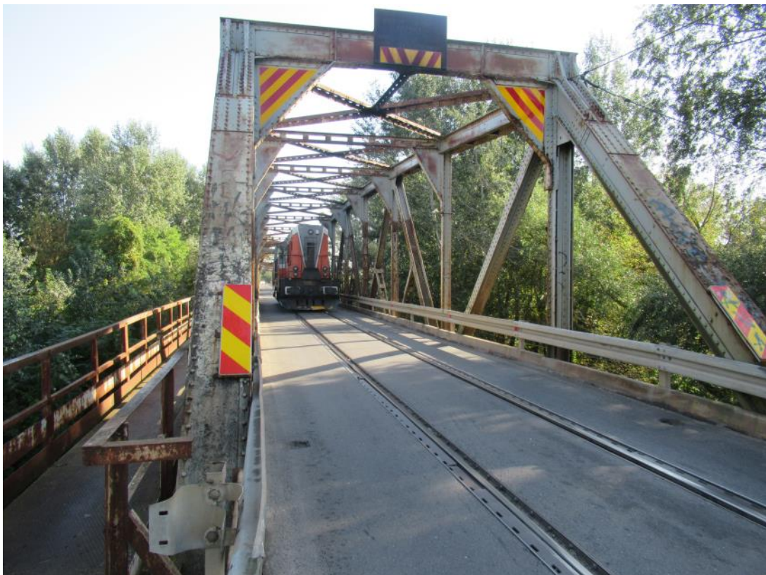
изглед конструкције - поглед на коловоз/колосек
