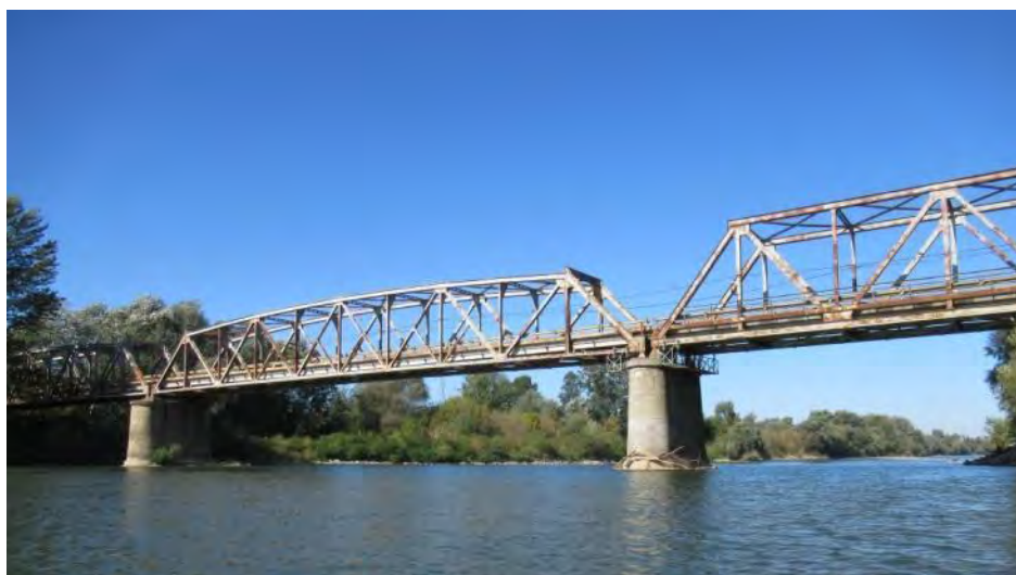
изглед конструкција са узводне стране
