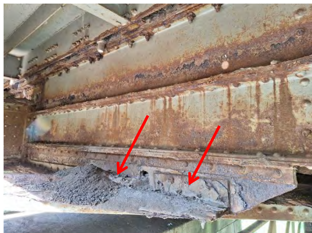
Зона континуитета десног (узводног) подужног носача код попречног носача ПН0 - дубинска корозија доњег угаоника, вертикалног лима и заковица на споју угаоника
