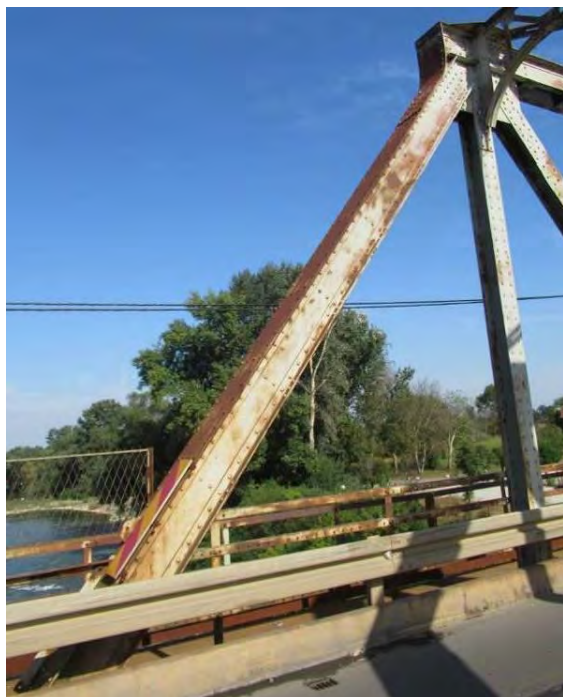
Дијагонале 0-1 левог и десног решеткастог носача конструкције K4
