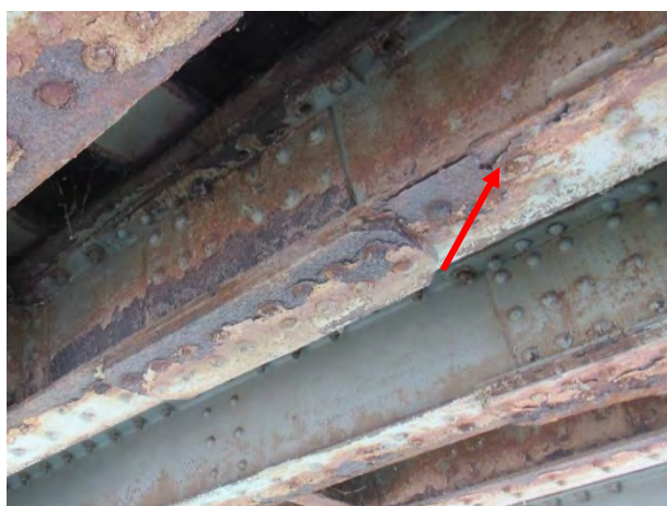
Дубинска корозија доње фланше и губитак попречног пресека носача 3 у пољу 1-2
