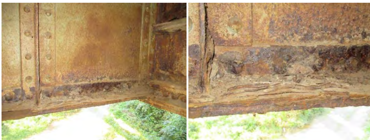
Средњи део ПН4, доњи појас - изражена дубинска корозија са тоталном деградацијом угаоника
