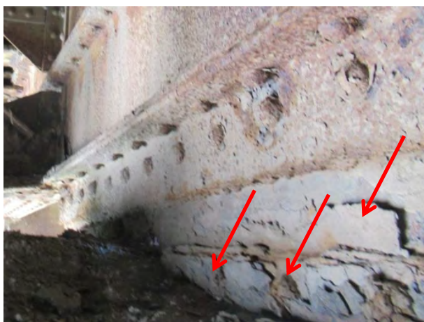
Зона континуитета левог (низводног) подужног носача код попречног носача ПН0 - дубинска корозија доњег угаоника, вертикалног лима и заковица на споју угаоника
