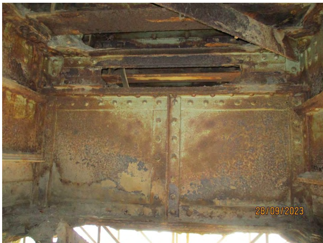
Попречни носач ПНО' - вертикални лим у зони подужних носача захваћен дубинском корозијом
