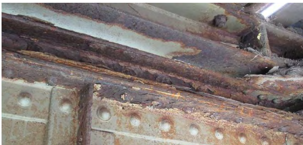
Горњи појасни угаоници, ламеле и заковице у средњем делу попречних носача су захваћени дубинском корозијом, местимично са умањењем основног пресека површине, а локално и са лиснатом корозијом
