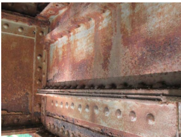
Доње зоне веза доњих подужних носача, унутрашња страна - појачана корозиј
