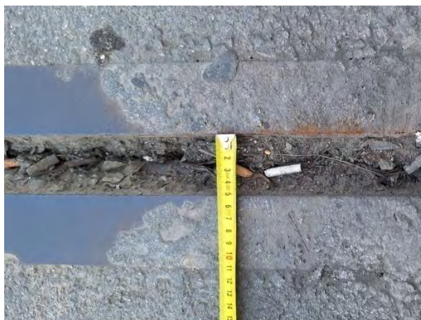
Зазор дилатације
