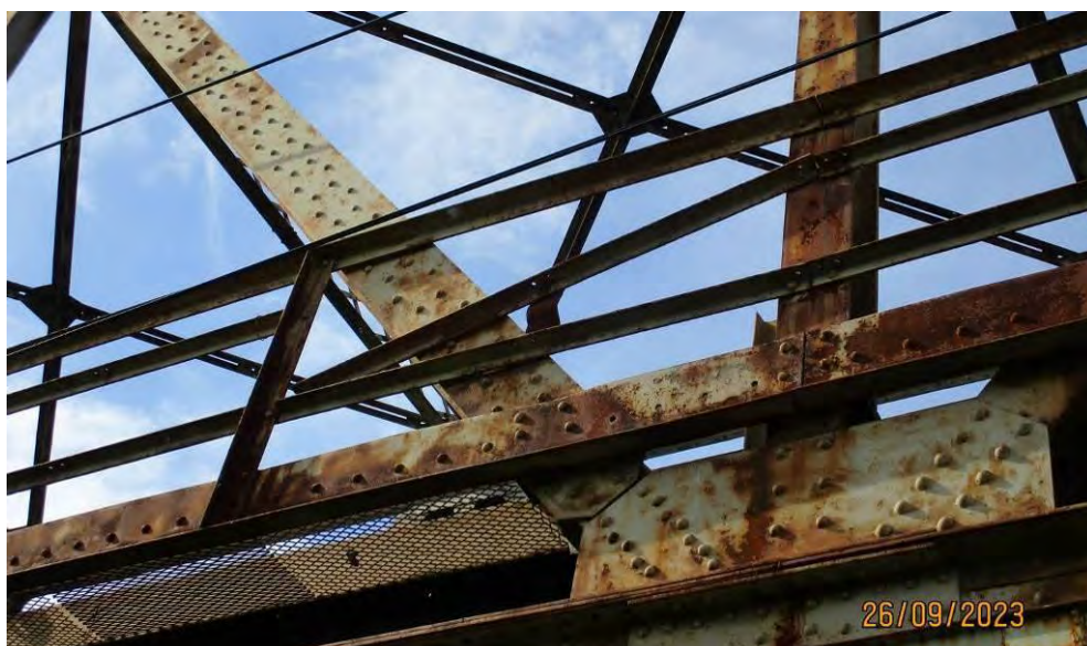
Прекинут горњи коленик десне ограде на конструкцији K4
