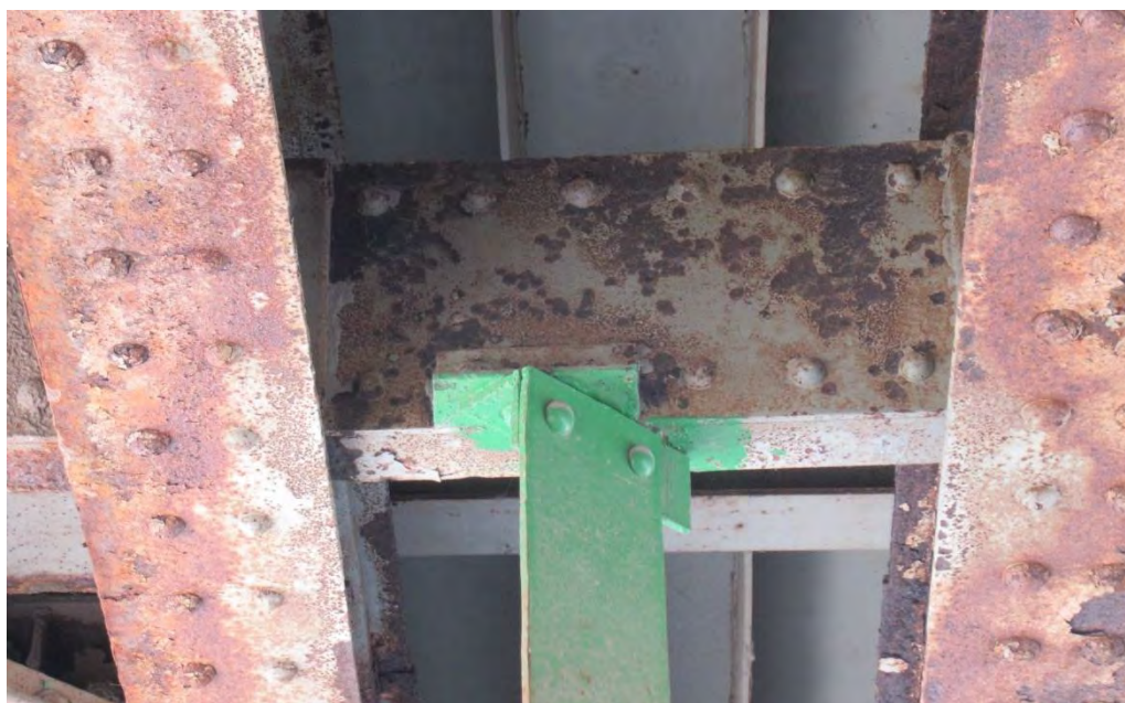
Попречна укрућења подужних носача 2 и 3 и 3 и 4 конструкције К4
