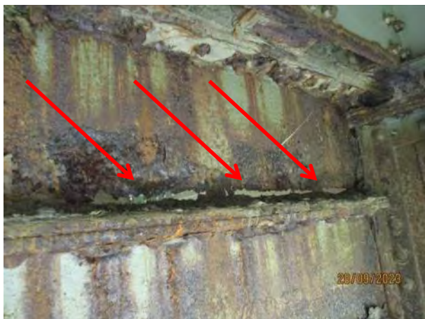
Деградација ребра левог подужног носача у пољу 3-4, дужине око 100ст - прекид везе за доњом фланшом
