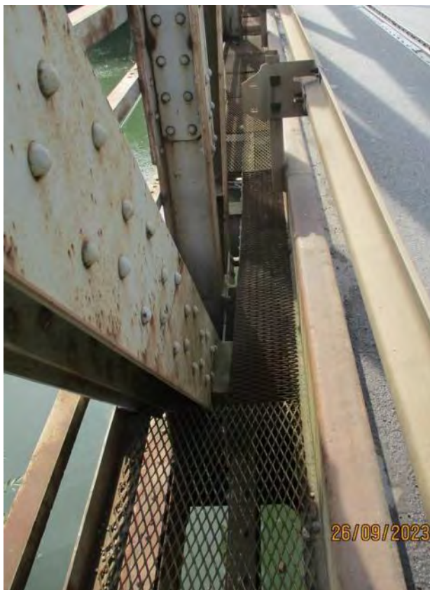
Локална деформација развученог лима на левој страни моста
