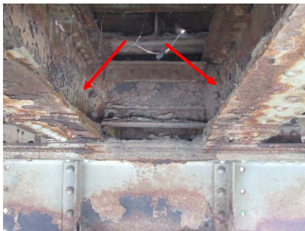
Дубинска корозија и деградација подужног носач- Зона ослањања носача 3 и 4 на попречни носач 5
