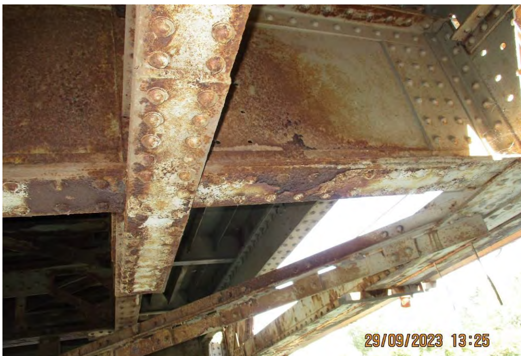
Погледи одоздо на средње делове попречних носача
