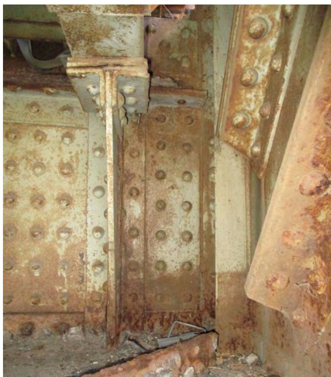
Попречни носач ПНО у зони везе са главним носачима захваћен дубинском корозијом
