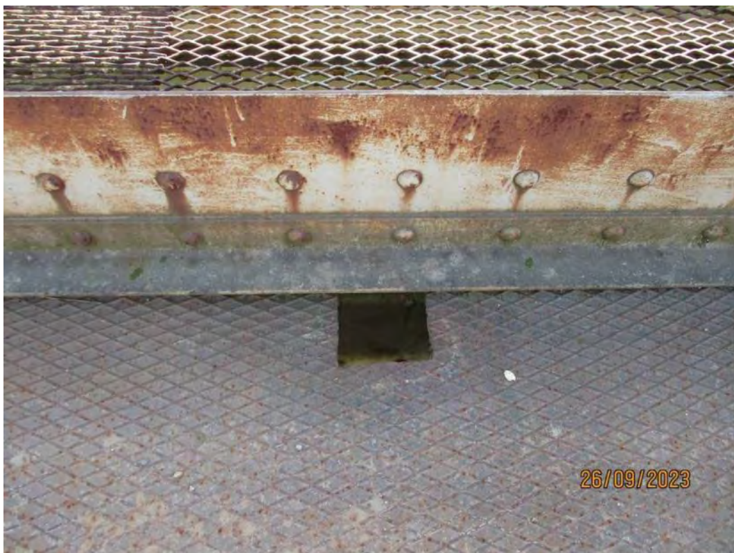
Рупа на газишту уз унутрашњу ограду пешачке стазе на конструкцији К4
