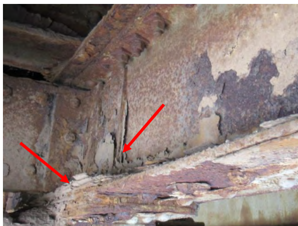
Дубинска корозија и деградација подужног носач- Зона ослањања носача 2 на попречни носач 3'
