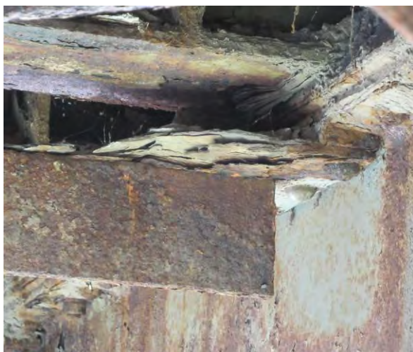
Дубинска корозија са умањењем основног пресека површине чворних лимова спрега за бочне ударе а нарочито у задња два поља где је уочена и лисната корозија
