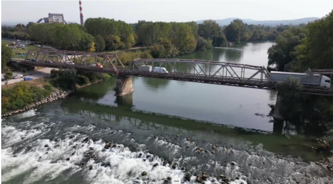
изглед конструкција са низводне стране
