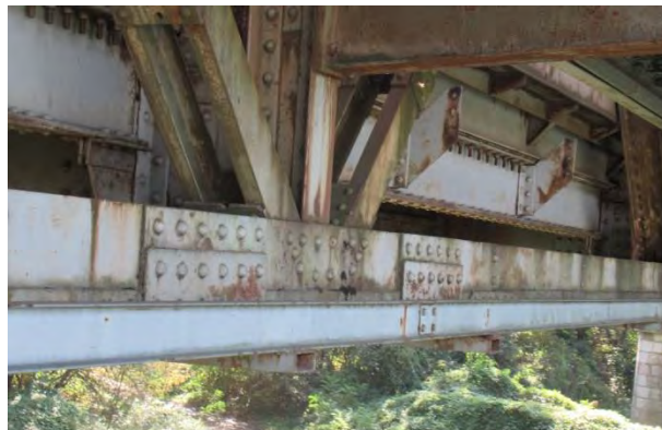
Чворови доњег појаса - генерално у добром стању, захваћени површинском корозијом
