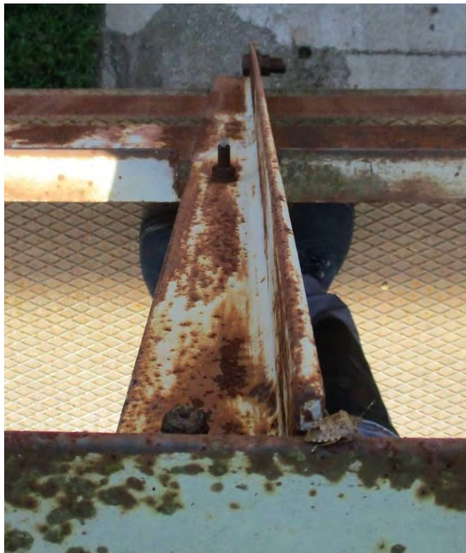
Стуб спољне ограде пешачке стазе везан за подужни носач пешачке стазе
