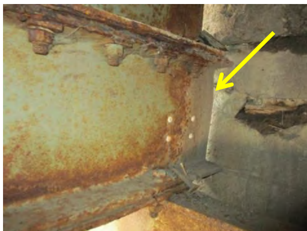
Избочавање ребра левог ивичног носача коловоза
