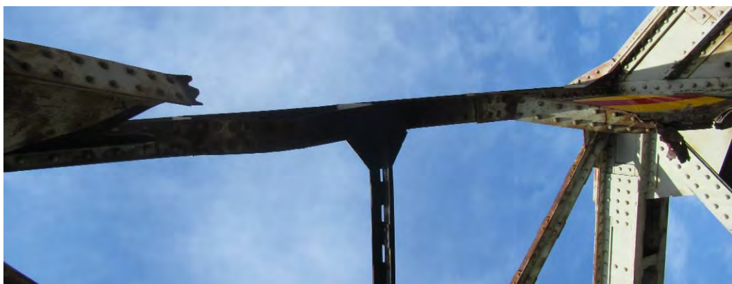
Механичко оштећење десног укрућења улазног порталног рама конструкције К3
