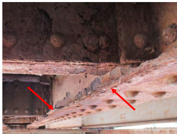
Дубинска корозија доње фланше и губитак попречног пресека носача 2 у пољу 1'-0'
