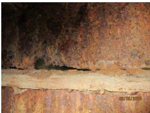
Деградација ребра левог подужног носача у пољу 3-4, дужине око 100ст - прекид везе за доњом фланшом
