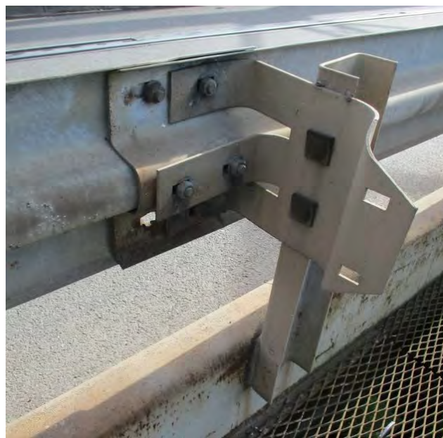
Два искривљена стуба одбојне ограде на левој страни моста
