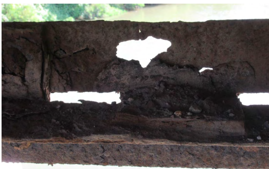
Већа оштећења дијагонала доњег спрега за ветар у пољу 2'-1'
