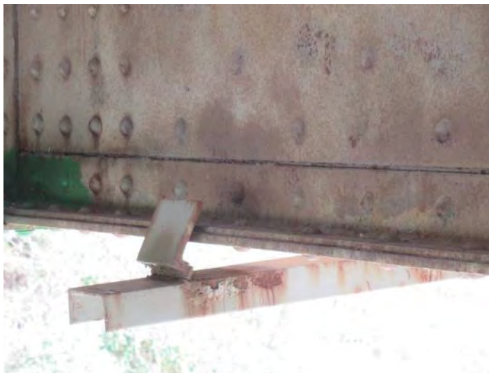
Пуцање везе кратке конзоле као и изражена деформација узводне (десне) шине у пољу 3' - 2' услед ударца возила
