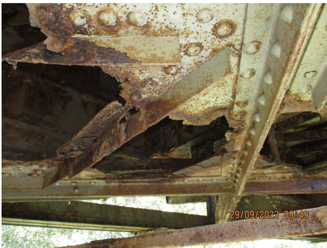
Спрег за кочење у првом пољу конструкције К2
