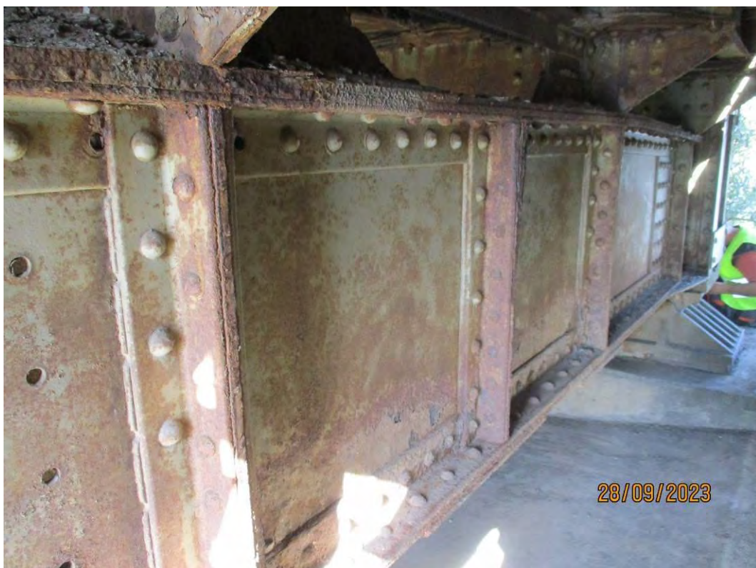
Попречни носач ПНО' - страна ка конструкцији КЗ
