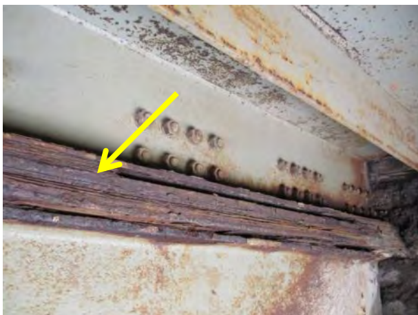
Ортотропна плоча није повезана са средњим подужним носачима
