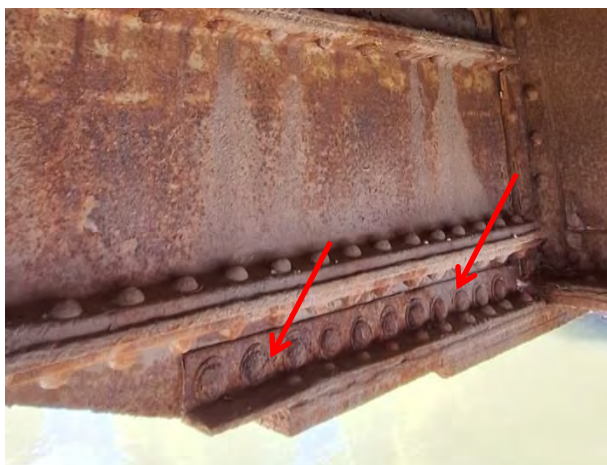
Зона континуитета десног (узводног) подужног носача код попречног носача ПН4 - дубинска корозија доњег угаоника, вертикалног лима и заковица на споју угаоника
