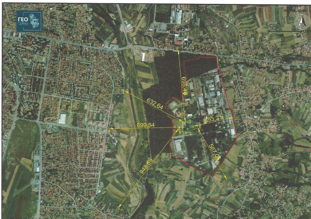
Сл. 5.1 Ближе окружење комплекса предузећа „TRAYAL“ корпорација А.Д. са уцртаном границом постројења „Еко Парк“ на к. п. бр. 37/17 (Извор: https://a3.geosrbija.rs/ )
