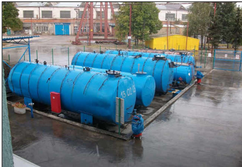
Слика 18. – Резервоари (поз. 15) за складиштење отпадних уља смештени у танквани (поз. 13)
