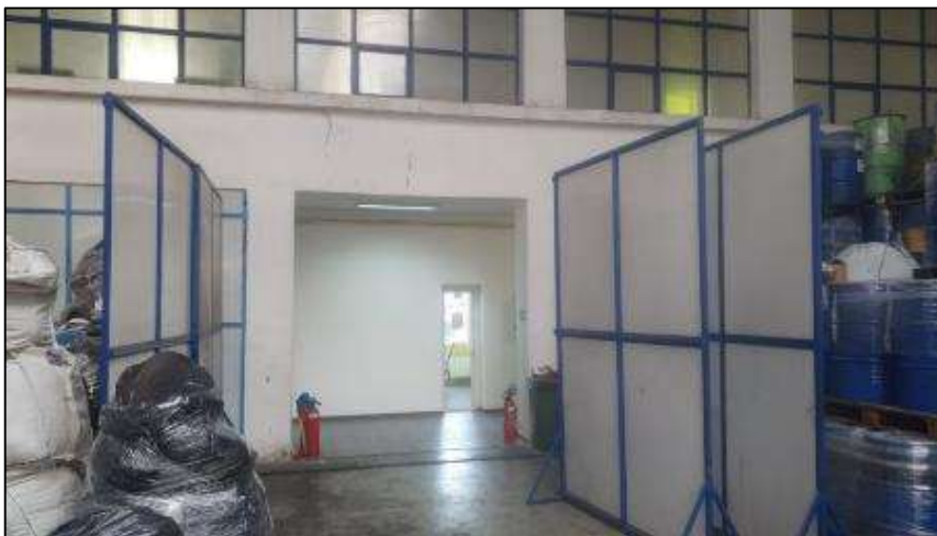
Слика 20. – Пролаз у складиште за запослене у приземљу анекса-1 и галерија на I спрату анекса-1 (поглед из складишта)
