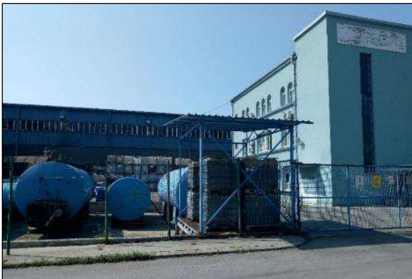
Слика 19. – Ограђени простор за привремено одлагање ИВС контејнера са течним опасним отпадом (поз 14), такође обезбеђен бетонском танкваном (поз 13.)
